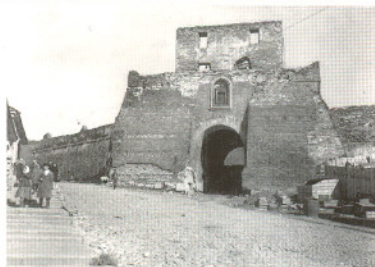
Фото № 6. Ивановская башня до реконструкции
