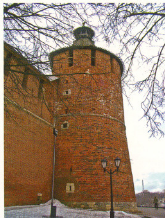
Фото № 13. Тайницкая башня после восстановления
