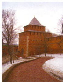
Фото № 5. Ивановская башня Нижегородского кремля после реконструкции
