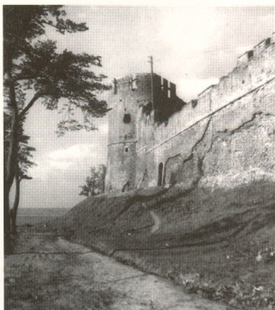
Фото № 12. Тайницкая башня до реставрации
