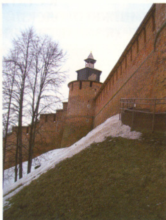
Фото № 9. Часовая башня после реконструкции
