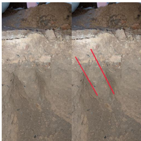
Рис. 5. Пример химической свай
