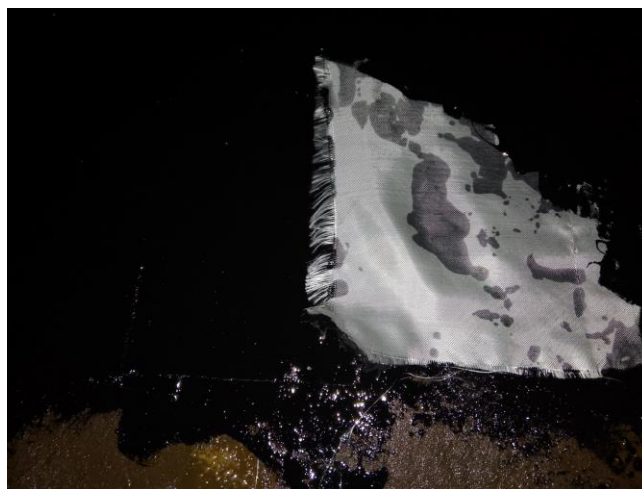
Рис. 6. Нанесение полимерного слоя через упрочнение стеклотканью
