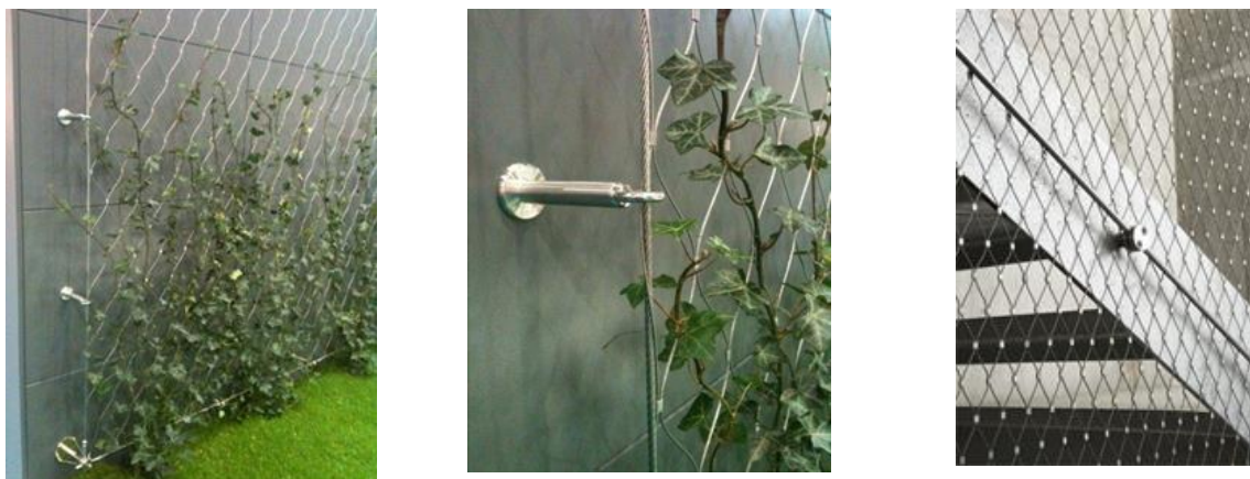
Рис 1. Пример конструкции проволочной сетки для вертикального озеленения (проволочная сетка Webnet компании Jakob Rope Systems)
