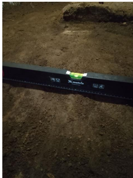
Рис. 4. Грунтовое основание тропы
