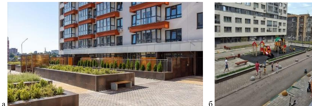
Рис.4. Стационарная зеленая карта линейного типа на кровле подземного паркинга ( а - ЖК «Панин», г. Нижний Новгород, Советский район, б – ЖК по ул. Невзоровых, г. Нижний Новгород, Советский район [2])
