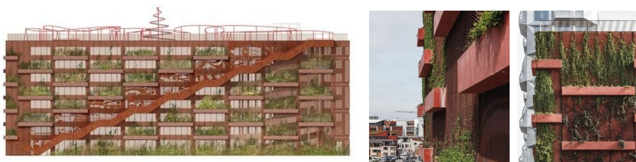
Рис.1. Контейнерное озеленение фасада здания в проекте Park 'n' Play
