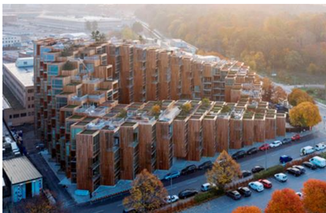
Рис. 5. Многоквартирный дом «79 & Park» (2018) — Стокгольм, Швеция
