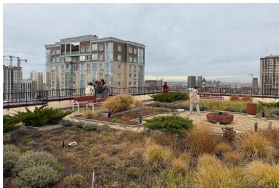
Рис. 10. Озеленённая кровля 17-ый этаж, вид на город
