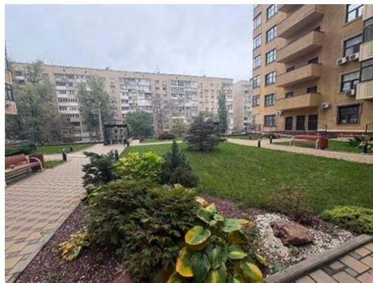
Рис. 6. Северная озеленённая кровля 2-ой этаж вид со стороны входной группы
