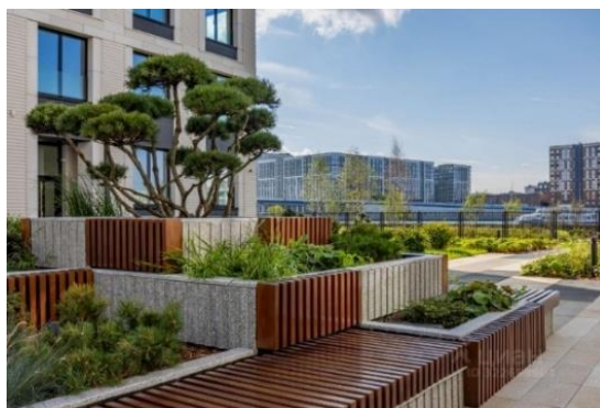
Рис.8. Ступенчатая конструкция пирамиды на кровле подземного паркинга для посадки деревьев, кустарников и устройства сиденья. Санкт-Петербург, ЖК бизнес класса «Grand View»
