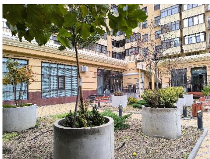
Рис. 11. Озеленённая кровля, 1-й этаж, вид на жилой комплекс
