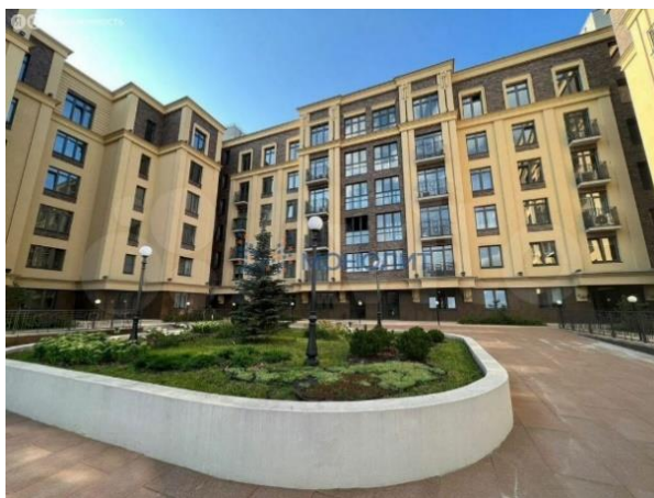
Рис. 4. Фото с эксплуатируемой кровли ЖК «Шаляпин» (2025 г.)
