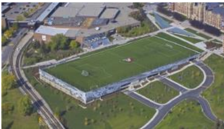
Рис. 4. Футбольное поле на кровле трёхуровневого паркинга у Технологического института в Канаде
