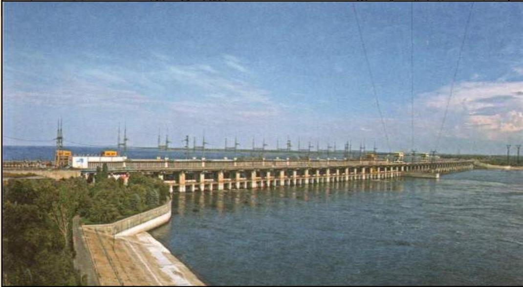
Вид со стороны нижнего бьефа на здание ГЭС и водосливную плотину ( $59500 \text{ м}^3/\text{с}$ ). **Красная точка на плане – стоянка фотографа.** Судоходный шлюз, расположенный ближе к левому берегу, на снимке не виден.
