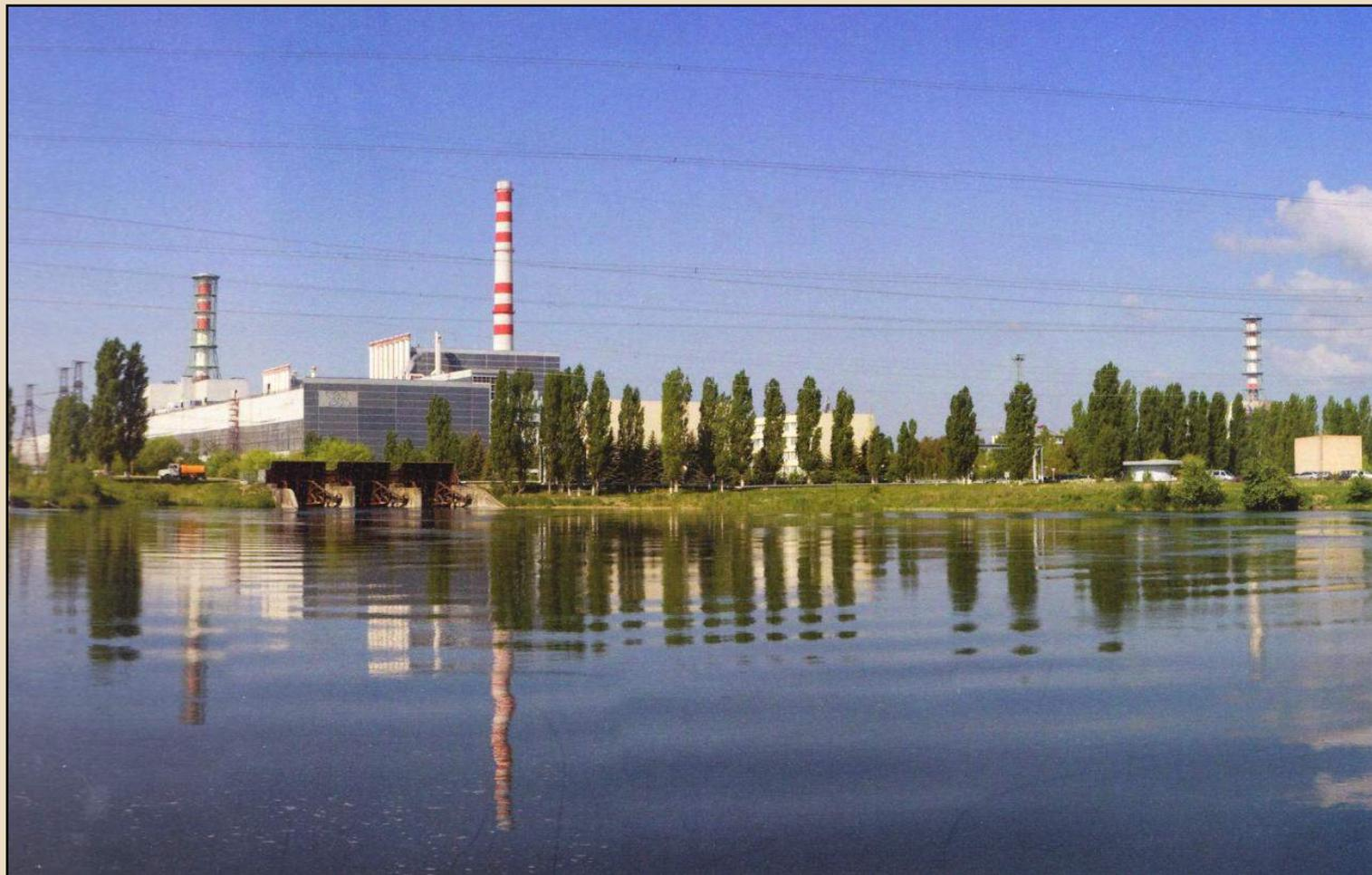
Наливное водохранилище Курской АЭС в пойме р. Сейм (приток р. Десны, впадающей в р. Днепр): введено в эксплуатацию вместе с первым блоком АЭС в 1976 г.; полная емкость 94,6 млн. м<sup>3</sup>; площадь зеркала 21,46 км<sup>3</sup>; наполняется водой из реки
