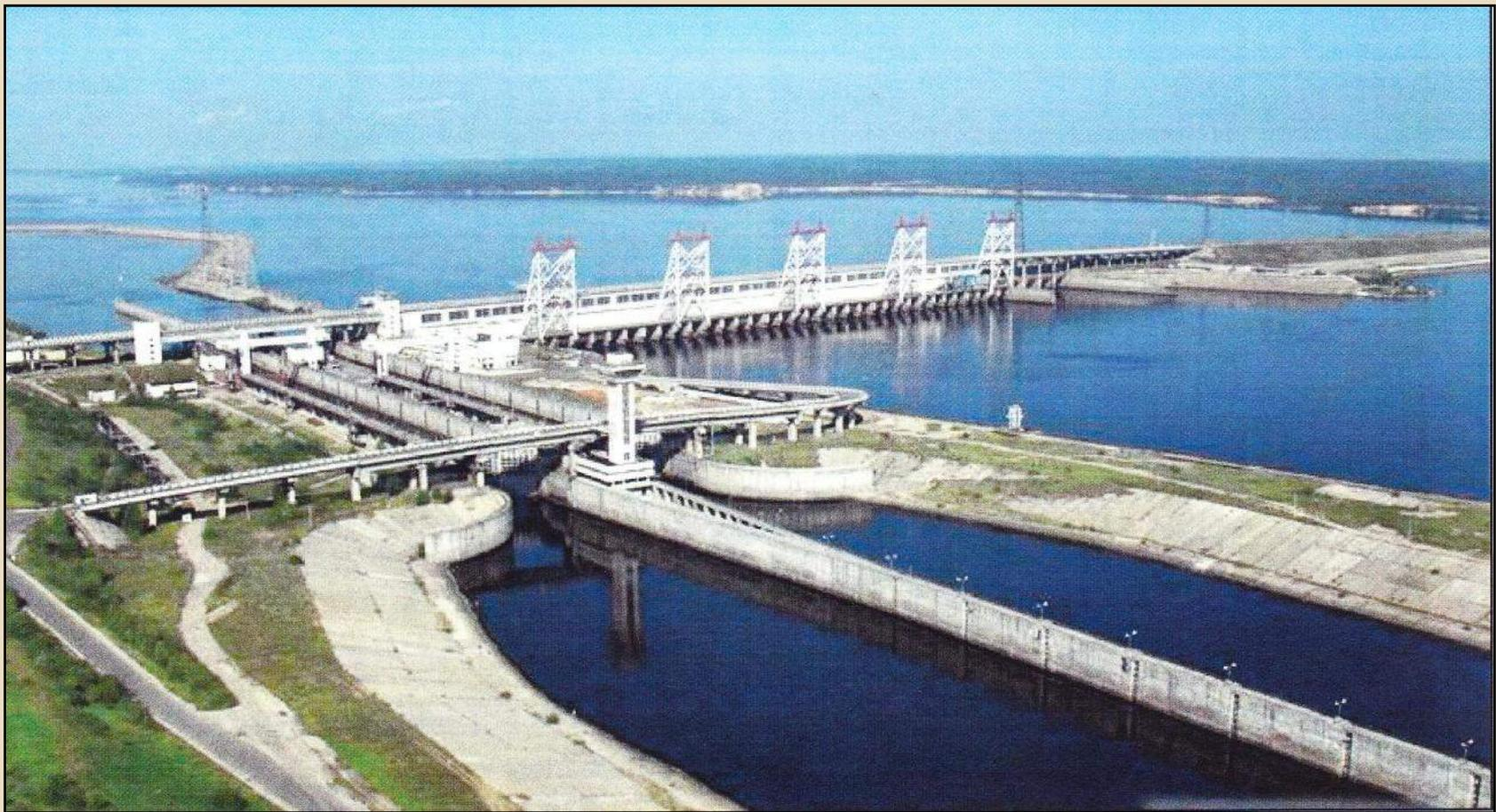
Чебоксарский гидроузел на р. Волге последний по времени пуска в Волжско-Камском каскаде. Вид с правого берега нижнего бьефа. Слева направо: судоходный шлюз, здание ГЭС, водосливная плотина, земляная плотина. Напор 18,9 м, мощность ГЭС 1370 МВт, объем водохранилища 12,6 км<sup>3</sup> (при проектном НПУ =68,0 м)
