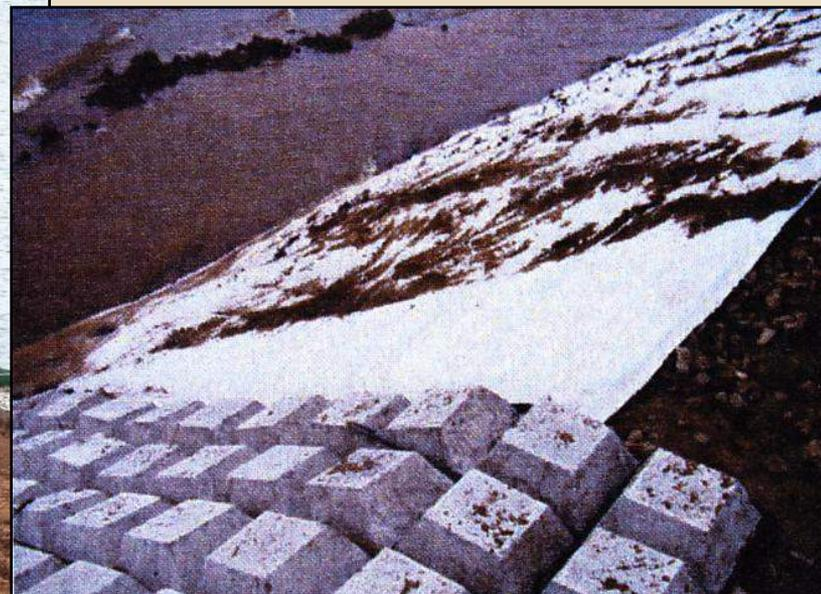
Строительство откосного берегоукрепления Камского водохранилища у с. Посёр из гибких железобетонных тюфяков на слое геотекстиля. 2007 г.
