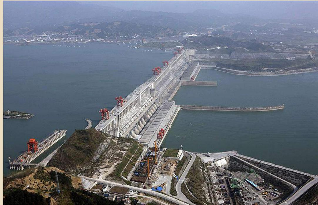
Самая мощная в мире ГЭС «Три ущелья» на р. Янцзы в Китае: введена в эксплуатацию в 2011 г.; плотина бетонная длиной 2331 м и высотой 181 м; напор 113 м; два приплотинных здания ГЭС общей мощностью 22500 МВт
