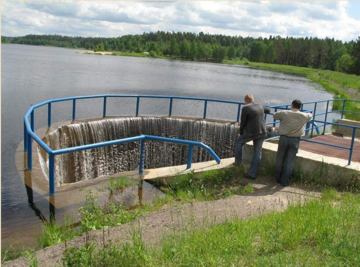
Водохранилище Протяжка на р. Саровке в лесной зоне г. Сарова: гидроузел построен по проекту ННГАСУ в 2001 г.; назначение водохранилища – рекреационное; площадь зеркала 42,3 га; глубина 4,4 м; полный объем 0,75 млн. м<sup>3</sup>
