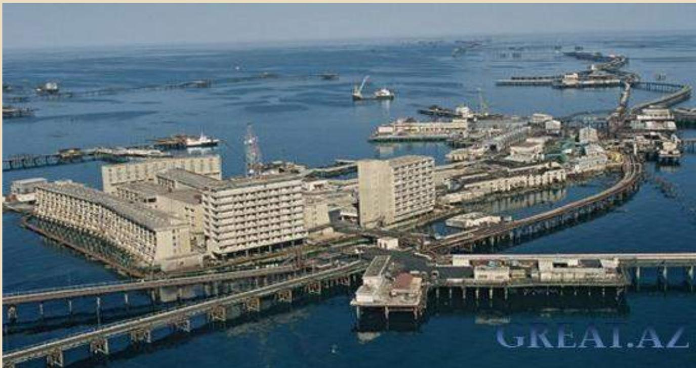
Обустройство нефтяного месторождения на шельфе Каспийского моря у г. Нефтяные камни с использованием эстакад с приэстакадными площадками на сваях (нефтедобыча здесь начата в 1935 г.)
