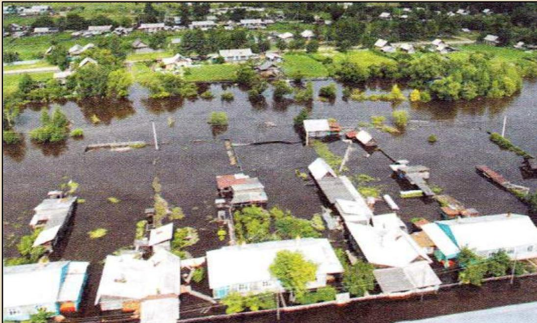
Затопление неконтролируемой застройки в нижнем бьефе Зейского гидроузла при пропуске летнего паводка 2007 г. вероятностью превышения 1 % со сбросным расходом 3500 м<sup>3</sup>/с
