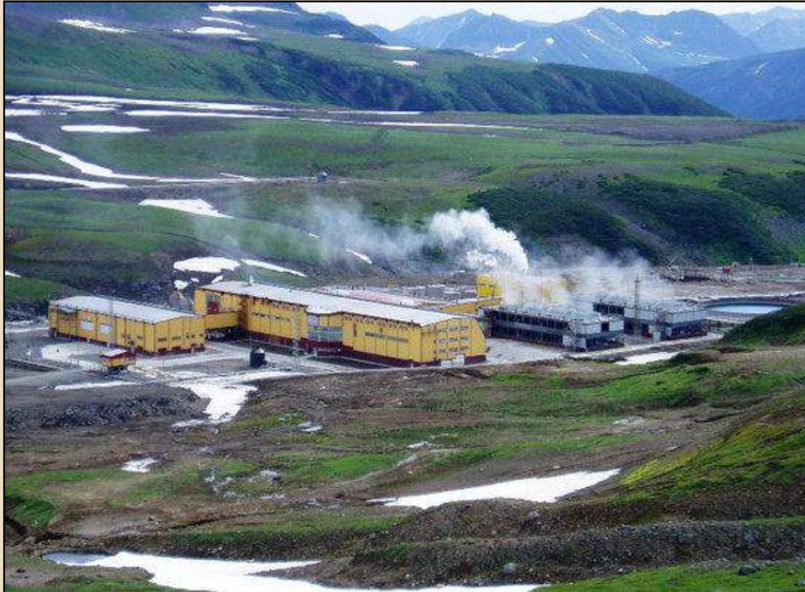
Мутновская геотермическая электростанция на Камчатке: завершена строительство в 2003 г.; мощность 50 МВт; пароводяная смесь с температурой 300°С на станцию поступает из 14 скважин глубиной 900 – 2250 м
