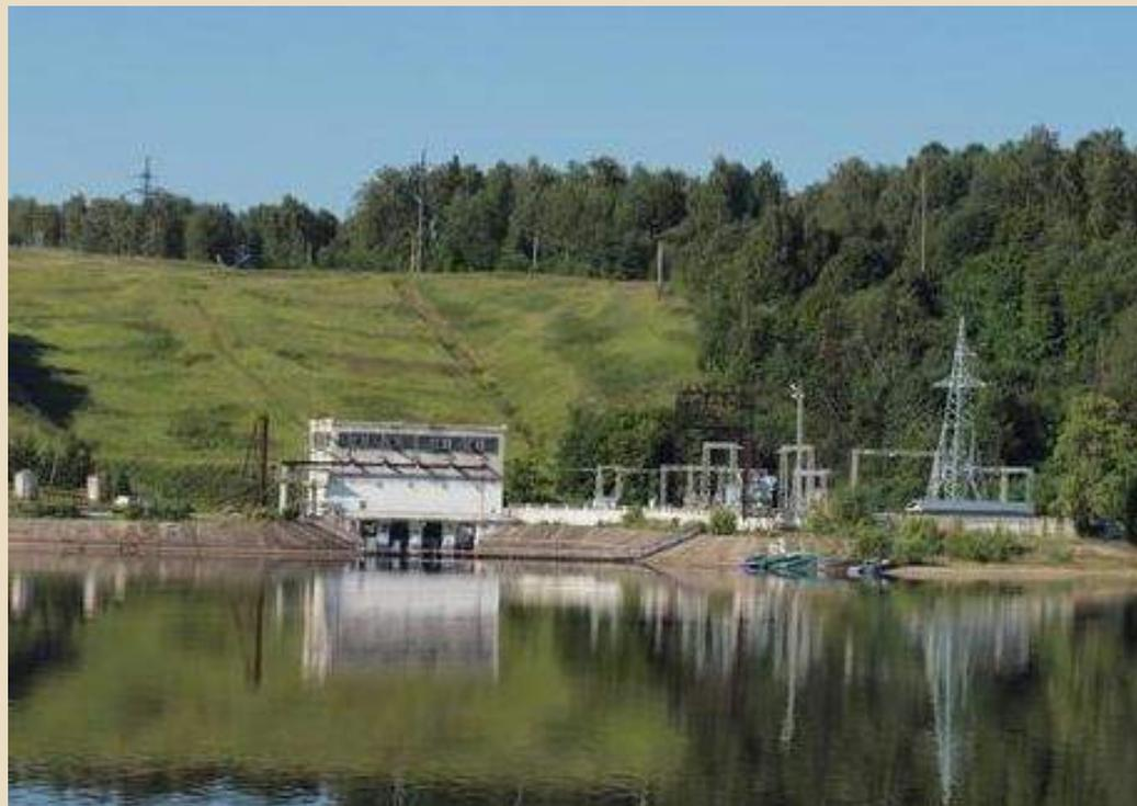
Водозабор на левом берегу р. Волги с подачей воды напорными водоводами на высоту 52 м расходом  $9,6 \text{ м}^3/\text{с}$  в канал Волга - Уводь
