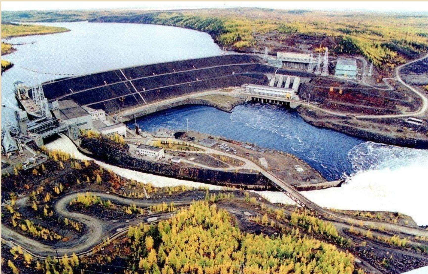
ГЭС – I (на правом берегу) и ГЭС – II (на левом берегу) в Вилюйском гидроузле на р. Вилуй. Соответственно: годы строительства 1961 – 1969 и 1967 – 1976; установленные мощности 308 и 340 МВт
