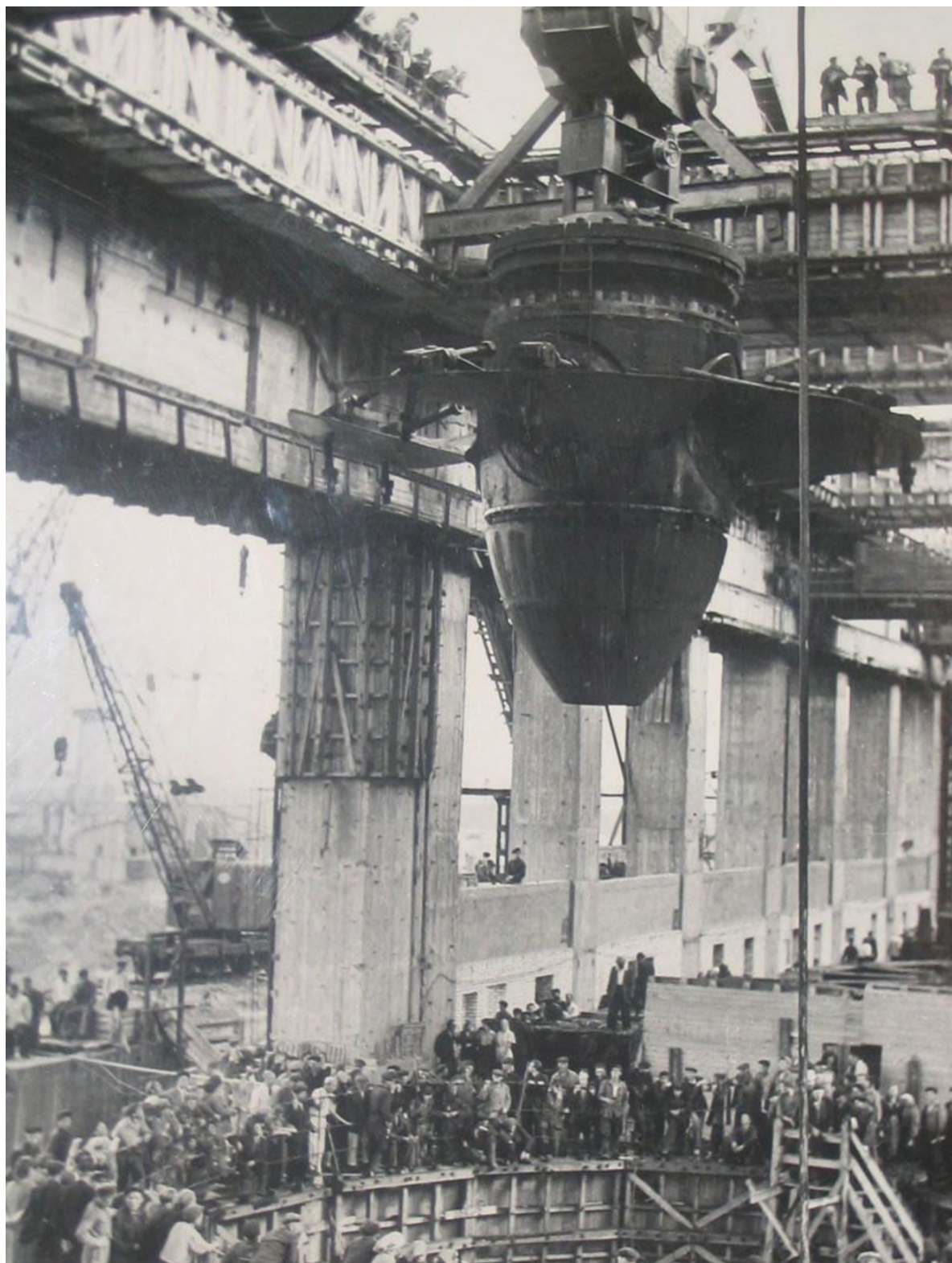
Строительство Горьковской ГЭС. 1954 г.
