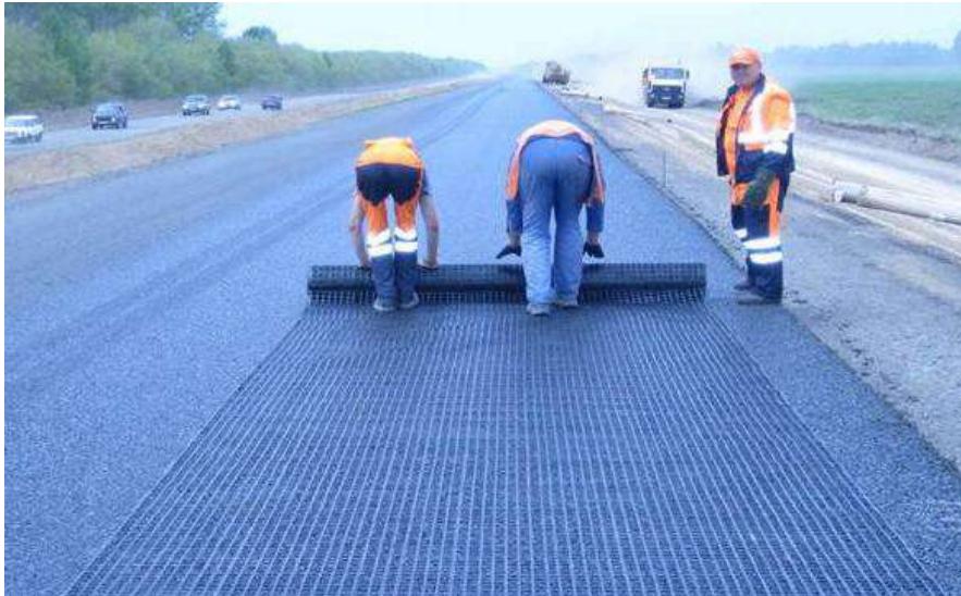
Рисунок 9.2 – Укладка геосетки вручную
