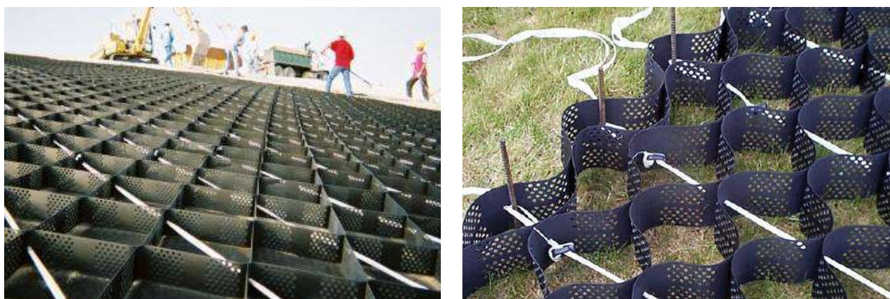
Рисунок 9.45 Анкерно-тросовая система армирования откоса георешетками
