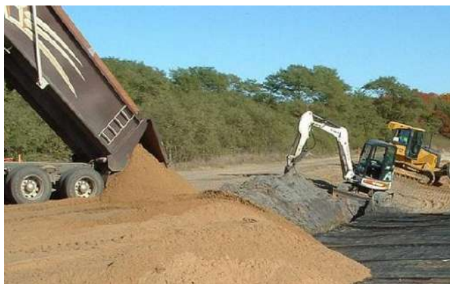
Рисунок 9.11. Разгрузка материала на основание с геосеткой
