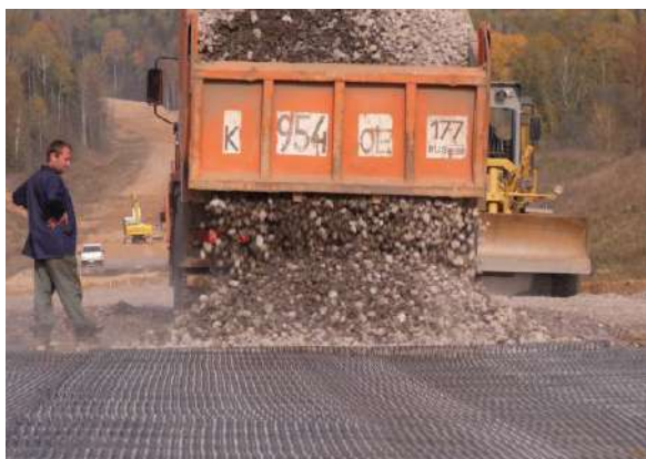
Рисунок 9.11. Разгрузка материала на основание с геосеткой
