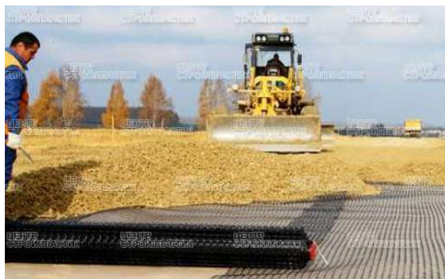
Рисунок 9.11. Разгрузка материала на основание с геосеткой
