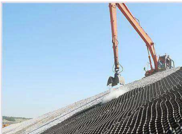
Рисунок 9.46 Засыпка георешетки инертным заполнителем
