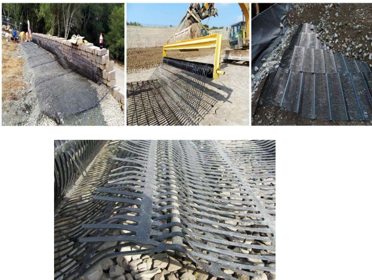
Рисунок 9.49 Установка дополнительной арматуры с применением плоских георешеток
