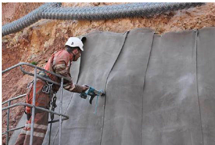
Рисунок 9.48 Крепление геотекстиля к поверхности откоса повышенной крутизны
