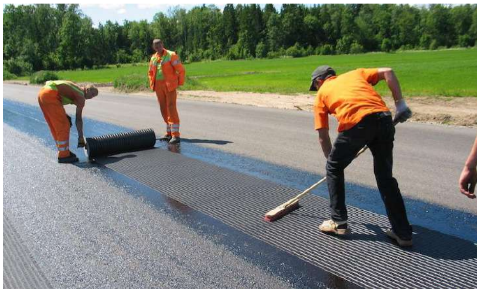
Рисунок 9.5 Выравнивание геосетки с удалением волн на поверхности
