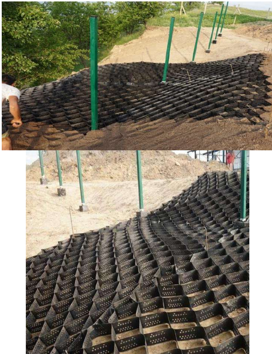
Рисунок 9.27 Предварительная разбивка линий размещения краевых ячеек модулей
