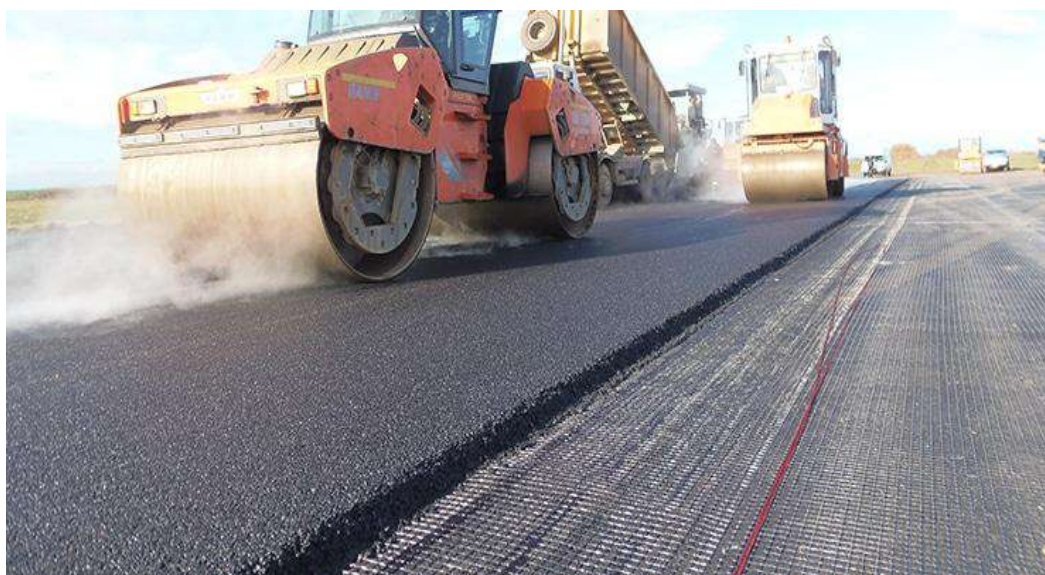
Рисунок 9.6 Крепление геосетки к основанию с помощью дюбелей
