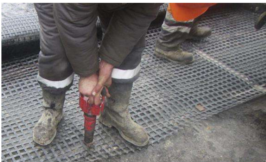
Рисунок 9.5 Выравнивание геосетки с удалением волн на поверхности
