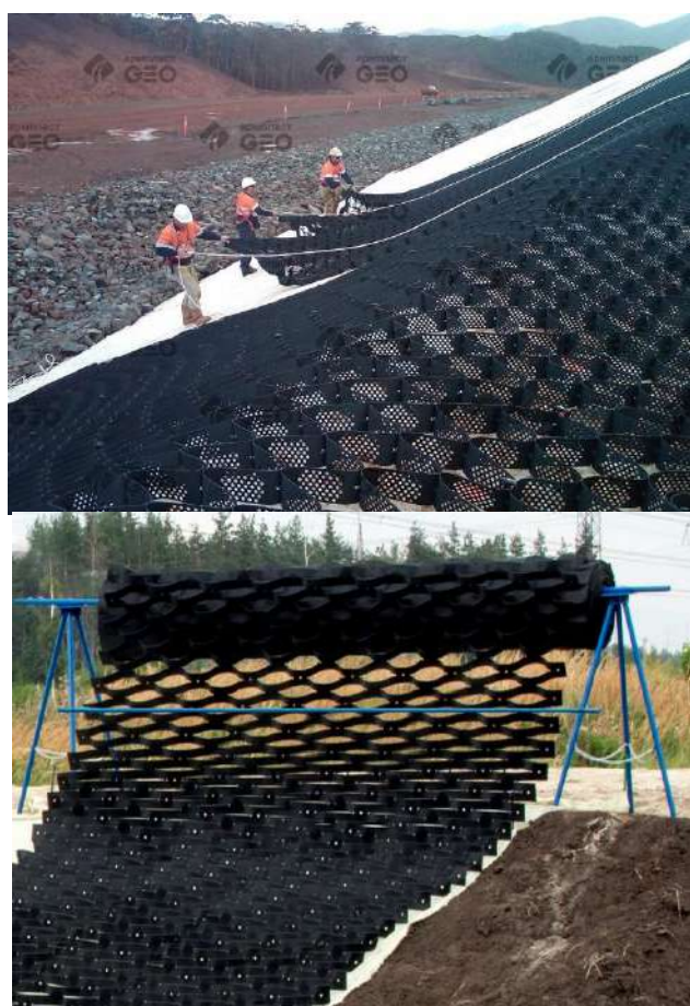
Рисунок 9.29 Натяжение и раскладка георешетки вручную
