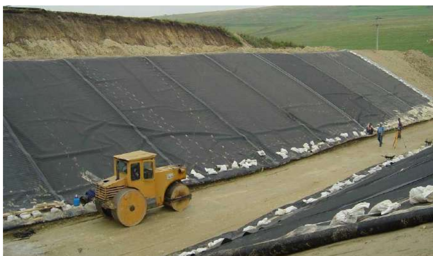
Рисунок 9.53 Пригрузка геомембраны балластом
