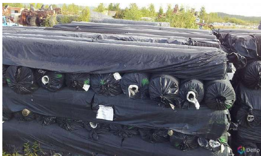
Рисунок 9.13 Складирование и хранение ГМ*
