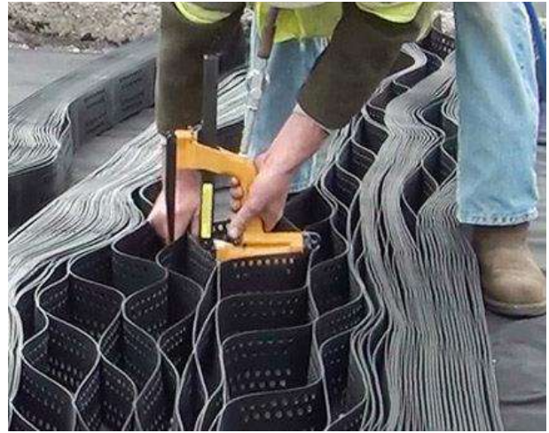
Рисунок 9.37 Соединение смежных секций ГМ*
