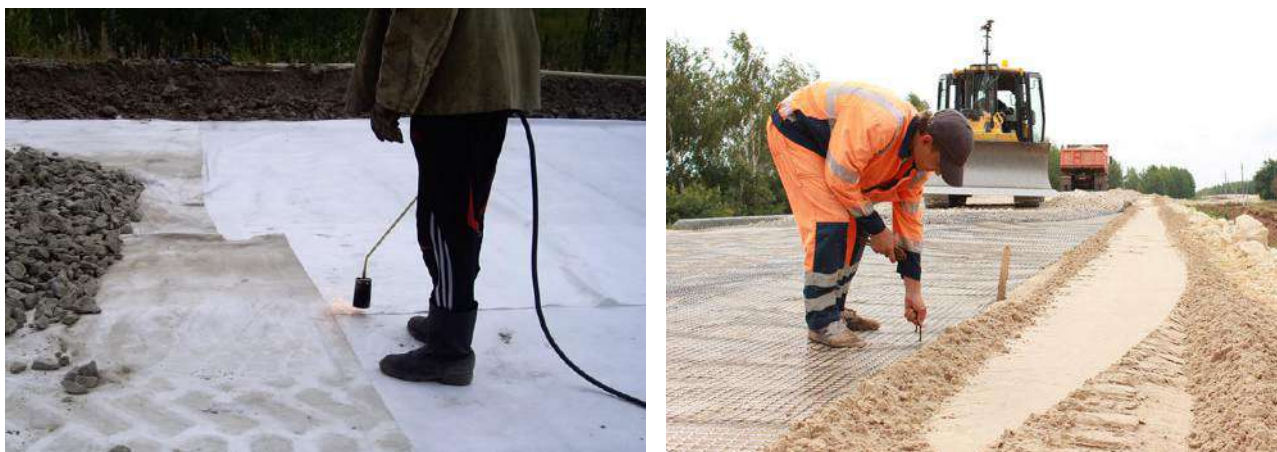
Рисунок 9.24 Сварка стыков газовой горелкой и временное закрепление геотекстиля скобами
