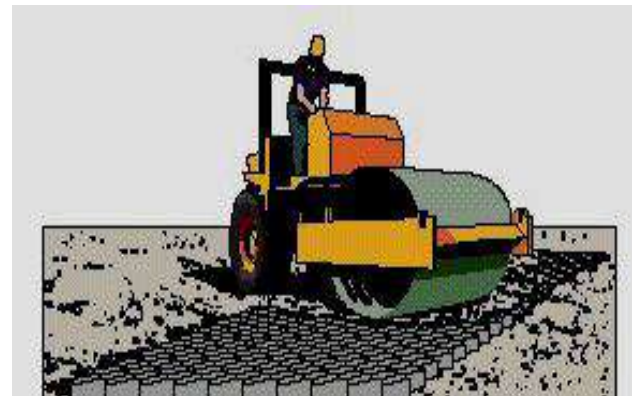
Рисунок 9.46 Засыпка георешетки инертным заполнителем
