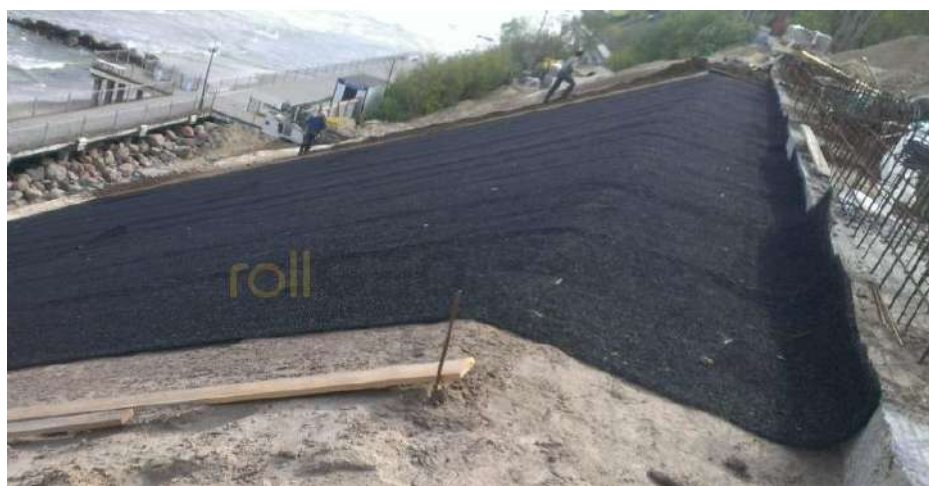
Рисунок 9.14. Заделка ГМ* в верховой анкерной траншее
