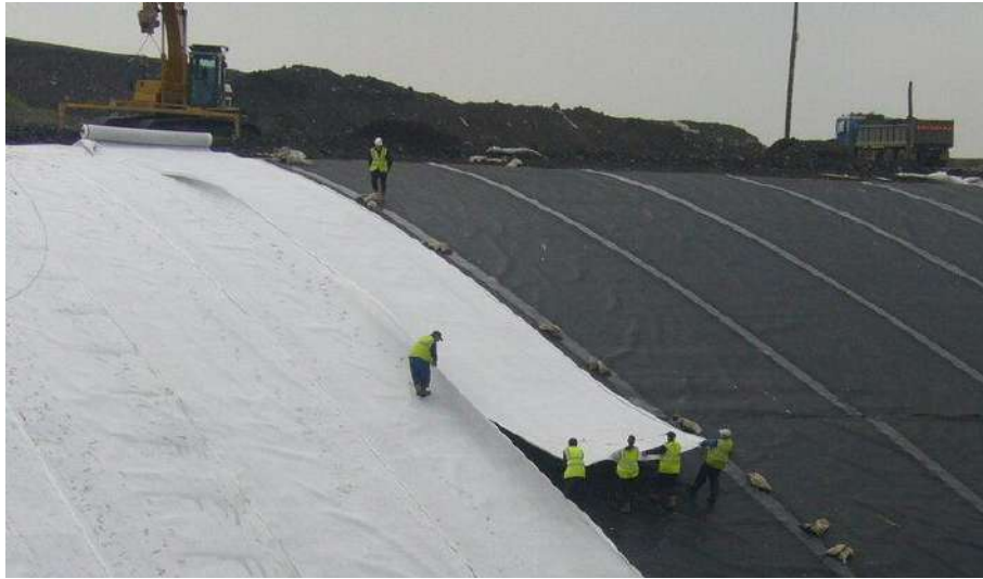
Рисунок 9.17 Поперечная раскатка рулонов ГМ* на откосе
