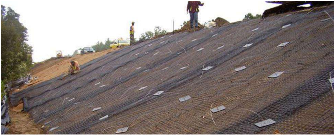
Рисунок 9.20 Пример анкеровки геосетки на поверхности откоса
