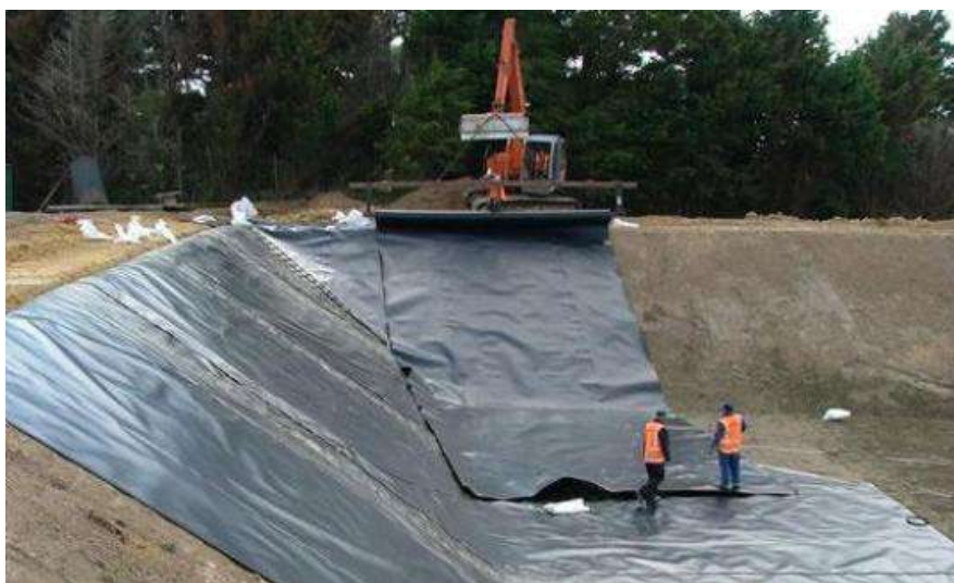
Рисунок 9.52 Укладка геомембраны
