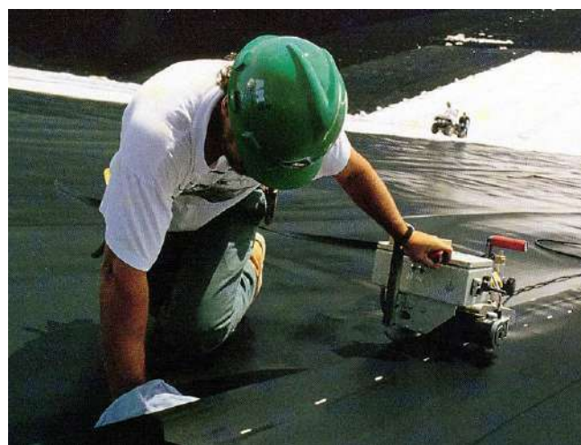
Рисунок 9.56 Сварочный аппарат с клином
