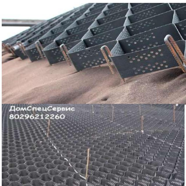
Рисунок 9.28 Закрепление краевых ячеек по ширине и по длине модуля ГМ* анкерами
