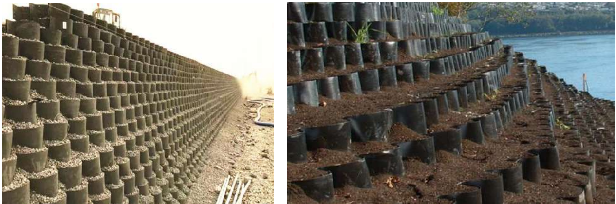
Рисунок 9.51 Подпорные стены с применением геосотовых материалов по окончании работ
