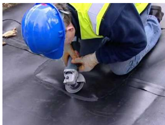
Рисунок 9.54 Установка заплаток
