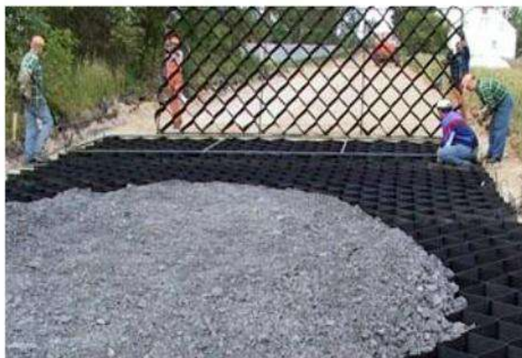
Рисунок 9.33 Монтаж модулей георешетки с помощью натяжной рамы
