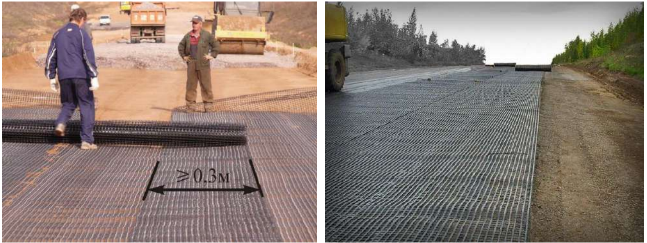
Рисунок 9.8 Укладка ГМ* на основание
