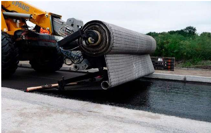
Рисунок 9.3– Навесные механические укладчики для раскладки армирующих материалов
