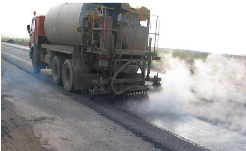
Рисунок 9.1 Подгрунтовка основания
