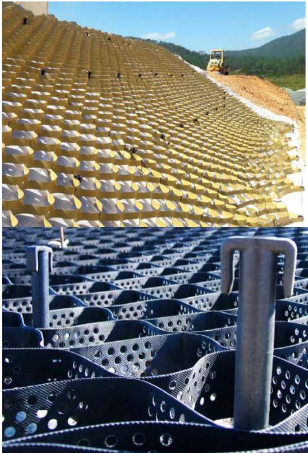
Рисунок 9.36 Примеры установки полимерных анкерных зажимов
