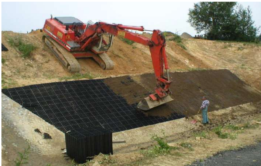
Рисунок 9.21 Надвижка растительного грунта на откосы с ГМ*
