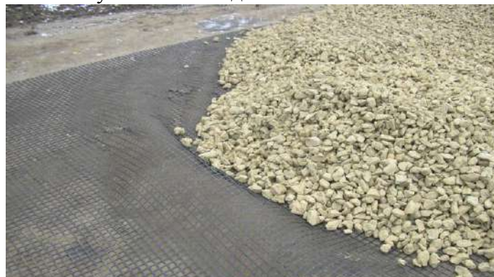
Рисунок 9.8 Укладка ГМ* на основание
