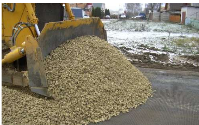
Рисунок 9.11. Разгрузка материала на основание с геосеткой
