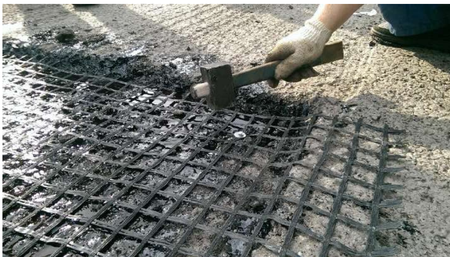
Рисунок 9.6 Крепление геосетки к основанию с помощью дюбелей
