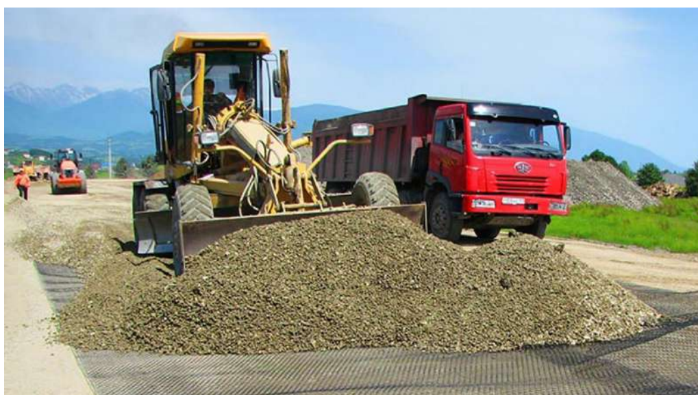
Рисунок 9.12 Разравнивание материала на основании с прослойкой ГМ*
