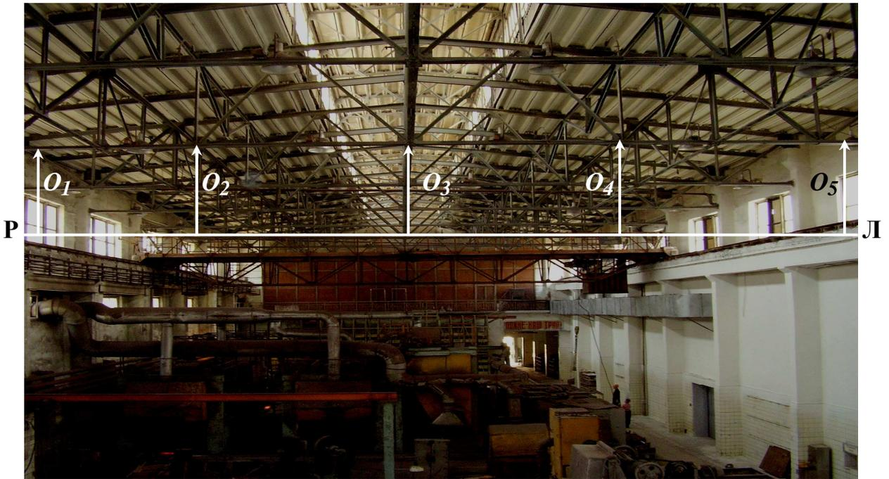
Рис. 109. Схема фотографического способа определения стрелы прогиба
