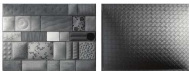
Рисунок 4 – Стены из тканевой опалубки (Источник: [6])
