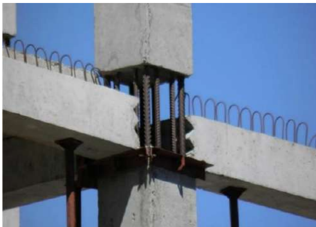
Рисунок 2 – Узел сопряжения колонны с ригелем
