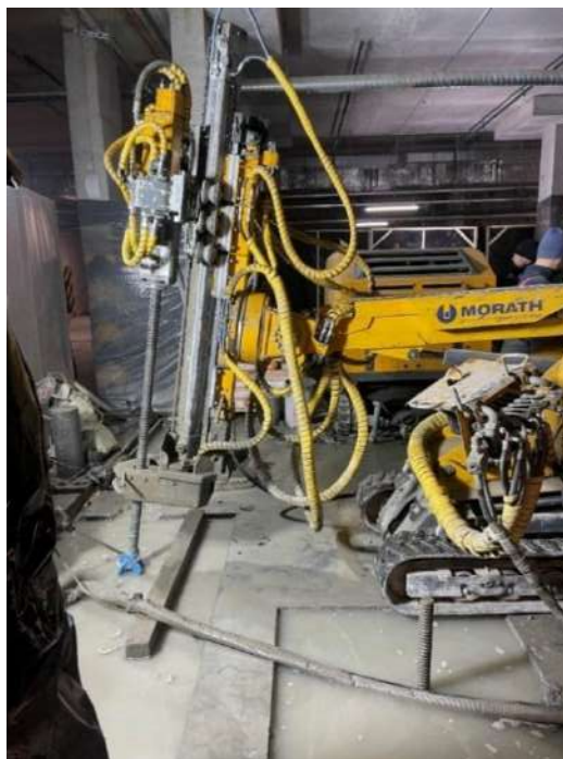
Рисунок 2 – Процесс монтажа анкерных свай в условиях действующего паркинга (Источник: Составлено автором)
