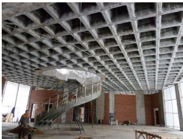
Рисунок 1 – Кессонная плита перекрытия
