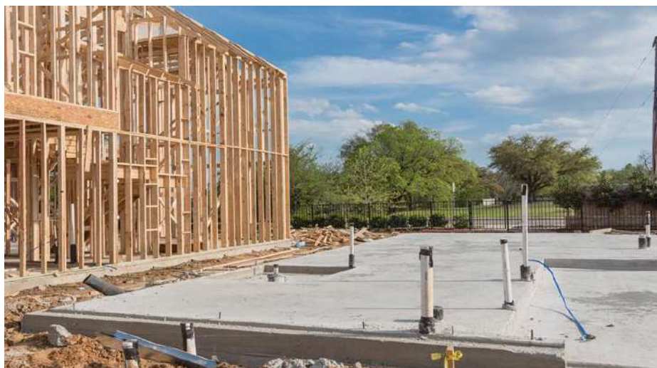
Рисунок 3 – Монолитная железобетонная плита под деревянное здание
