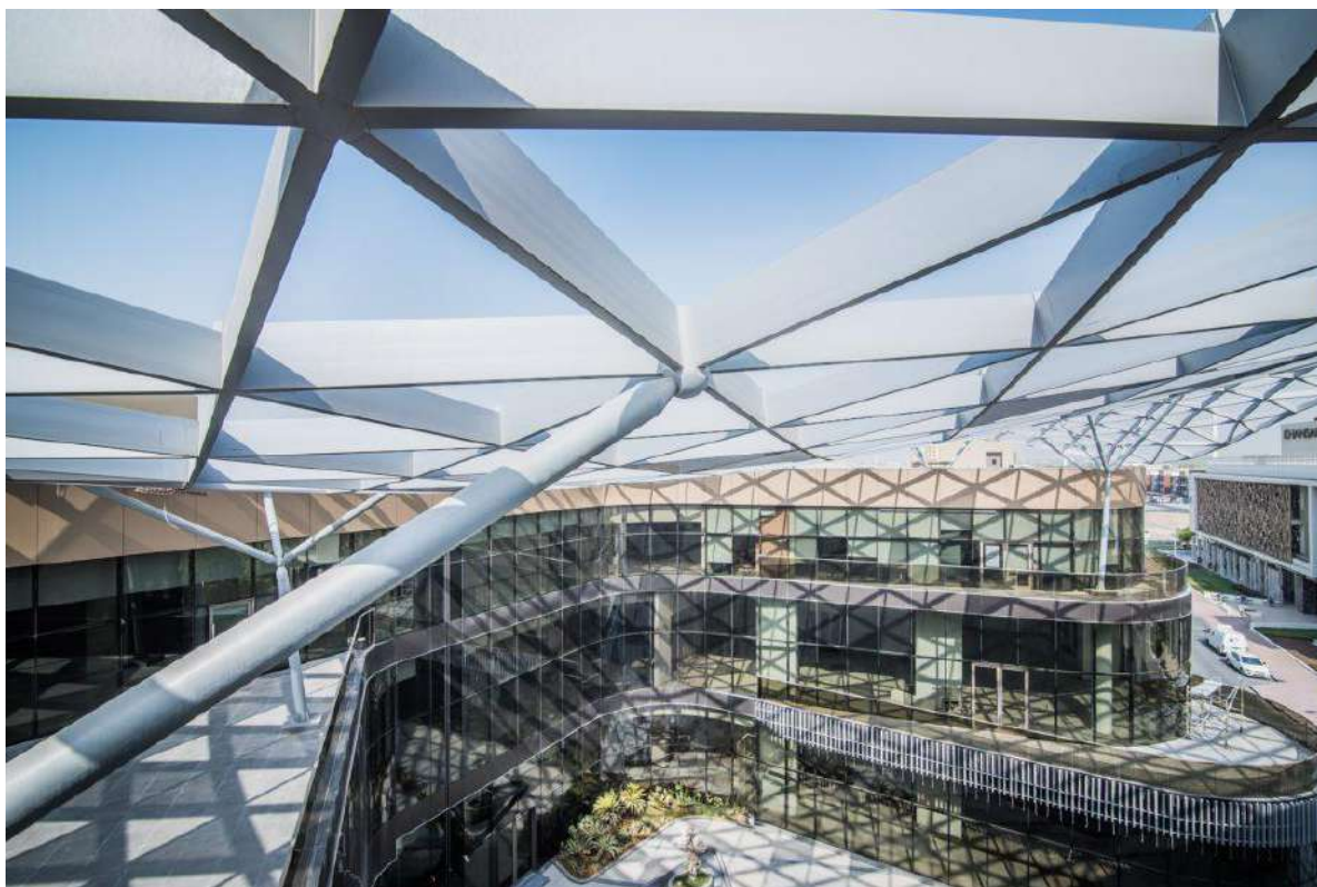
Рисунок 3 – Алюминиевая сетчатая оболочка торгового центра Mirdif Avenue Mall, Dubai (Источник:[7])
