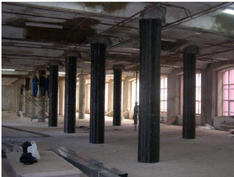
Рисунок 1 – Пример усиления колонны ПКМ
