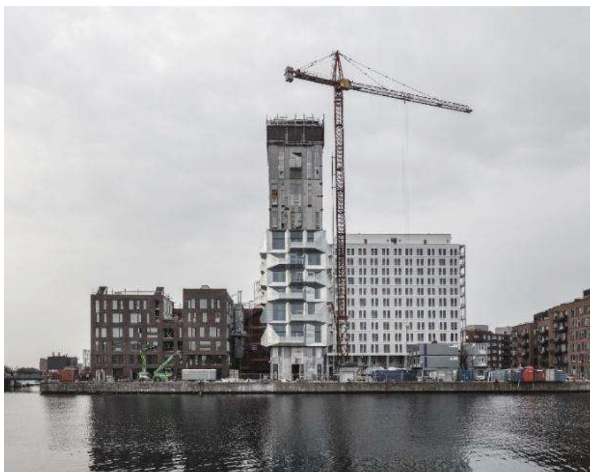
Рисунок 7 – The Silo, Копенгаген
