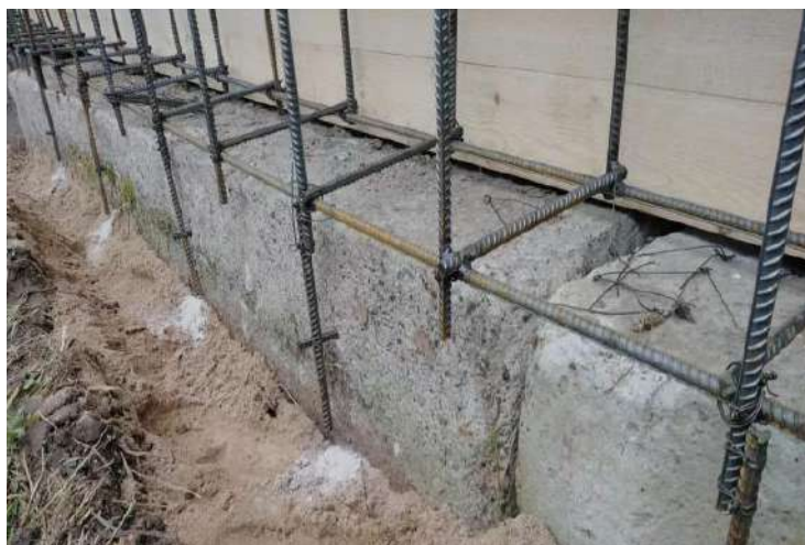
Рисунок 2 – Применение железобетонной рубашки (Источник: [2])
