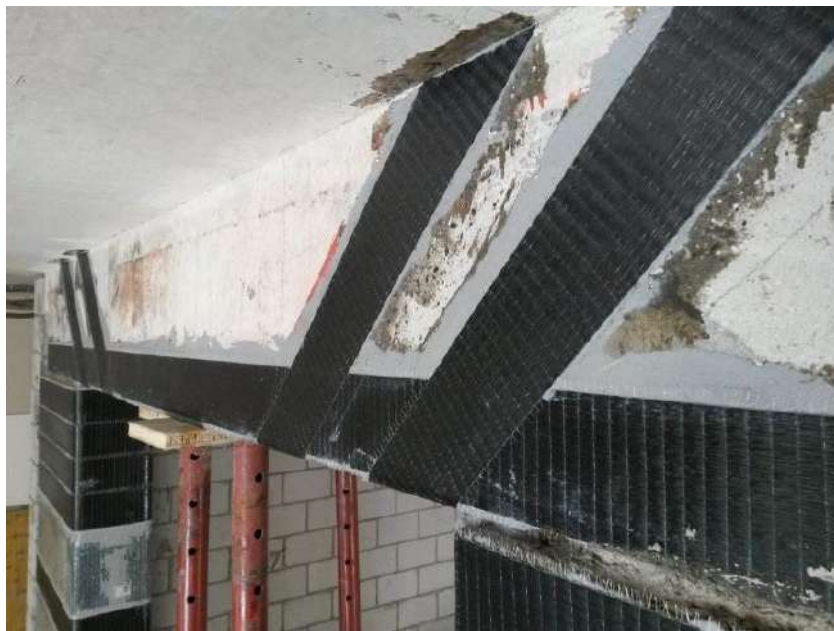
Рисунок 2 – Усиление с использованием углеродного волокна
