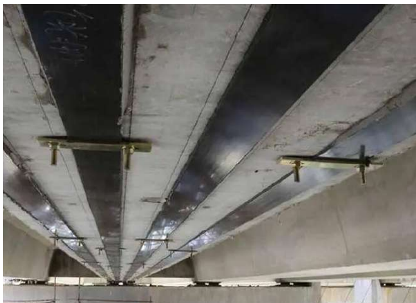
Рисунок 3 – Усиление с использованием углеродных ламинатов
