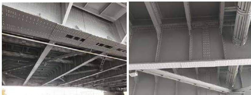
Рисунок 3 – Заклепочные соединения металлических конструкций Крымского моста в Москве (Источник: Составлено автором)
