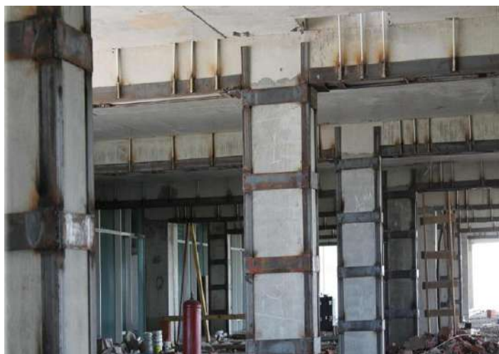
Рисунок 1 – Применение стальной обоймы для усиления железобетонной колонны (Источник: [1])
