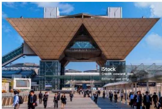
Рисунок 1 – Общий вид на здание [1]
