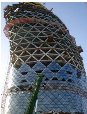
Рисунок 1 – Система Diagrid в процессе строительства Capital Gate
