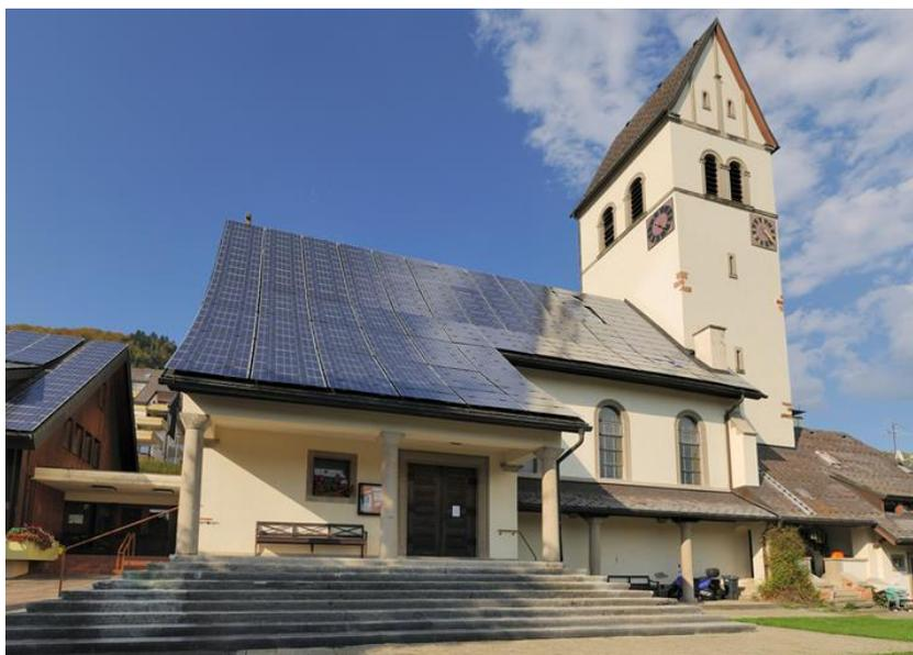
Рисунок 1 – Евангелическая горная церковь в Шёнау (Германия). Церковь оснащена 431 солнечным модулем на кровле и вырабатывает более 40 000 кВт·ч электроэнергии в год, что достаточно для 8 подобных церквей [3]
