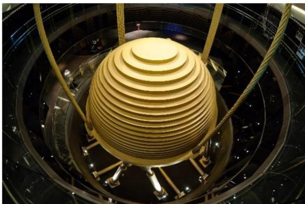
Рисунок 1 – Инерционный демпфер в небоскрёбе Тайбэй 101
