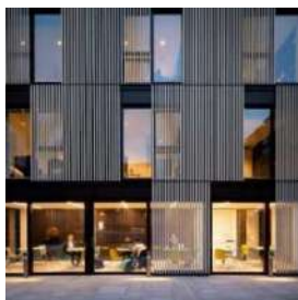
Рис. 5. Фасад офисного здания
