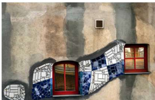
Рис. 2. Окна на фасаде
