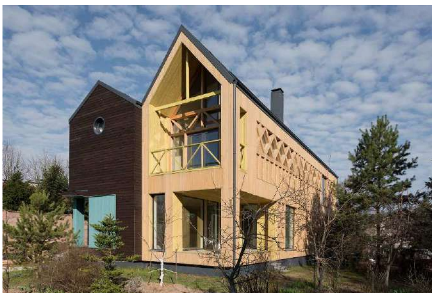
Рис. 10. Жилой дом в Бузаево, общий вид
