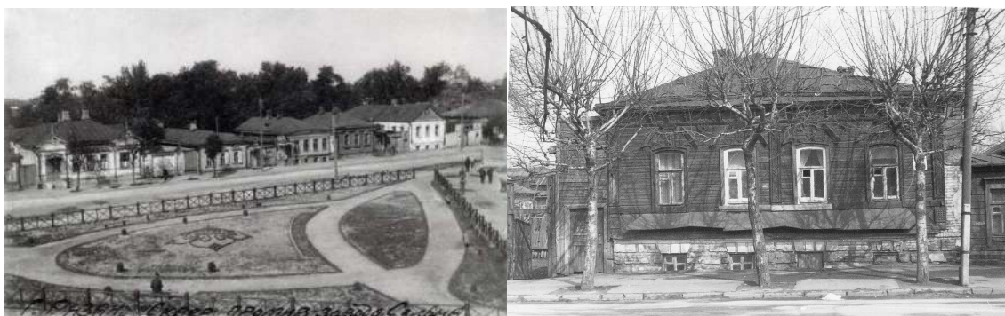
Рис. 5. Элементы несохранившейся исторической застройки улицы Кудрявцева
