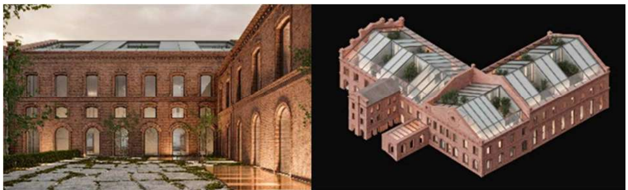
Рис. 3. Архитектурная реставрация здания свечного завода Крестовниковых в Казани
