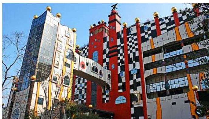
Рисунок 5. Фрагмент оформления фасадов завода Майшима.
