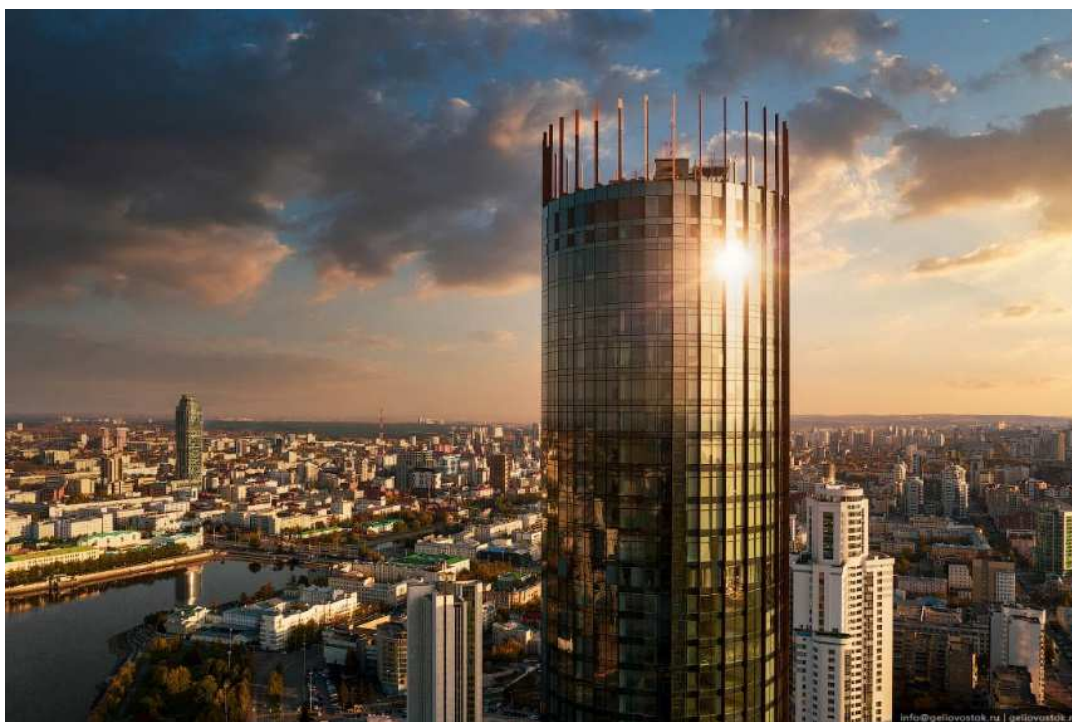
Рис. 3. Корона и остекление фасада
