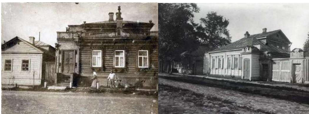
Рис. 4. Фрагменты фоновой застройки улицы Урицкого
