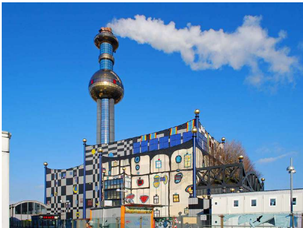
Рис. 1. Мусоросжигательный завод Шпиттелау
