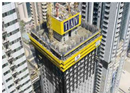
Рис. 4. Самодвижущаяся опалубочная платформа
