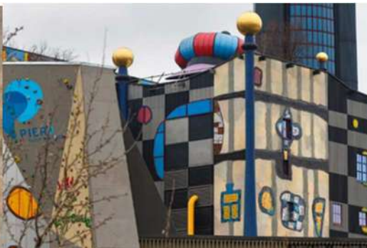
Рис. 3. Окна на фасаде
