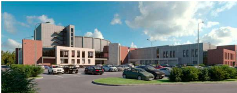
Рис. 9. Вид со стороны парковки. Центр общественной информации Ленинградской АЭС-2
