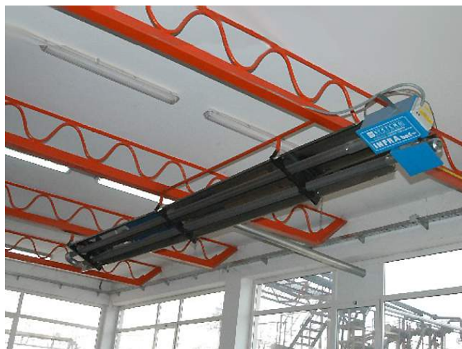
Рис. 6. Газовый инфракрасный излучатель фирмы «Infra»
