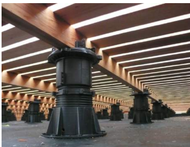
Рис.3. Общий вид винтовых опор Бузон.
