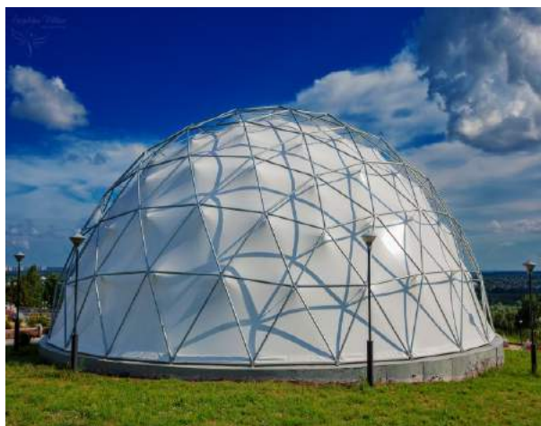
Рис. 1. Здание павильона планетария, г. Новосибирск, 2012 [6]
