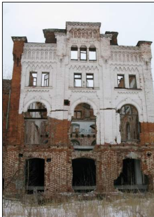
Фото.4. Фрагмент 3-этажной части дворового фасада.
