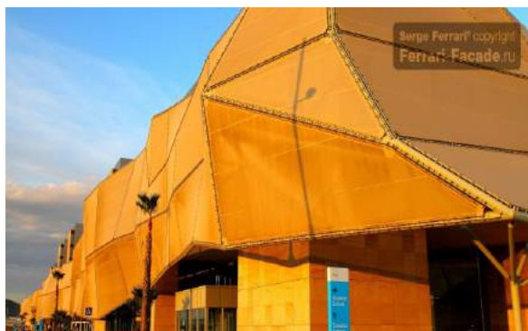
Рис. 4. Здание больницы в г. Картахена, Испания [5]
