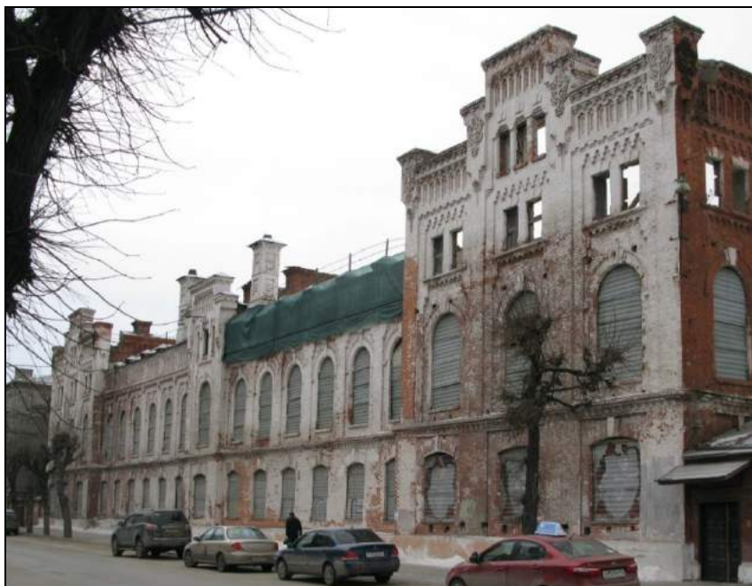
Фото.1. Главный фасад здания вино-водочного завода ко времени проведения обследований.
