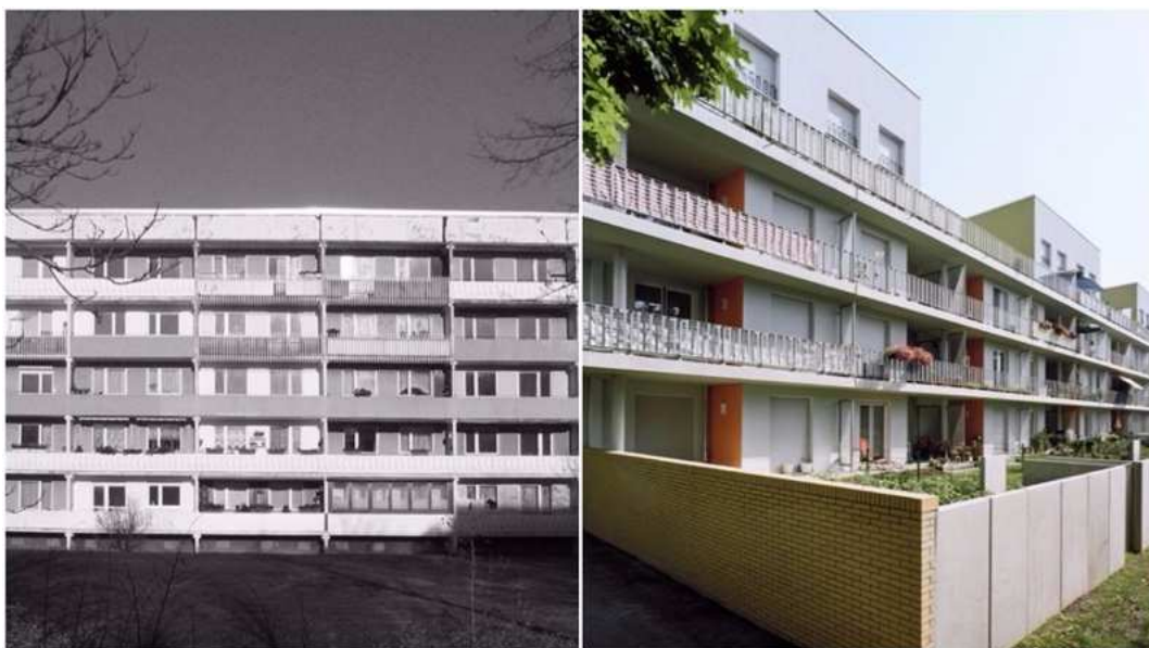
до после Рис. 2 Реконструкция панельных домов в Галле, Германия
