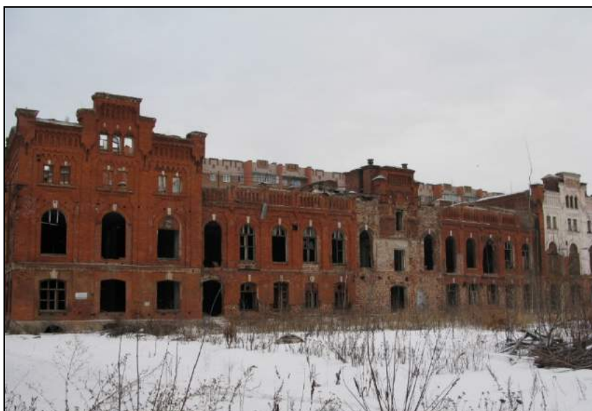
Фото.2.Общий вид здания вино-водочного завода со стороны дворовой территории.
