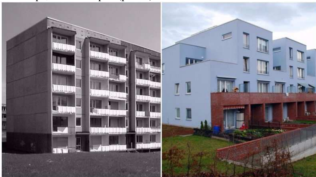
до после Рис. 3 Реконструкция панельных домов в Лайнефельде, Германия
