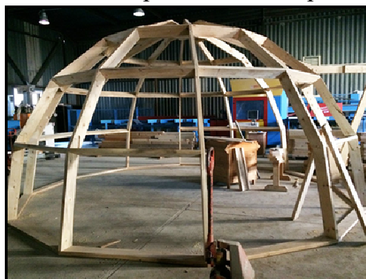
Рис.5 Каркас деревянного купольного дома
