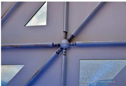
Рис.2 Уникальное узловое крепление сетчатых конструкций фасада
