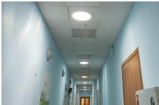
Рис.2. Освещение темного коридора с помощью системы Solautube
