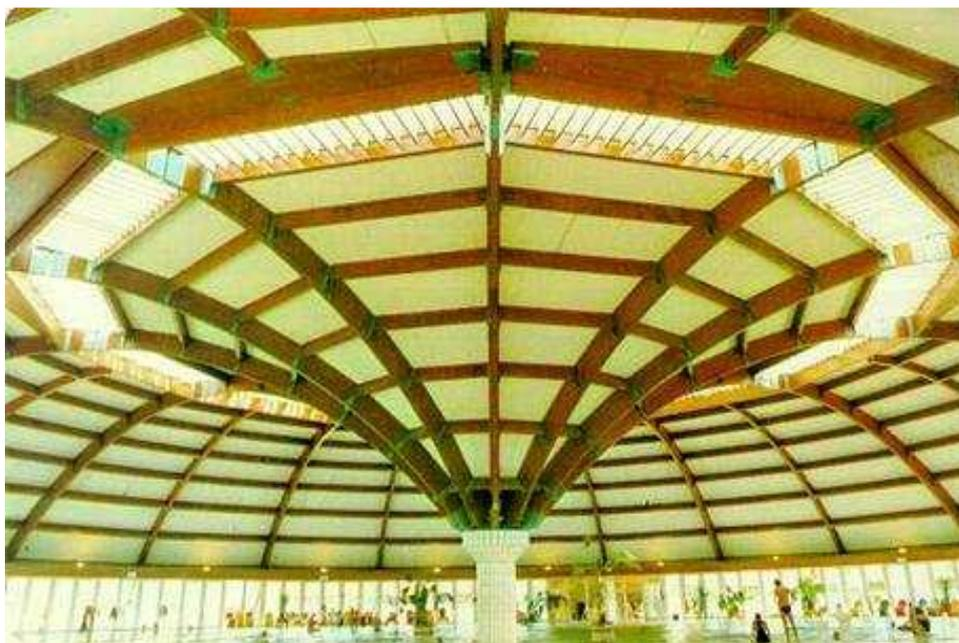
Рис.2. Клефанерный свод из криволинейных ребристых панелей.
