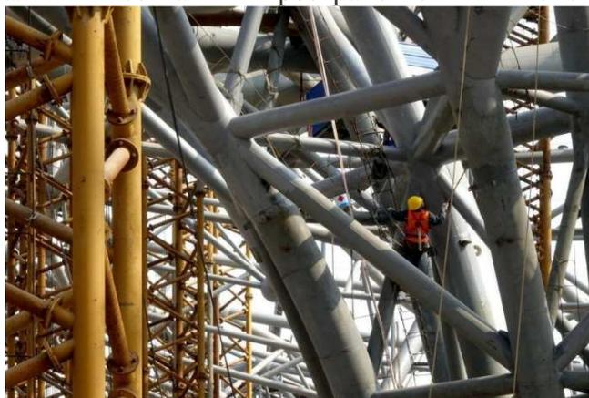
Рис.4 Процесс монтажа сетчатых конструкций аэропорта Дасин, Пекин
