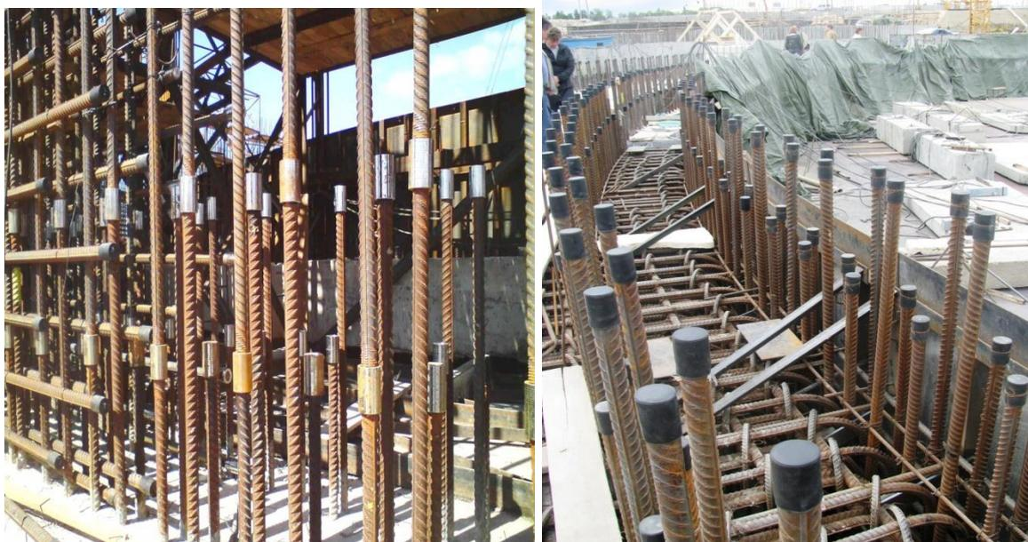
Рис. 3. Устройство арматурного каркаса при помощи механических резьбовых муфт на втором энергоблоке ЛАЭС-2
