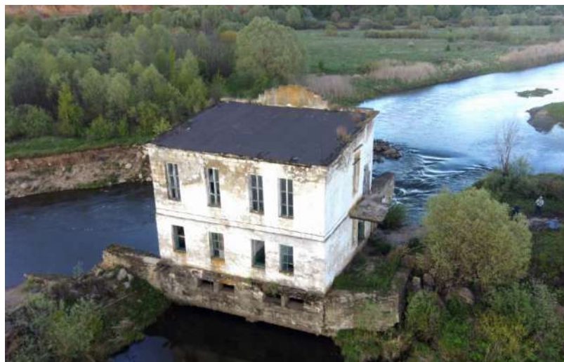
Фотография 5.6. Состояние Ичалковского гидроузла в настоящее время
