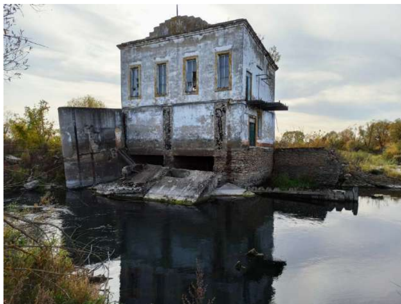
Фотография 5.9. Здание Ичалковской ГЭС
