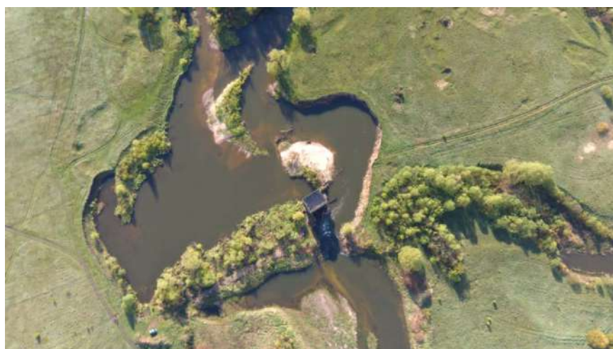
Фотография 5.8. Состояние Ичалковского гидроузла в настоящее время
