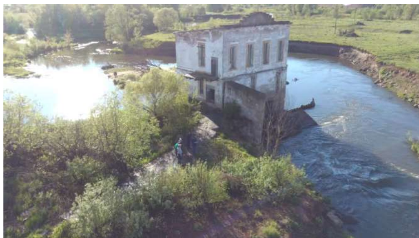
Фотография 5.7. Состояние Ичалковского гидроузла в настоящее время
