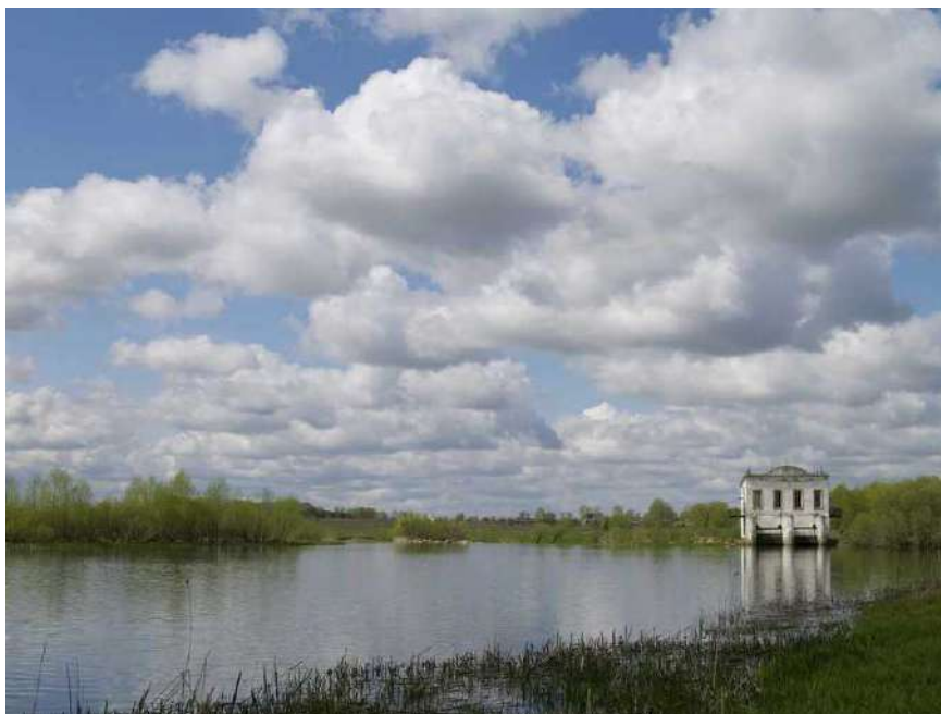
Рис. 10.6. Малая ГЭС на реке Пьяне
