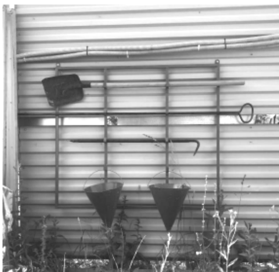
Рис. 10. Ручной пожарный инвентарь на строительной площадке
