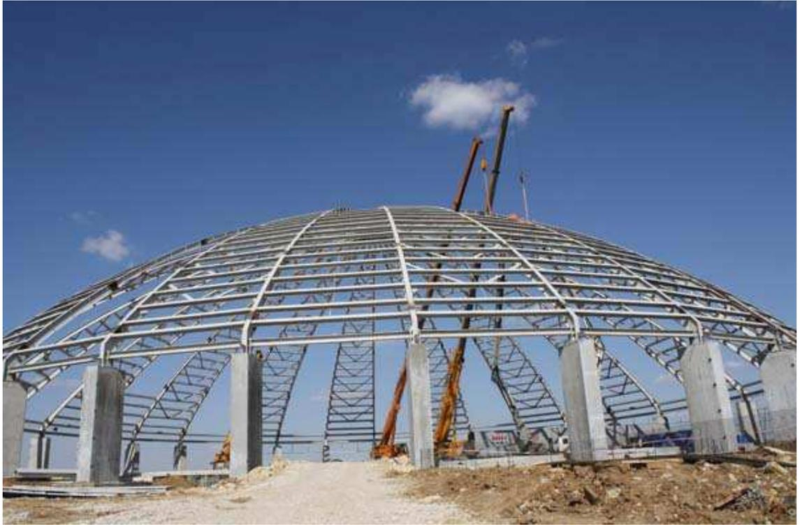
Рис. 6.73 Окружность + арочная балка
