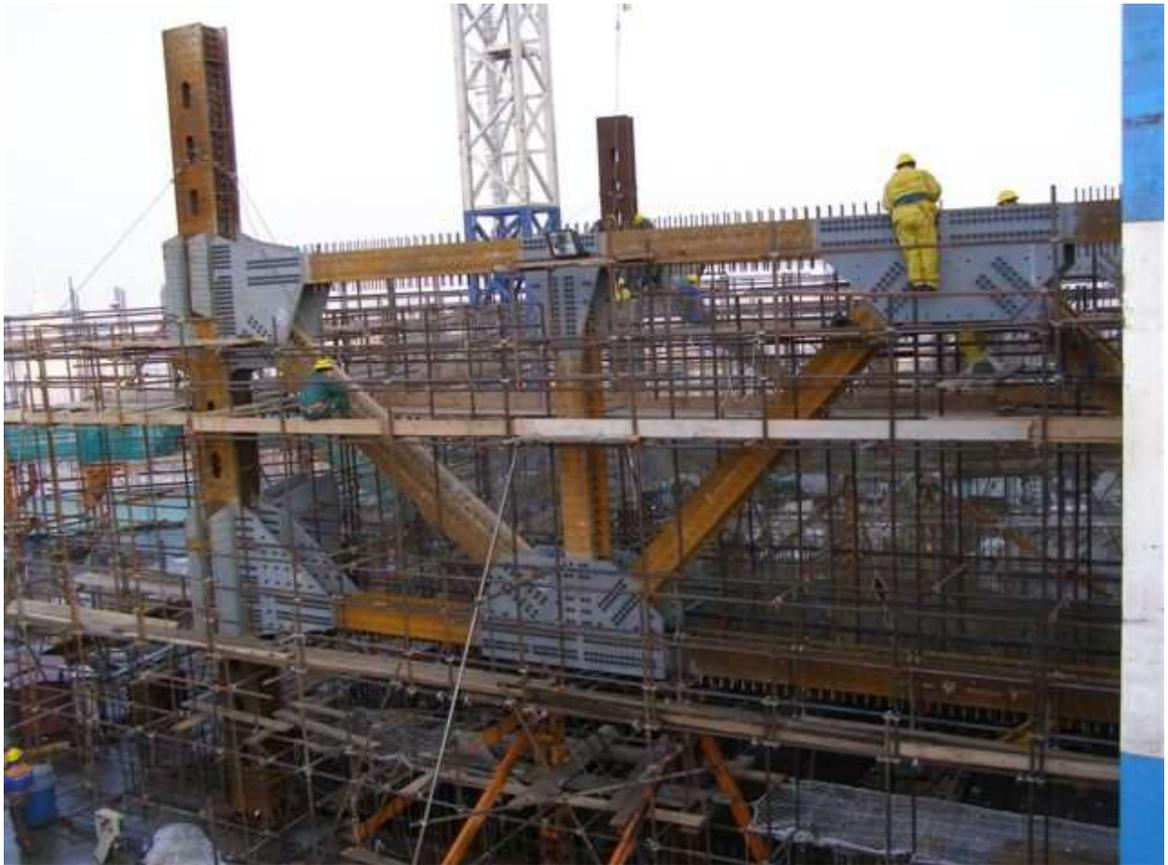
Рис. 6.52 Узел большепролетного здания
