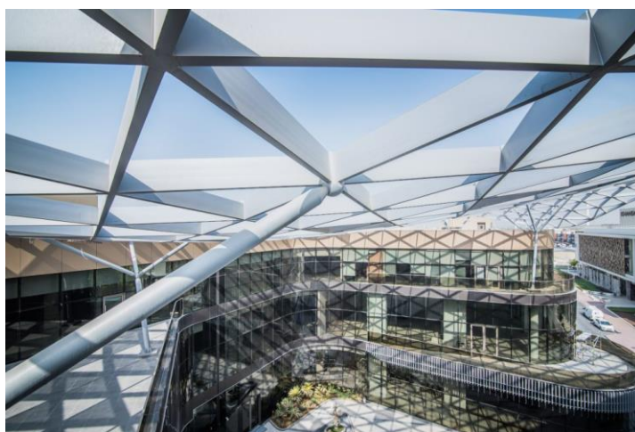
Рис. 3. Алюминиевая сетчатая оболочка торгового центра Mirdif Avenue Mall, Dubai
