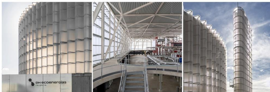
Электростанция DH Ecoenergy №1, Испания, FRPO Rodríguez & Oriol, 2022 г.
