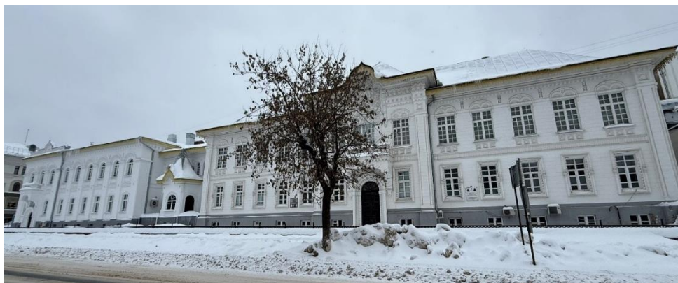
Рис.3. Общий вид корпусов общины и больницы. Фото автора, 2026 г.
