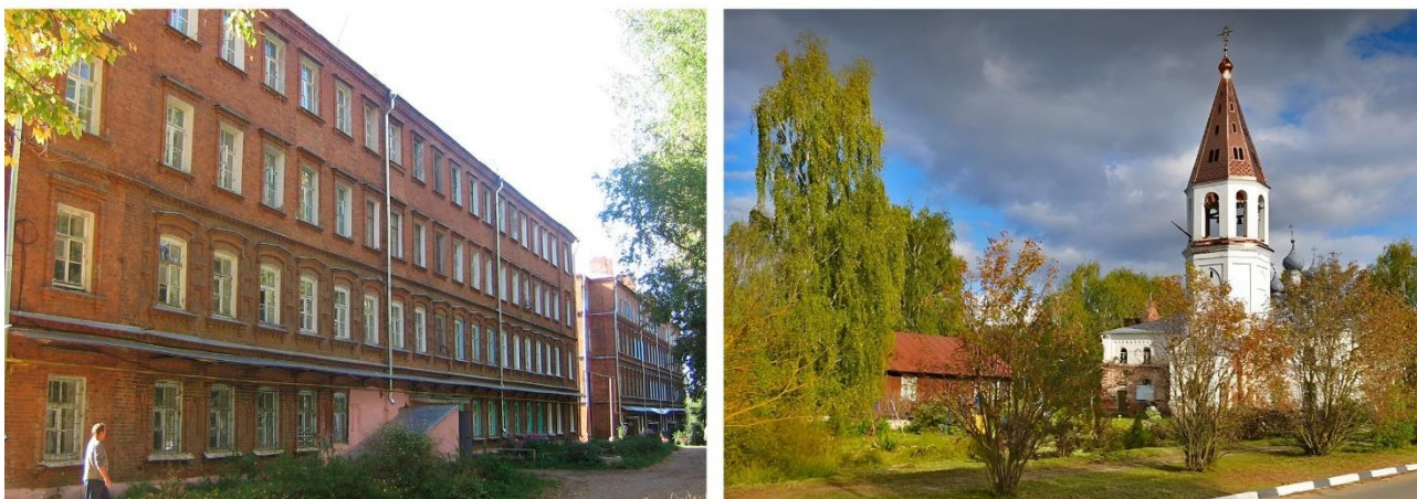
Рис. 2. Комплекс рабочих казарм фабрики Горбуновых (слева) и застройка древнего села (справа).
