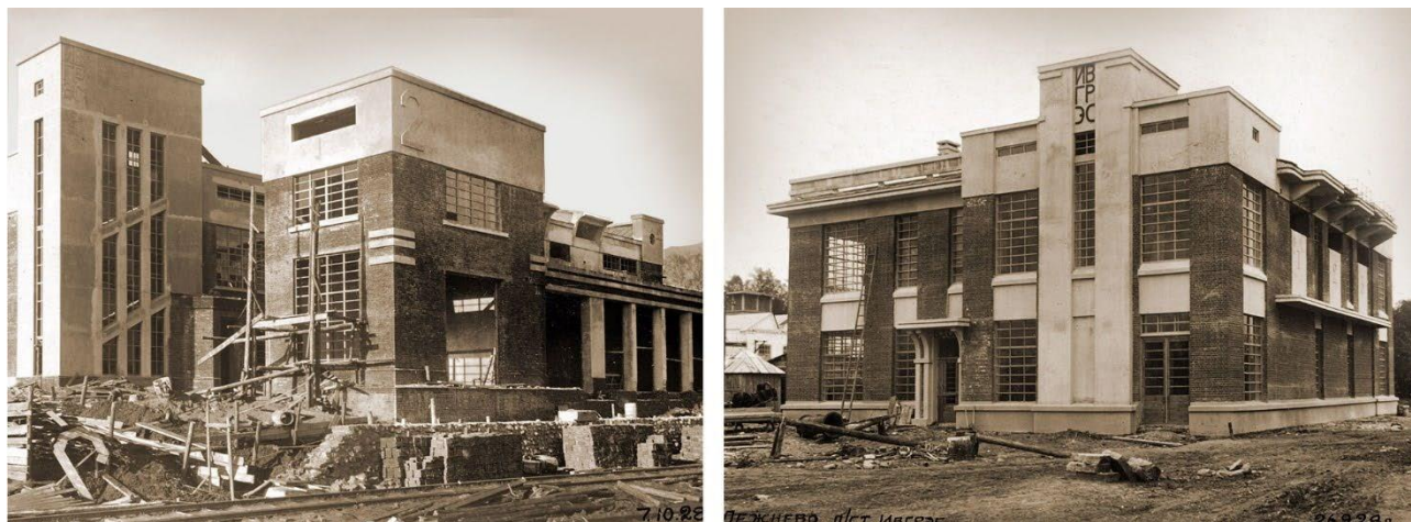
Рис. 4. Подстанция №2 ИВГРЭС в г. Иваново (слева) и подстанция в п. Лежнево (справа)
