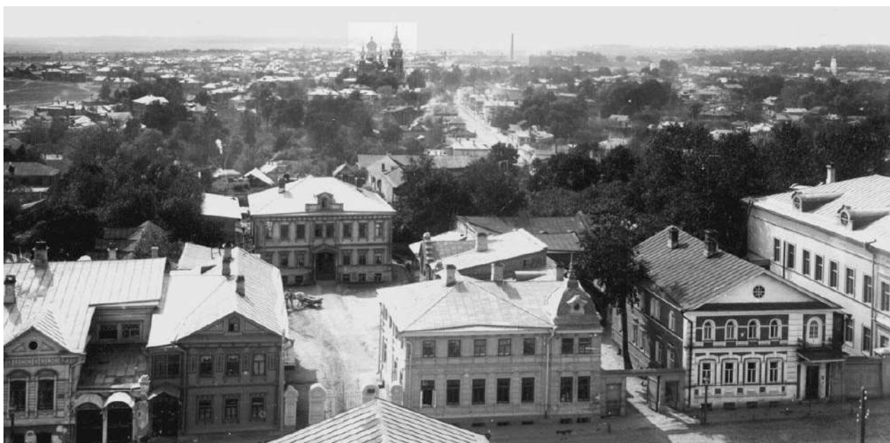
Рис. 6. Вид на Спасскую церковь с каланчи пожарного депо, стоявшего на углу Троицкой площади и Б. Печерской улицы. Фото начала XX в.
