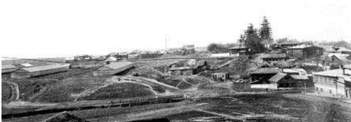
Рис. 7. Вид на строящуюся Спасскую церковь с дороги в Казань. Фото начала XX в.
