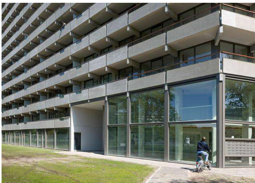
Рис. 3.3. Клейбург после реконструкции.
