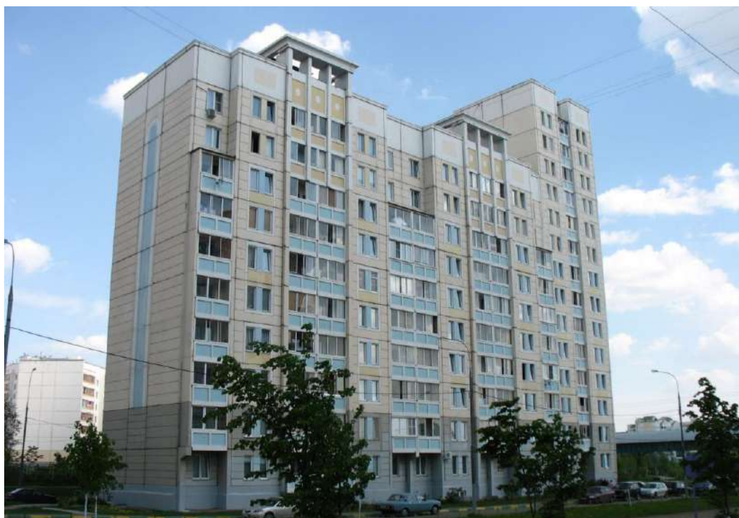
Рис. 1.10. Крупнопанельный жилой дом серии ГМС-1 в г. Москва.
