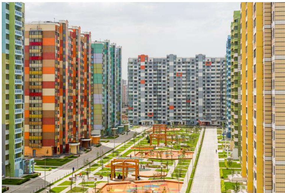
Рис. 3.22. Вид на ЖК. Источник: https://archi.ru/
