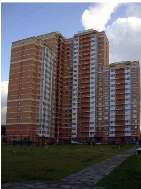
Рис. 1.15. Крупнопанельный жилой дом 220 серии в г. Москва.
