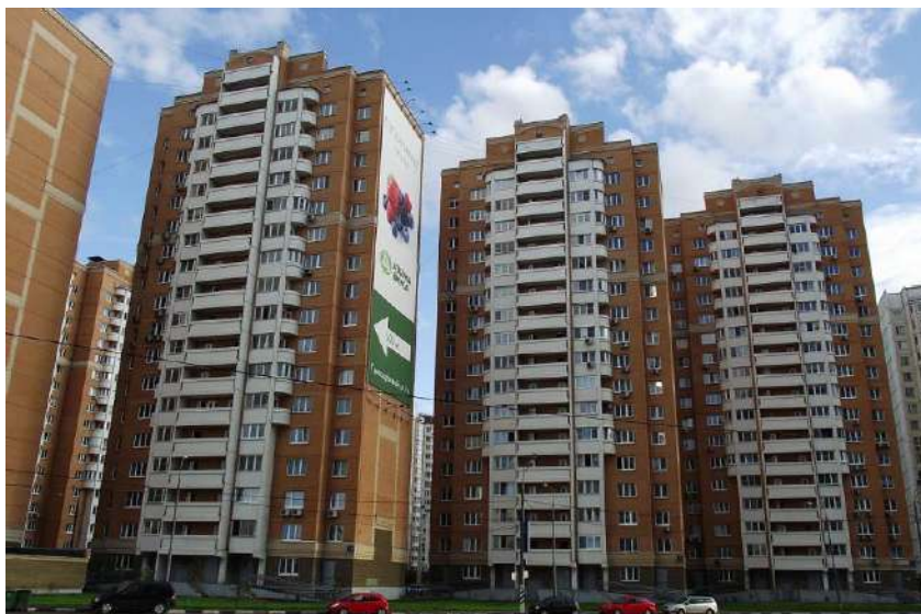
Рис. 1.14. Крупнопанельный жилой дом 222 серии в г. Москва.
