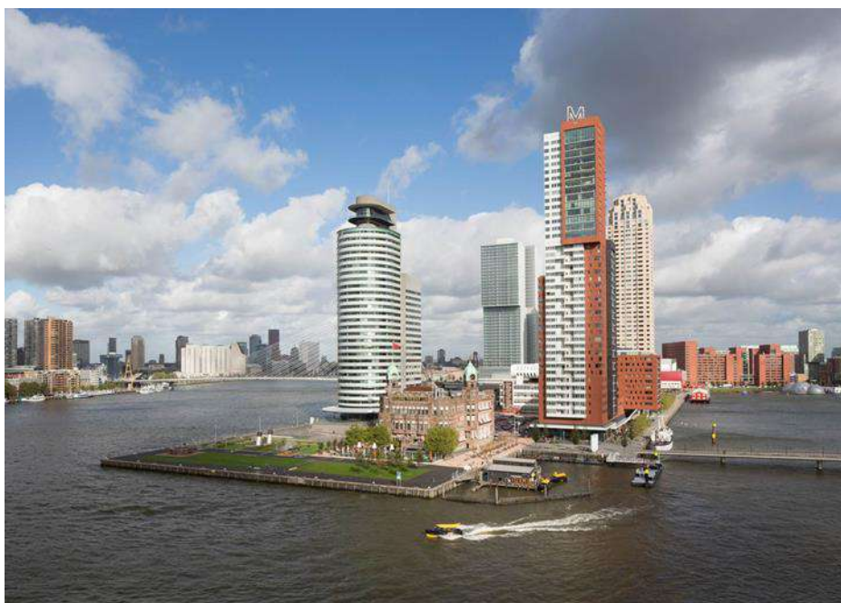
Рис. 3.20. Вид на Монтевидео. Источник: https://www.mecanoo.nl/
