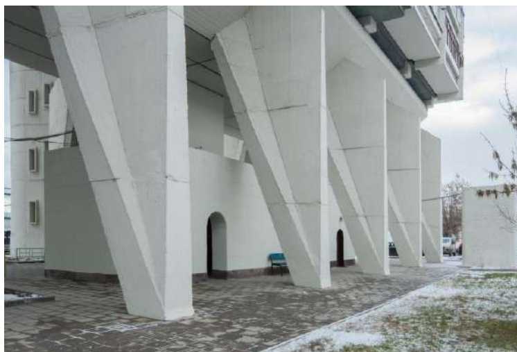
Рис. 3.15. Железобетонные опоры здания. Источник: https://archi.ru/
