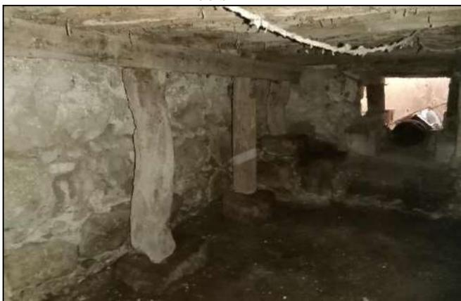
Le locale d'entretien de la roue, qui est situe sous le salon, n'a ni porte ni fenetre mais plutot un trou pour installer l'axe de la roue
