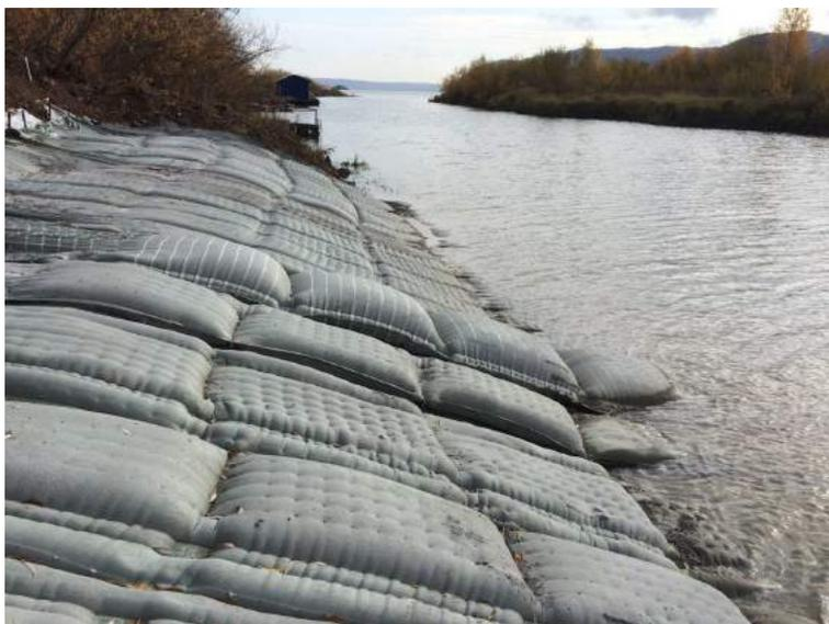
Рис. 5. Укладка бетононаполняемых оболочек по откосу грунтового сооружения (фото автора)
