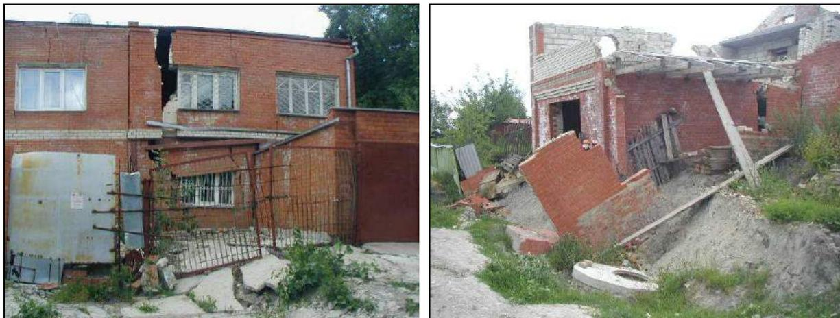
Рис. 9. Аварийные повреждения несущих конструкций зданий на склоне Смирновского ущелья
