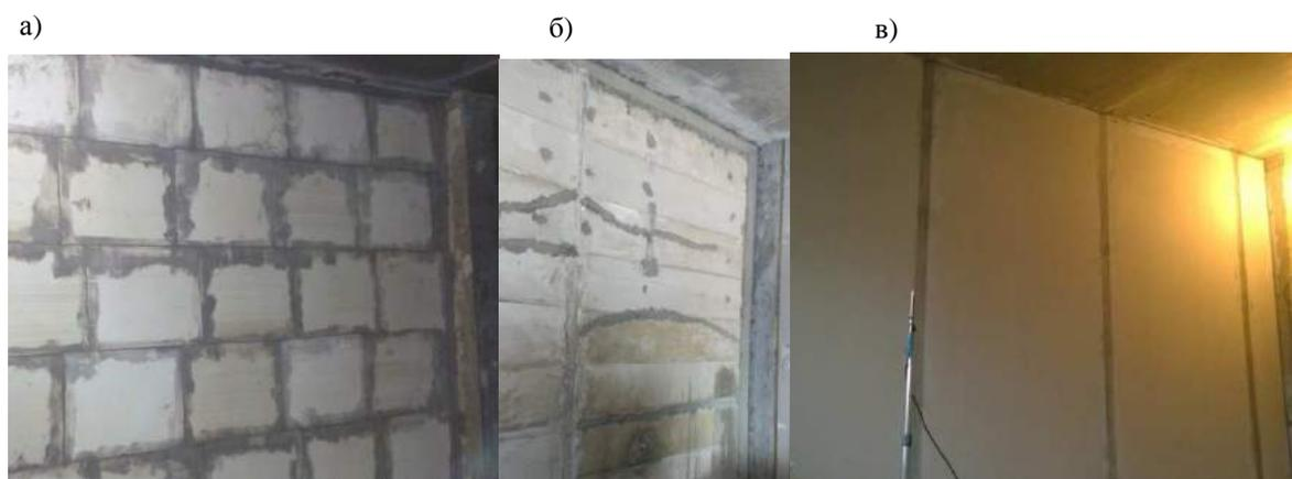
Рис. 3. Натурные измерения звукоизоляции в строящемся жилом доме в жилом комплексе «Цветы»: а) перегородка из стандартных пазогребневых гипсовых плит толщиной 80 мм; б) монолитная перегородка из гипсобетона толщиной 75 мм; в) новый тип звукоизолирующей перегородки
