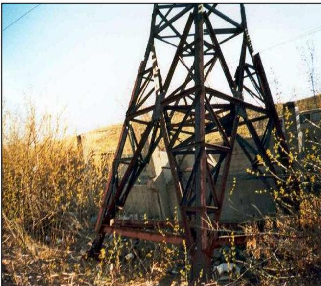
Рис. 12. Вид на аварийную подпорную стенку у опоры высоковольтной ЛЭП-110 кВт (фото 27.04.2006 г.) вблизи территории областной психиатрической больницы
