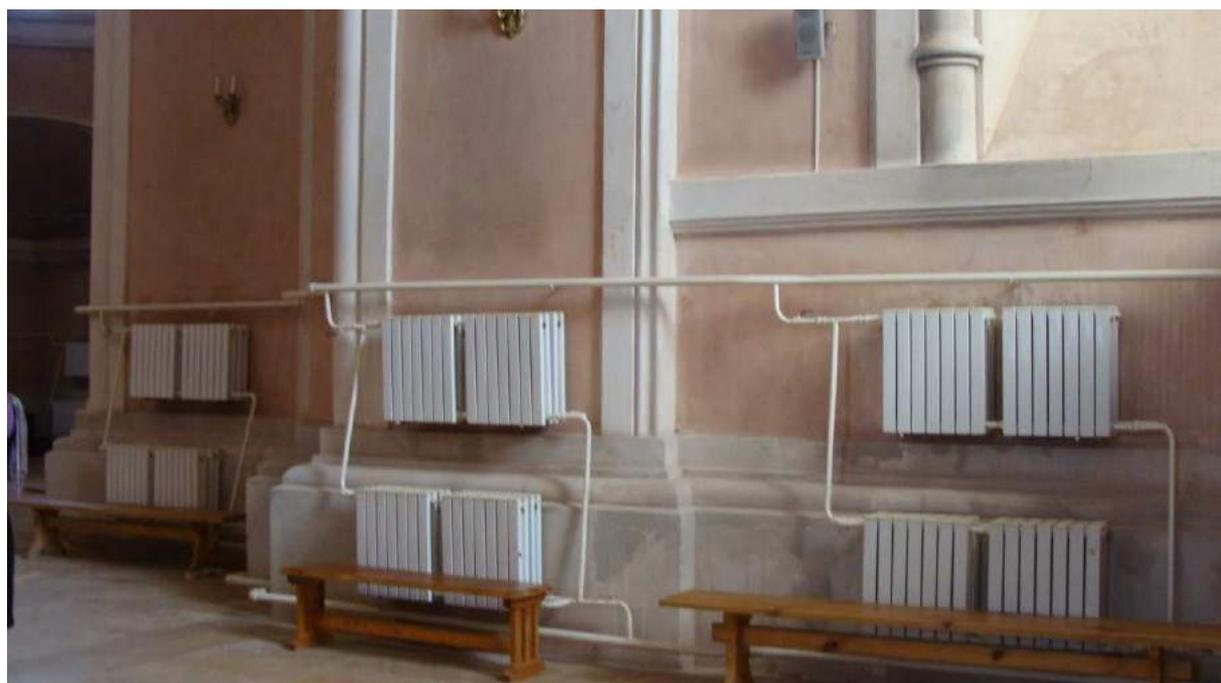
Рис. 2. Скопление сажи над отопительными приборами в несколько ярусов
