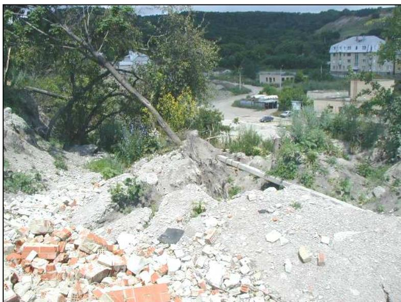
Рис. 8. Оползневые деформации грунтового массива склона Смирновского ущелья
