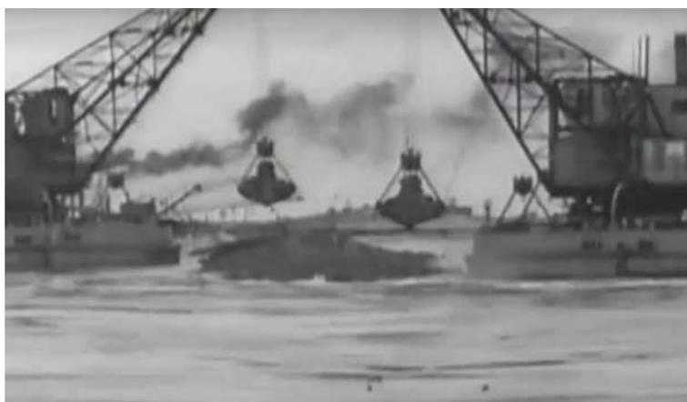
Рис. 3. Засыпка глинистого грунта в тело защитной дамбы [9]
