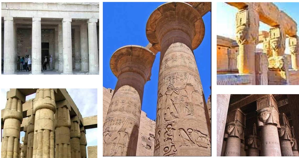
Рис. 79. Древнеегипетские колонны – протодорические, в виде лотоса, с пальмовой капителью, гаторические
