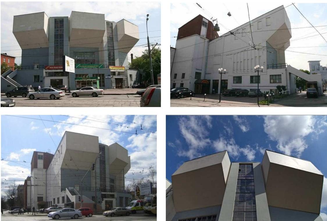
Рис. 110. Консоль как функционально значимая часть архитектурной конструкции (архитектор К.С. Мельников, здание ДК им. И.В. Русакова)
