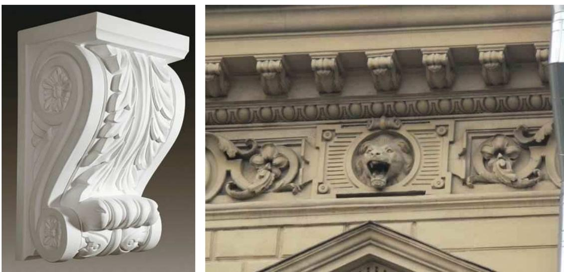
Рис. 108. Модульон и его связь с другими декоративными элементами оформления карниза здания – бордюром в виде ионика, фризovým поясом и т.д. (на примере архитектурного декора дома на ул. Чайковского в Санкт-Петербурге)
