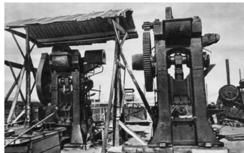
Монтаж оборудования на эвакуированном заводе. Казахстан. 1942 г.
