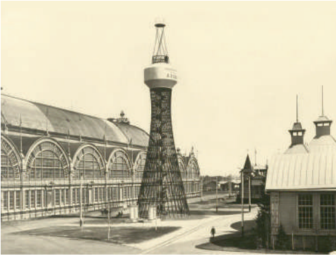
Гиперboloидная башня. Инженер В. Г. Шухов
