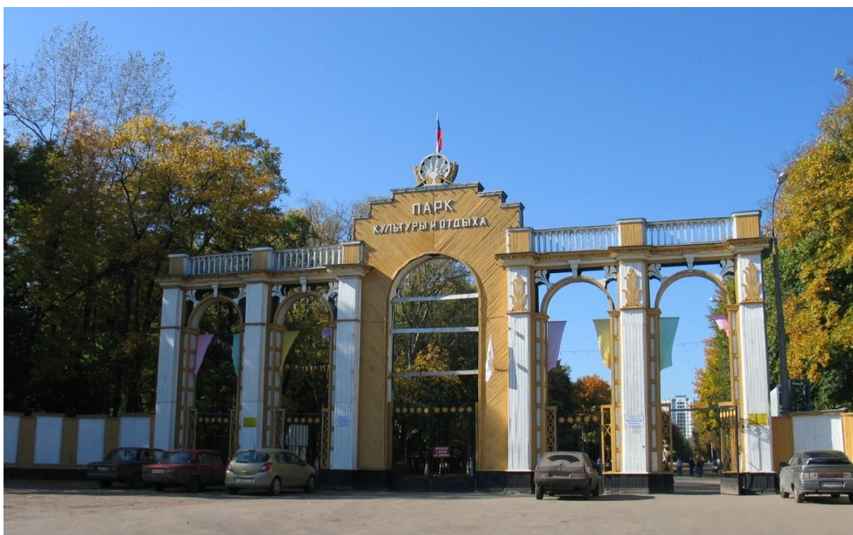
Рис.22. Вход в Автозаводский парк, 2012 г. Фото автора.
