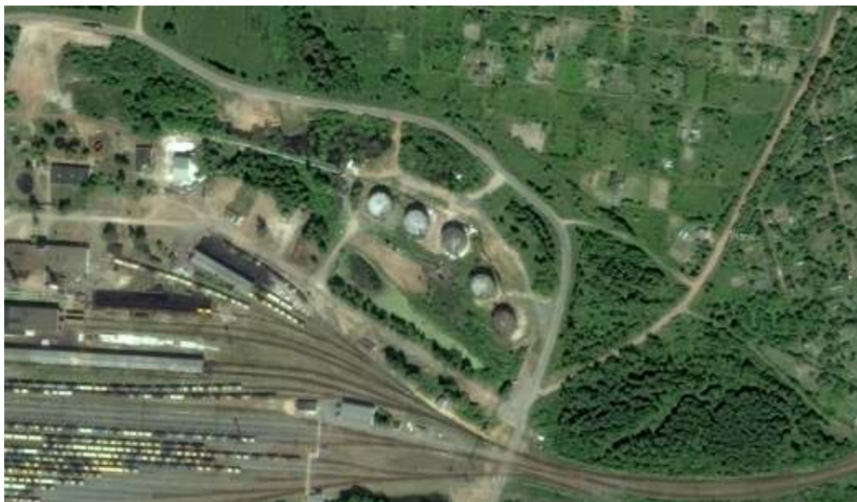
Резервуары с нефтяным остатком на территории вблизи садового товарищества
