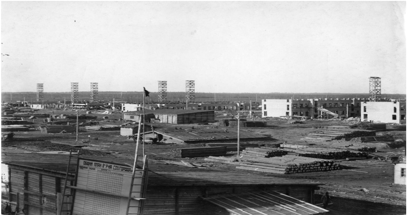
Рис. 17. Строительство первых домов Соцгорода
