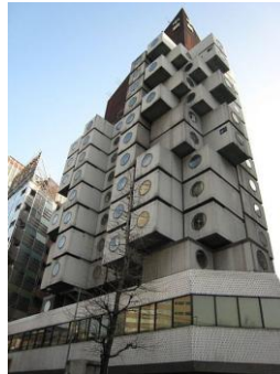
Рис. 20. Башня – капсула Накагин
