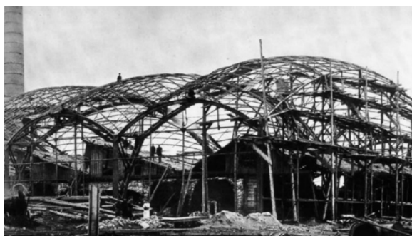
Рисунок 7 - Прокатный цех металлургического завода в г. Выксе во время строительства
