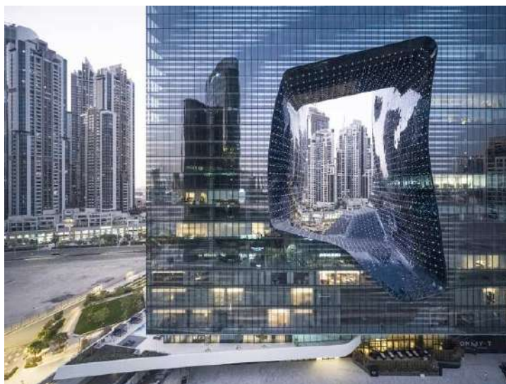
Рисунок 1- Стеклянный фасад отеля Опус обладает энергоэффективными свойствами.
