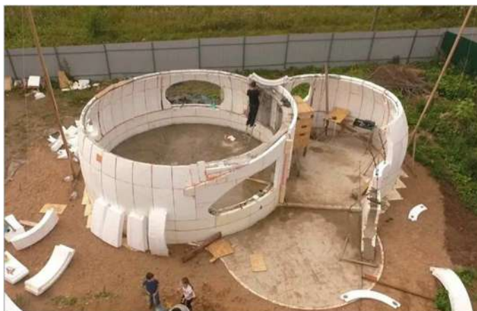
Рисунок 6 «Несъемная опалубка»
