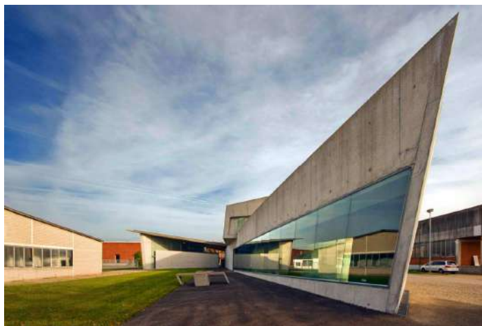
Рисунок 1 – Пожарная станция Vitra, г. Вайль-ам-Райн (Германия).
