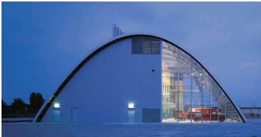
Рисунок 5 – Пожарная часть «Дом пожарных», г. Хаутен (Нидерланды)
