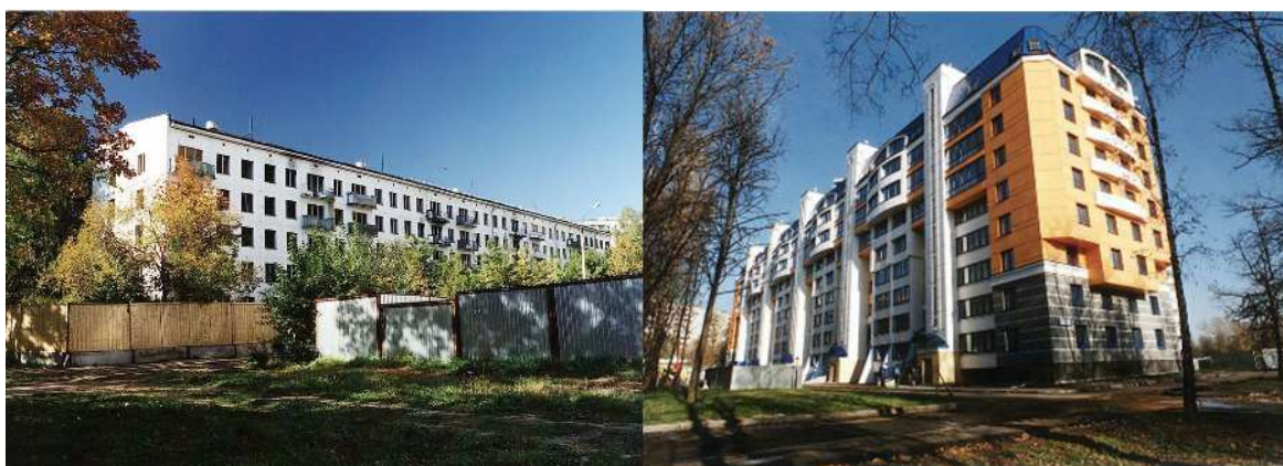
Рисунок 3. Жилой дом №4, Химкинский бульвар, г Москва до реконструкции и после
