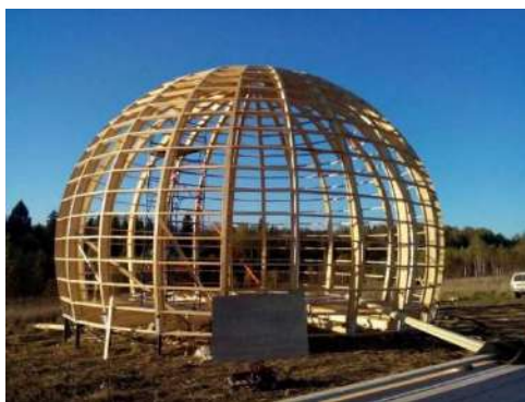
Рисунок 1 – Технологический процесс монтажа стратодезического купола
