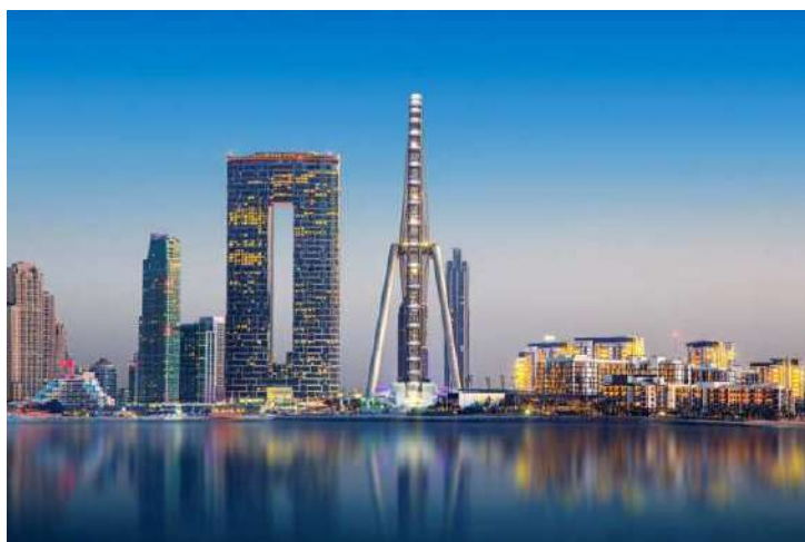
Рисунок - 6 Здание сдано в эксплуатацию.
