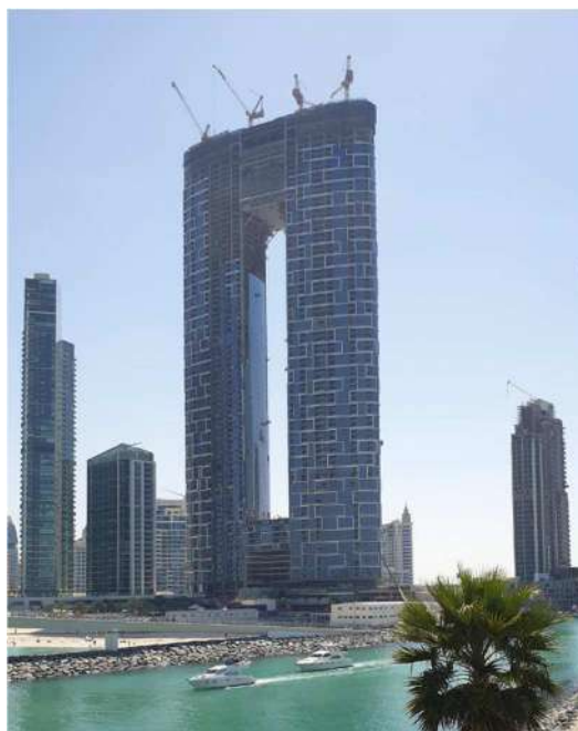
Рисунок - 5 строительство на момент 2019 года.
