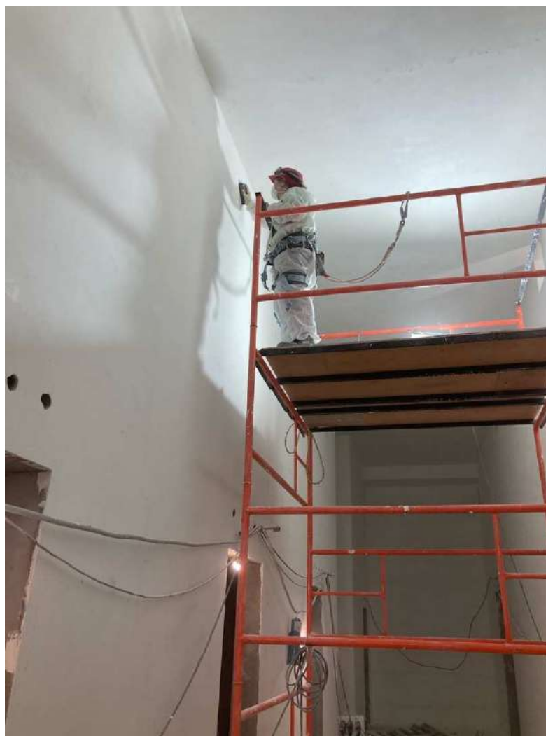
Рисунок 2 - Подготовка шлифованием оштукатуренных поверхностей под окраску
