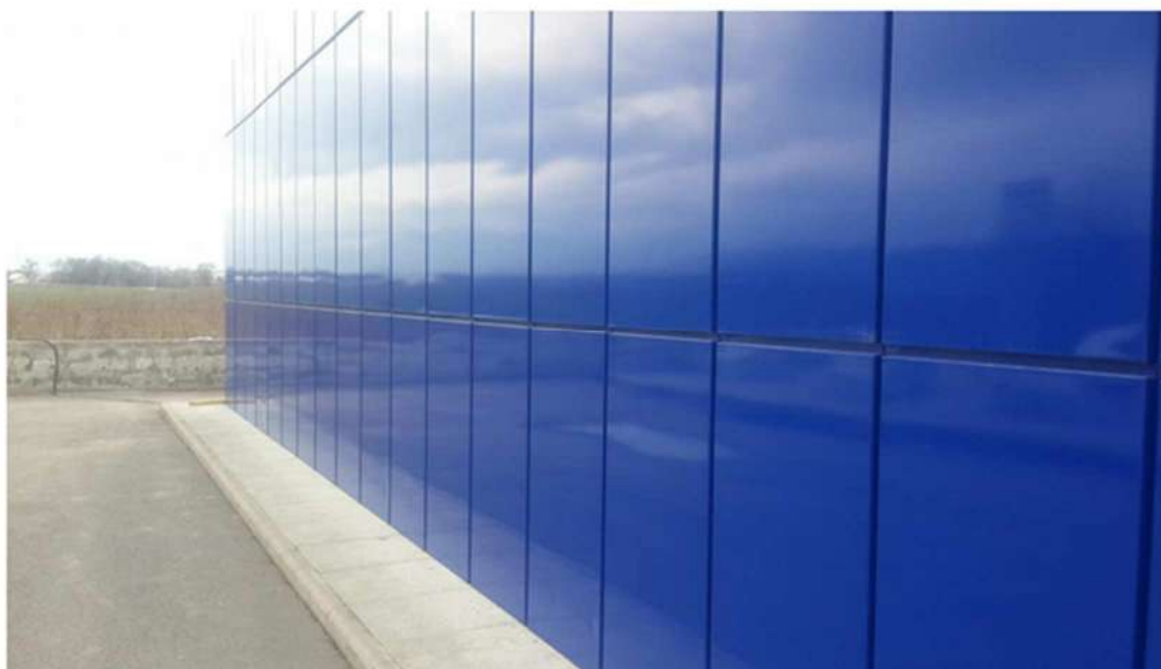
Рисунок 5 - Фасад здания, облицованный металлокассетами.
