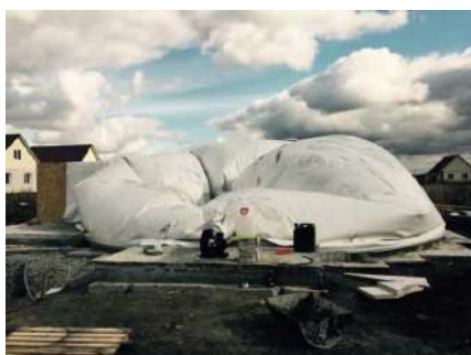
Рисунок 2 – Технологический процесс возведения монолитного купола: а – установка пневмоопалубки, б – бетонирование купола методом торкретирования.
