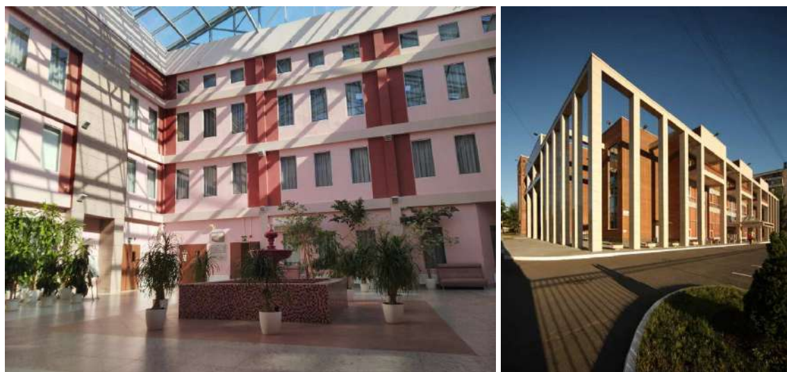
Рисунок 8 – Центр социальной реабилитации инвалидов и детей инвалидов. Фото интерьера и экстерьера. Постройка, 2010. Санкт-Петербург, Россия. Архитектурная мастерская А.А. Столярчука [5]
