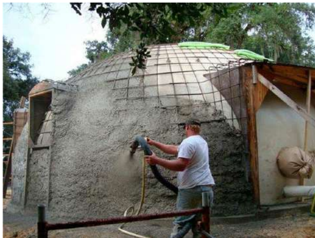
Рисунок 5 «Распыление цементной смеси спецоборудованием»
