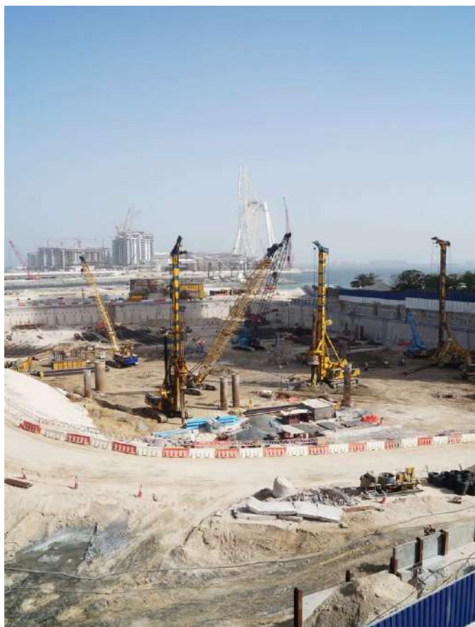
Рисунок - 3 создание фундамента в 2016 году. Источник:
