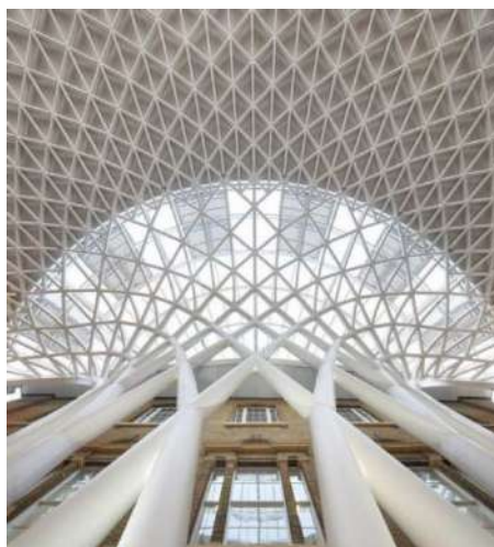
Рисунок 1 – часть новых ограждающих конструкций вокзала Кингс-Кросс.
