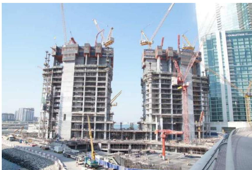
Рисунок - 4 строительство на момент 2018 года.
