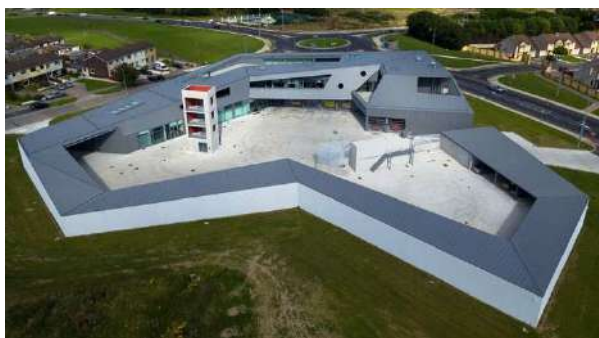
Рисунок 6 – Пожарная часть Уотерфорда, г. Уотерфорд (Ирландия)
