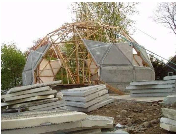
Рисунок 7 «Сборка купольного дома из заводских блоков»
