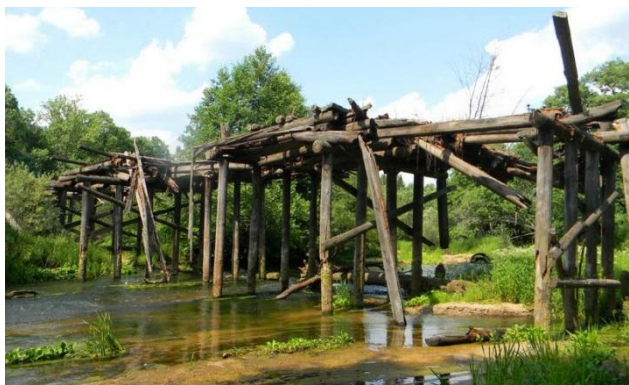
Рис. 3. Разрушенный мост через р. Сережа в Навашином районе Нижегородской области
