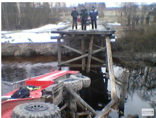
Рис. 2. Обрушение моста через р. Кеца в Борском районе Нижегородской области [3]
