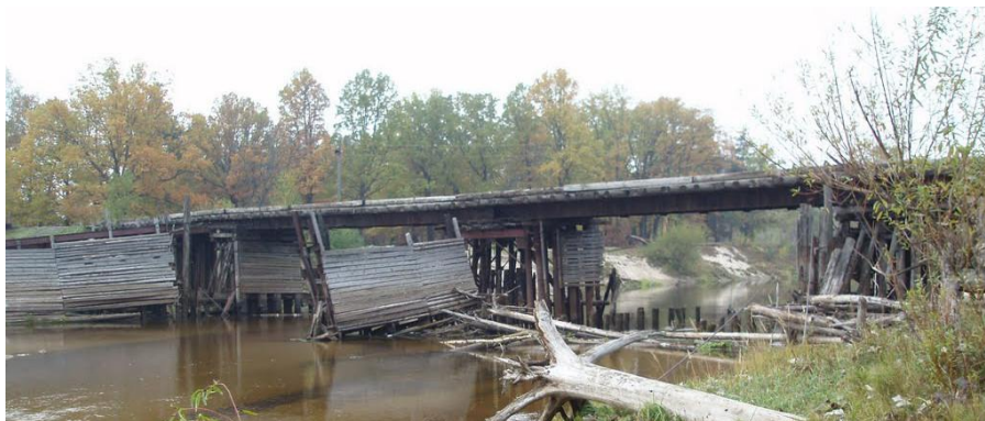
Рис. 1. Общий вид автомобильного моста через р. Лух в р.п. Фролищи Нижегородской области
