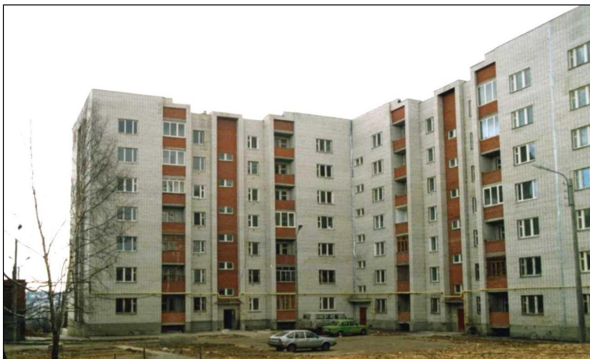
Рис. 2. Общий вид здания со двора. Деформационные температурные швы разделяют здание на 3 температурных блока: секция №1 на фото. слева, секции №2 и №3-справа
