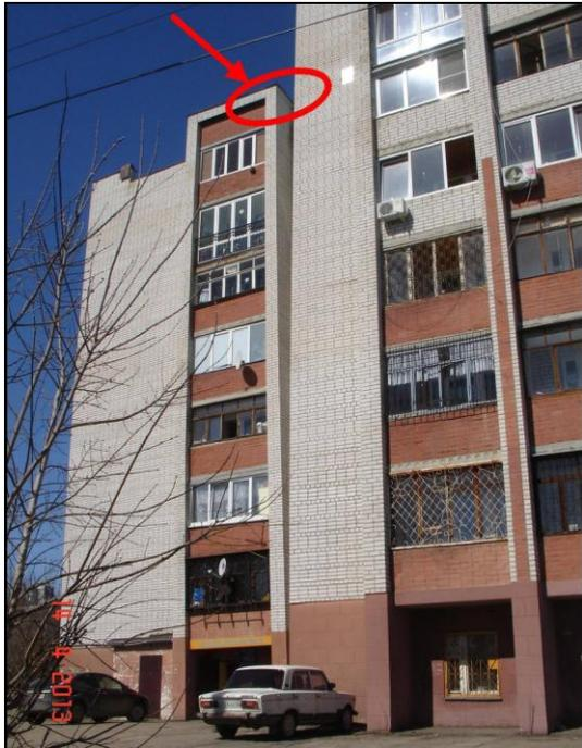
Рис. 3. Апрель 2013 года. Крен секции №2 относительно №1. Раскрытие деформационного шва в уровне верха парапета составляет 770 мм
