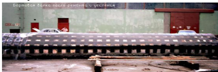
Рис. 2. Усиление железобетонных конструкций
