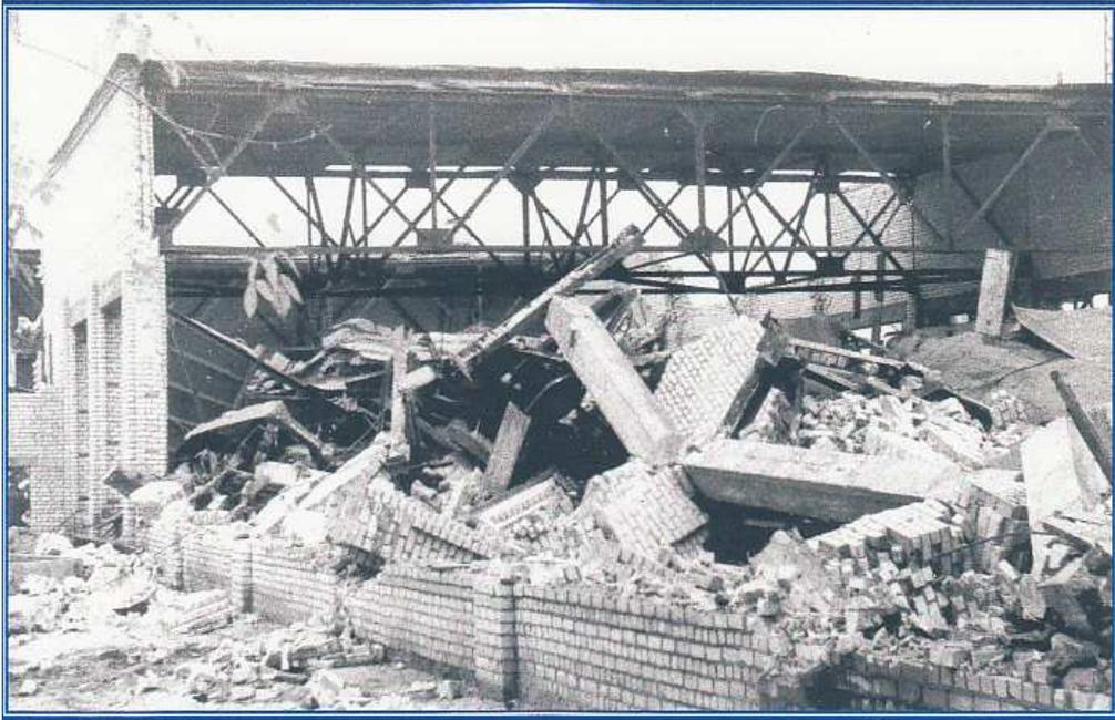
Рис. 1. Разрушение строящегося одноэтажного промышленного здания в Нижегородской области. (10.11.1991 г. Фото. Л.И. Груша)
