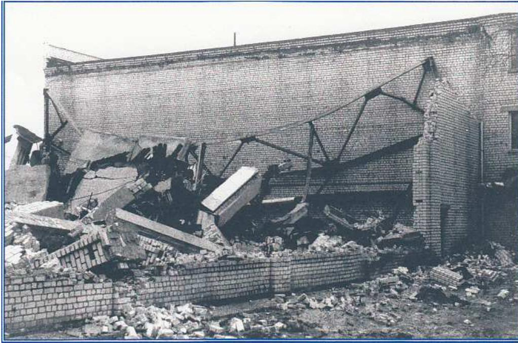
Рис. 3. Обрушение кирпичных стен и конструкций покрытия
