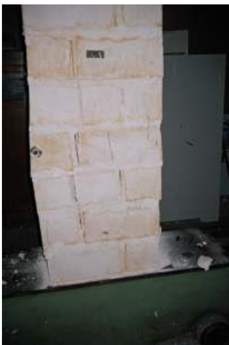
Рис. 3.41. Фотография разрушения столба
