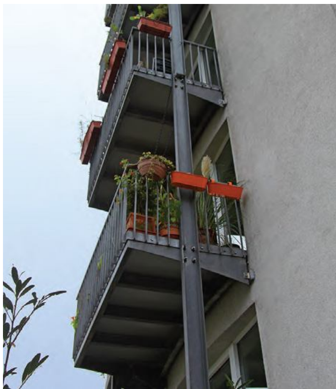
Рис. 1.30. Внешний вид балкона с креплением к металлическим колоннам (Германия) [41]
