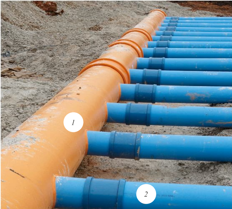
Рис. 3.10. Грунтовый теплообменник: 1 – сборный коллектор; 2 – распределительные трубы
