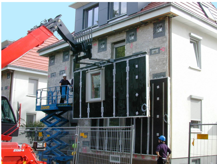
Рис. 1.20. Монтаж стен из вакуумной тепловой изоляции [51]
