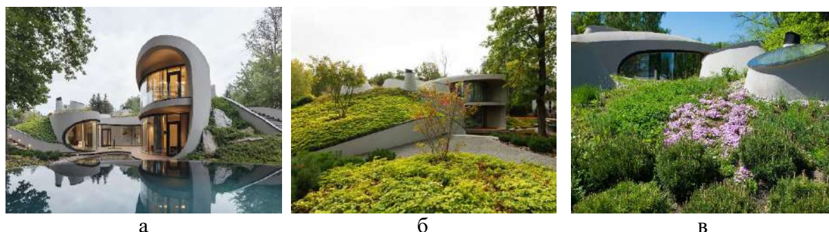
Рис.3. Бионический дом (С. Николаев. 2019 г.): а - бионический дом, «вырастающий» из окружающего ландшафта; б - необычная форма зеленой кровли; в - флоксы шиповидный, карликовые горные сосны и можжевельники на зеленой кровле
