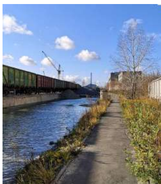
Рис.4. Набережная в промышленной зоне г. Чебоксары
