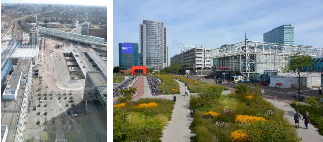
Рис. 6. Территория сквера Orlyplein до и после реконструкции
