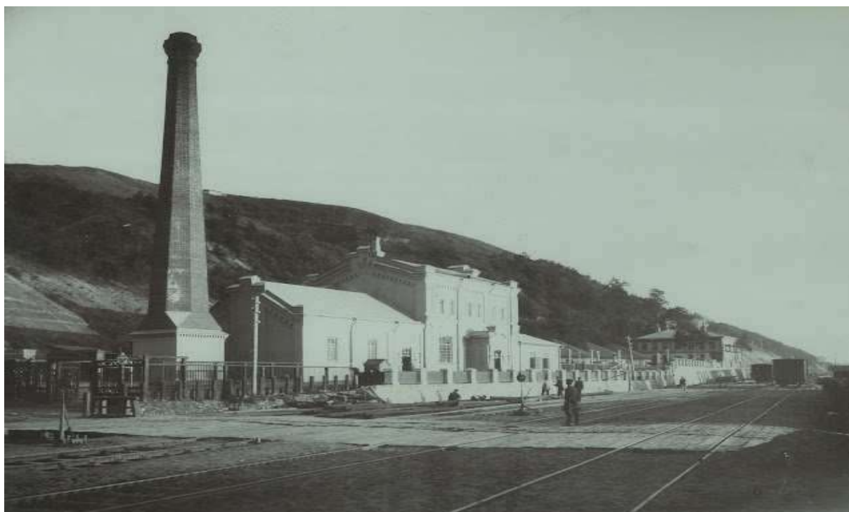
Рис. 1. Водонасосная станция - Куйбышевская водокачка 1880 г.[5]
