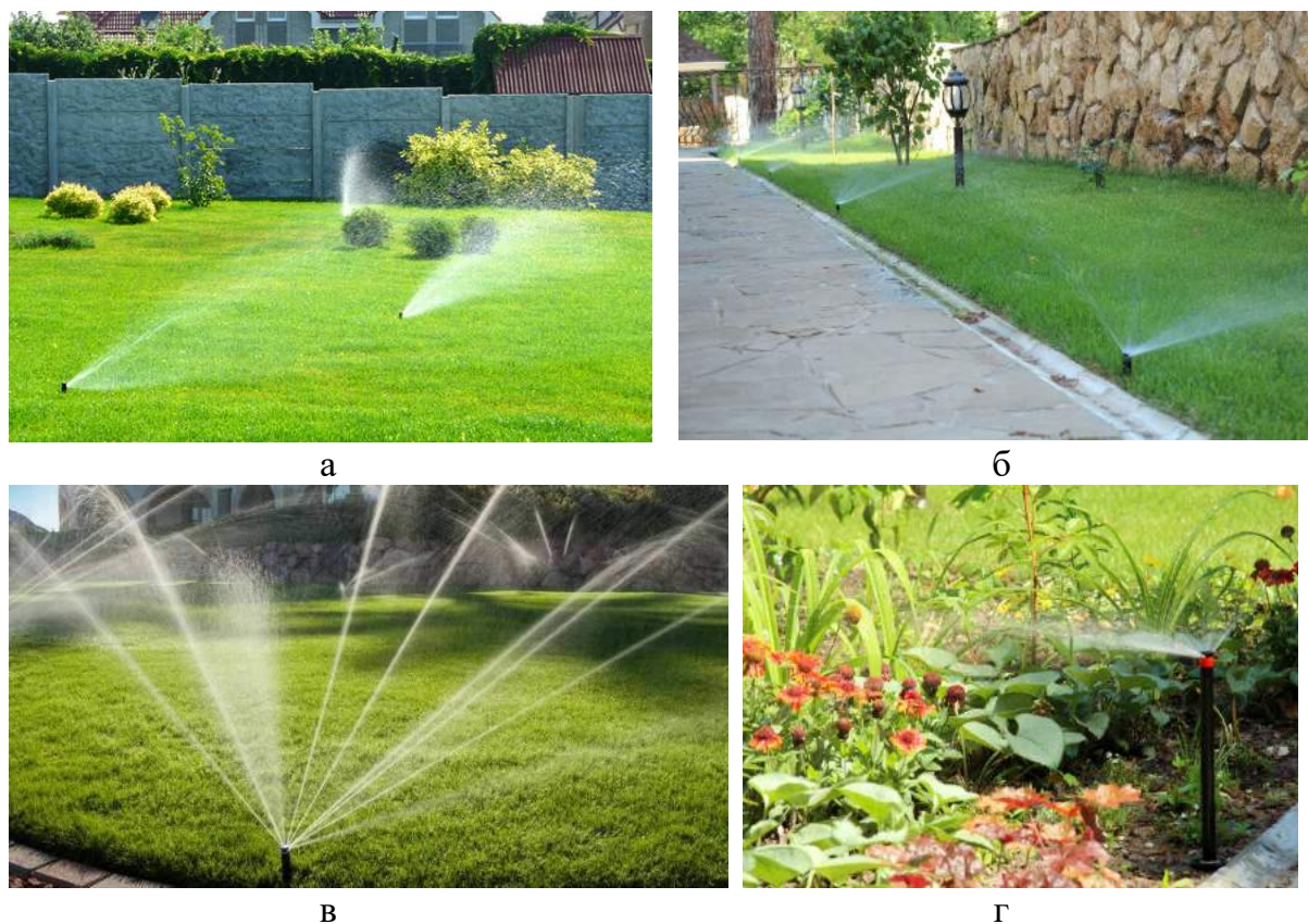
Рис. 2. Виды разбрызгивателей: а – роторные, б – веерные, в – ротационные, г – разбрызгиватели с высоким подъемом сопла
