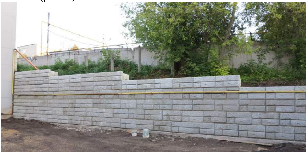
Рис 4. Подпорная стенка из К-блоков производства ООО «КНИЛЕ»
