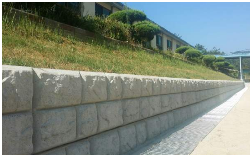
Рис 5. Гравитационная подпорная стенка высотой 1,5 метра из крупноформатных блоков. Южная Корея
