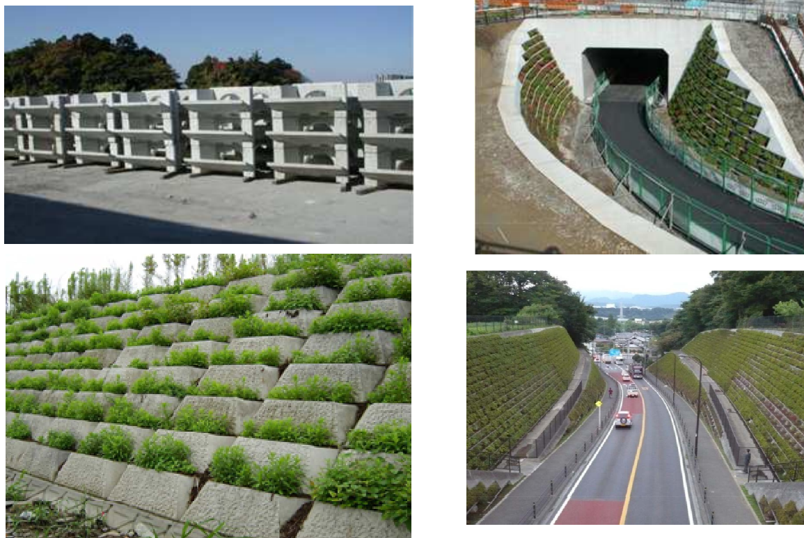
Рис.7. Биопозитивные озеленяемые подпорные стенки
