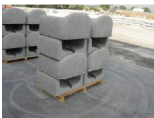
Рис.9. Зеленые подпорные стены (Италия). Собираются из простых бетонных элементов:
