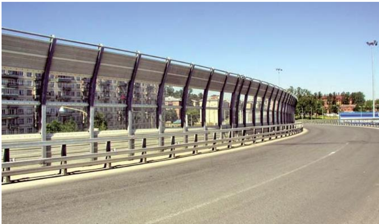
Рис. 2. Пример прозрачного шумозащитного экрана [19]
