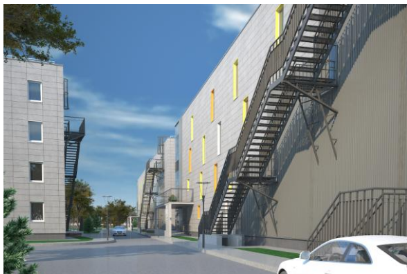
Рис. 4. Фасады со стороны галерей
