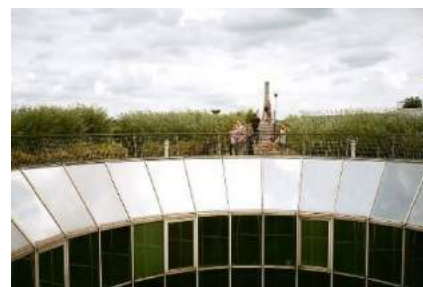
Рис. 7. Инженерная инфраструктура на кровле
