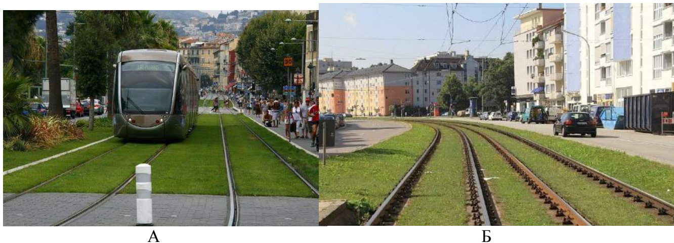
Рис. 1. А - Зелёные трамвайные пути в Китае [7]; Б - Посадка газона у подошвы рельсов [8]
