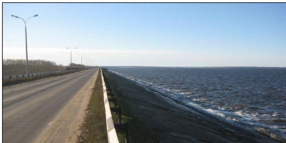
Рис. 29.3. Земляная плотина Нижегородского гидроузла
