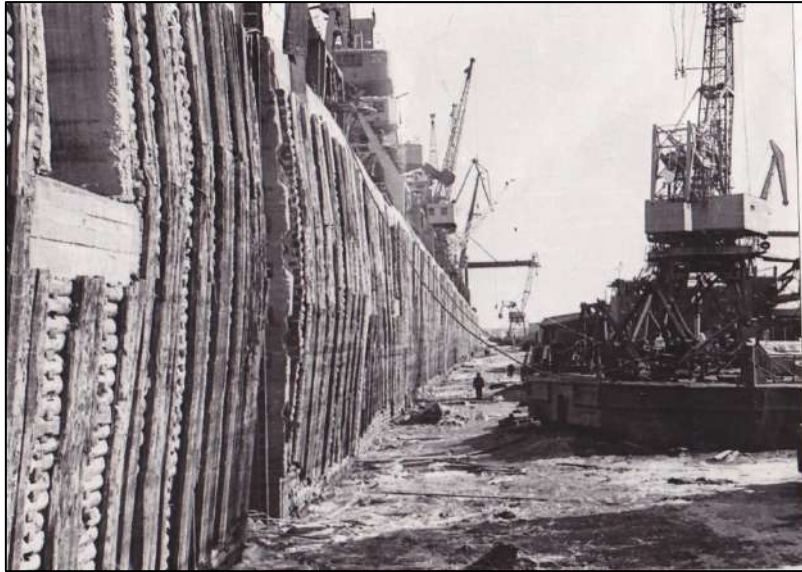
Рис. 25.35. Деревянная ряжевая причальная набережная Якутского порта на р. Лене. 1987 г.
