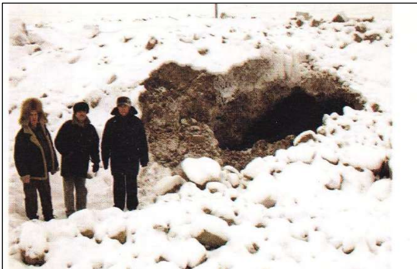
Рис. 29.8. Плотина Иреляхского гидроузла на р. Ирелях: а – вид с левого берега водохранилища, 2011 г.; б – геоэлектрический разрез 2003 г. вдоль оси плотины, стрелками и знаками + обозначены фильтрационные потоки параллельные и ортогональные оси плотины, штриховая линия – контур мерзлотной завесы; в – аварийная ситуация при выходе сосредоточенной фильтрации на низовой откос у подошвы плотины (С.И. Панов)
