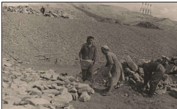
Рис. 25.12. Крепление откоса нижнего подходного канала к Волгоградскому шлюзу укладкой камня на обратном фильтре. 1959 г.
