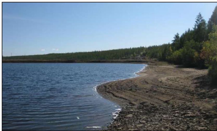
Рис. 16.31. Устойчивые к размыву берега Иреляхского водохранилища, удерживающие площадь его зеркала в проектных размерах. 2011 г.
