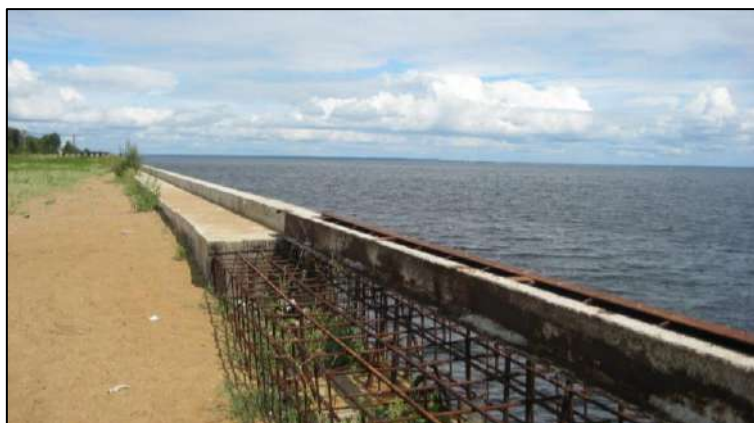
Рис. 25.17. Строительство шпунтовой стенки вдоль существующей дамбы инженерной защиты г. Юрьевца на Горьковском водохранилище. 2008 г.
