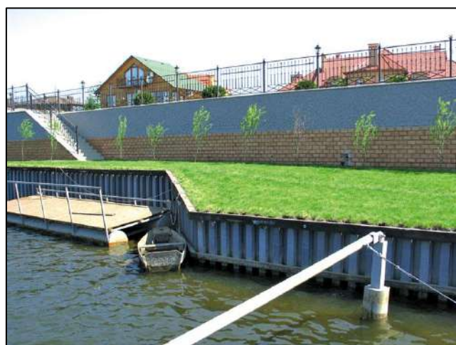
Рис. 25.19. Берегоукрепление пластмассовым шпунтом
