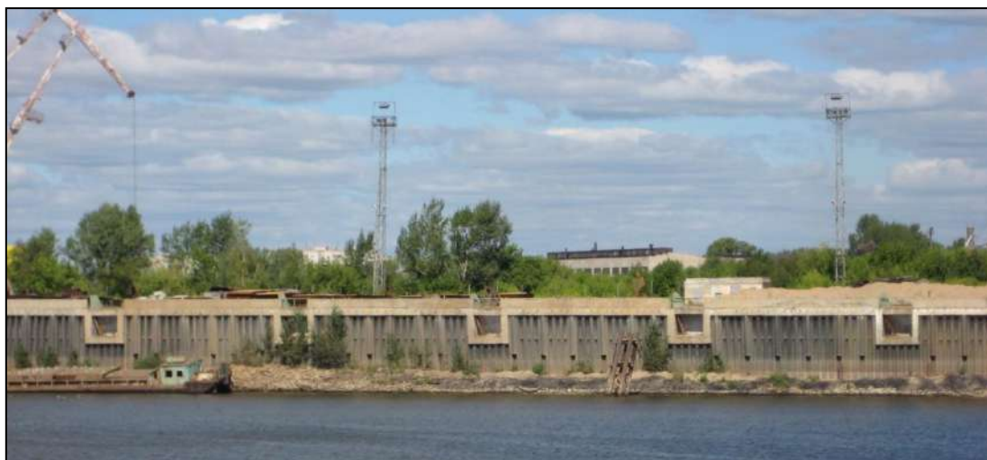
Рис. 26.10. Причальный фронт грузового порта г. Бор на р. Волге, построенный в расчете на отметку НПУ = 68,0 м и недоступный для судов при отметке ВПУ = 63,0 м Чебоксарского водохранилища
