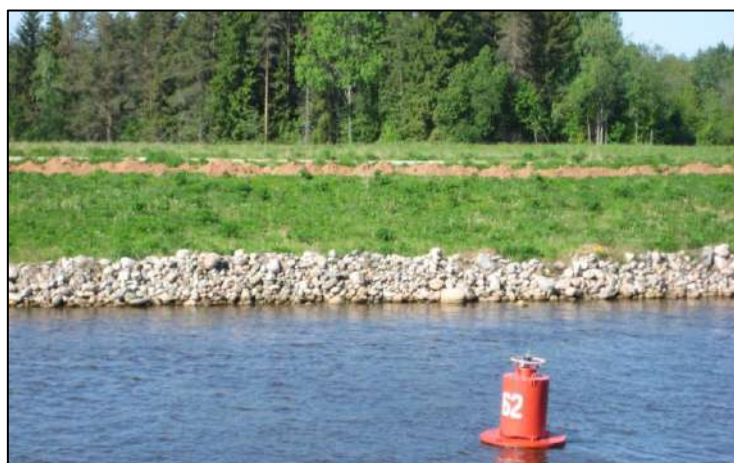
Рис. 25.26. Крепление берега Новинкинского водохранилища наброской дикого камня при реконструкции Волго-Балтийского водного пути. 2011 г.
