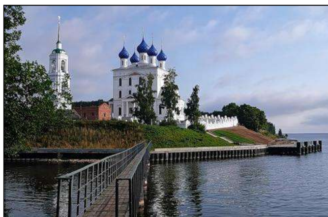
Рис. 25.18. Берегоукрепление из стального трубошпунта у храма Рождества Пресвятой Богородицы в пос. Катунки на Горьковском водохранилище. 2010 г.
