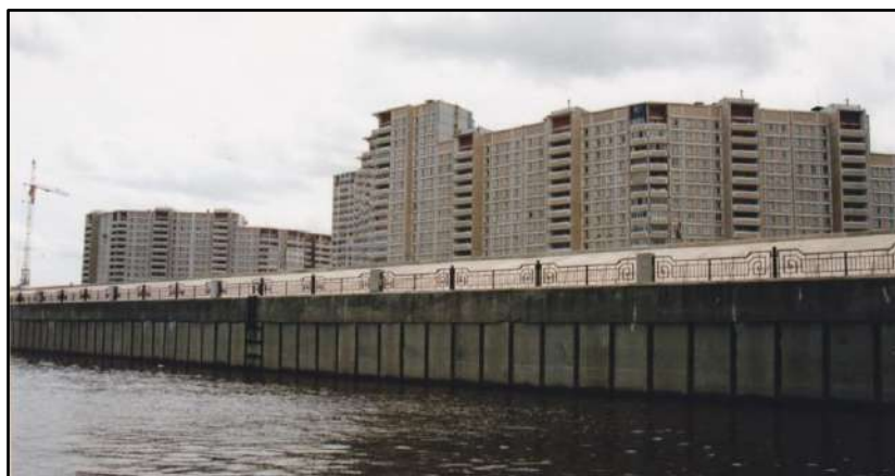
Рис. 25.16. Новая волжская набережная с вертикальной шпунтовой стенкой в микрорайоне «Мещерское озеро» г. Нижнего Новгорода, построенная под отметку НПУ = 68,0 м Чебоксарского водохранилища. 2000-е гг.
