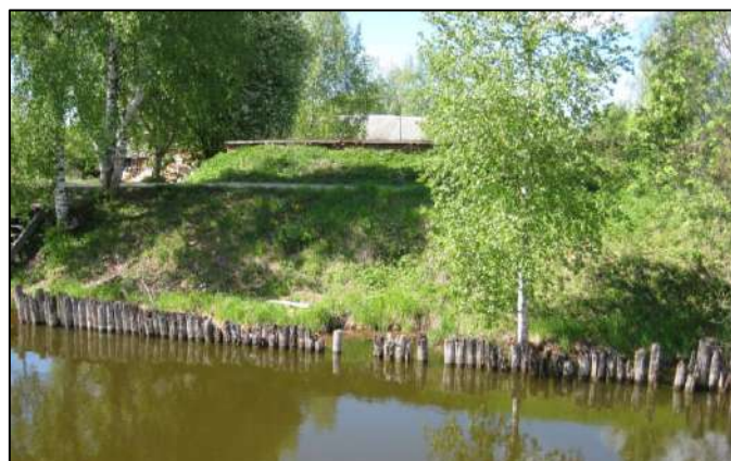
Рис. 25.29. Деревянное шпунтовое крепление берега канала на Северо-Двинском водном пути. 2011 г.
