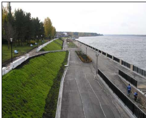
Рис. 25.15. Разрушенное берегоукрепление после 30 лет эксплуатации и новая набережная Воткинского водохранилища в с. Усть-Качка, 2009 г. [426]
