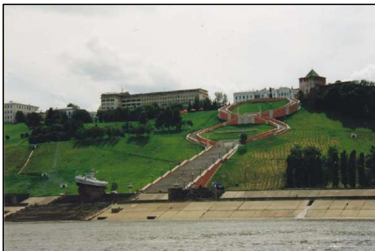
Рис. 25.9. Откосная Нижневолжская набережная и Чкаловская лестница в г. Нижнем Новгороде
