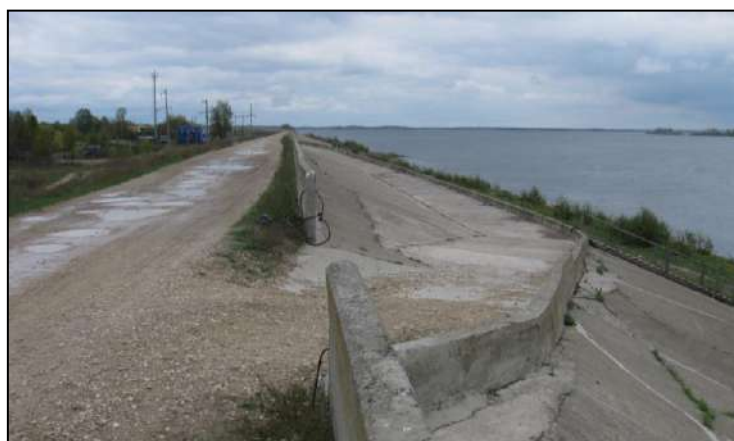
Рис. 25.7. Дамба инженерной защиты с. Михайловского на Чебоксарском водохранилище. 2010 г.
