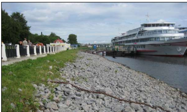
Рис. 25.24. Отсыпка гранитного камня на откосе набережной р. Волги в г. Костроме. 2008 г.
