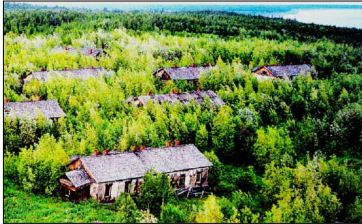
Рис. 26.7. Поселок Ермаково на левом берегу р. Енисей в Туруханском районе Красноярского края, поглощаемый тайгой [GEO, 2009. – №9]: в 1947 – 1953 гг. был базой строительства железной дороги Салехард – Игарка с населением до 15 тыс. человек, окончательно опустел к 1964 г. [18]
