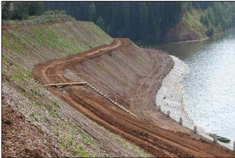
Рис. 25.20. Укладка гибкого железобетонного тюфяка на береговом откосе по слою геотекстиля и укрепление таким покрытием берега Камского водохранилища у с. Посёр. 2007 г. [426]
