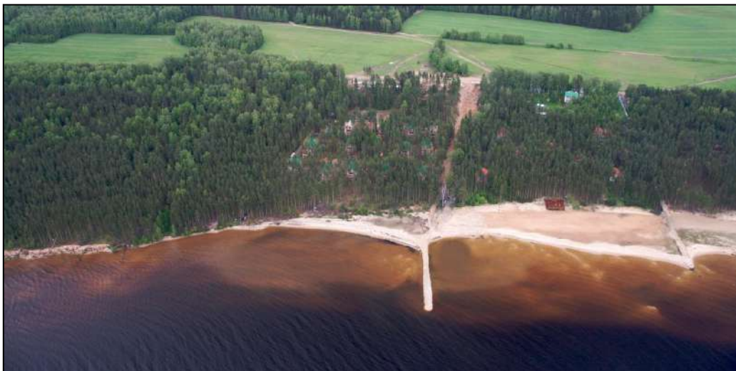
Рис. 25.31. Сплошные буны на левом берегу Горьковского водохранилища у д. Большой Суходол (проект ННГАСУ)
