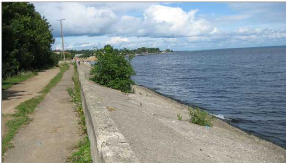
Рис. 25.3. Дамба инженерной защиты г. Юрьевца на Горьковском водохранилище. 2008 г.
