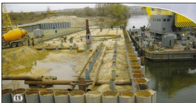
Рис. 26.11. Строительство грузового причала из стального трубопунта на Горьковском водохранилище. 2010 г.
