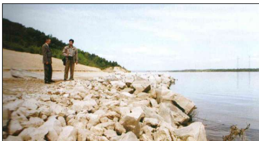
Рис. 25.25. Берегоукрепление из горной массы известняка на Куйбышевском водохранилище у д. Криуши. 2001 г. [501]
