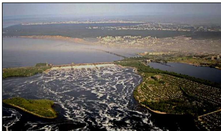
Рис. 29.2. Работающая водосливная плотина Жигулевского гидроузла при пропуске половодья 2011 г., на пике которого 4 мая среднесуточный расход воды составил 24702 \text{ м}^3/\text{с} [samara.psati.ru]
