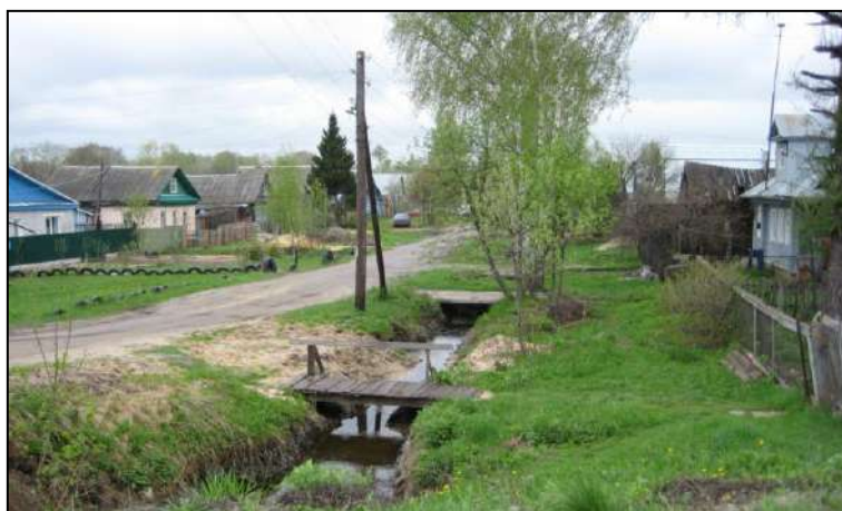
Рис. 18.13. Подтопленный старый квартал г. Балахны: уровень воды в дренажной канаве стоит на глубине 0,5 м от поверхности земли. 2008 г.
