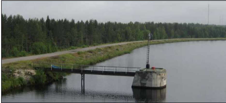
Рис. 25.2. Оградительная дамба одного из межшлюзовых бьефов Беломорско-Балтийского канала. 2009 г.
