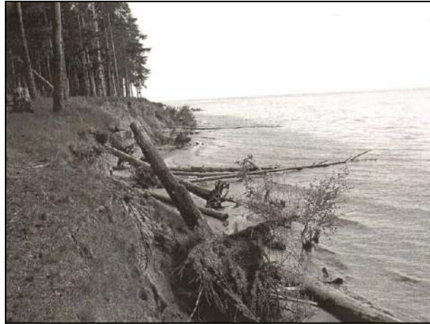
Рис. 28.7. Отпавшие деревья при размыве залесенных берегов Горьковского водохранилища. 2011 г.
