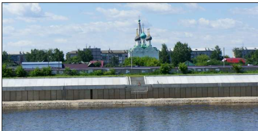
Рис. 18.12. Вид с р. Волги на г. Балахну. Набережная, построенная в 2000-е гг. под отметку НПУ = 68,00 м БС Чебоксарского водохранилища
