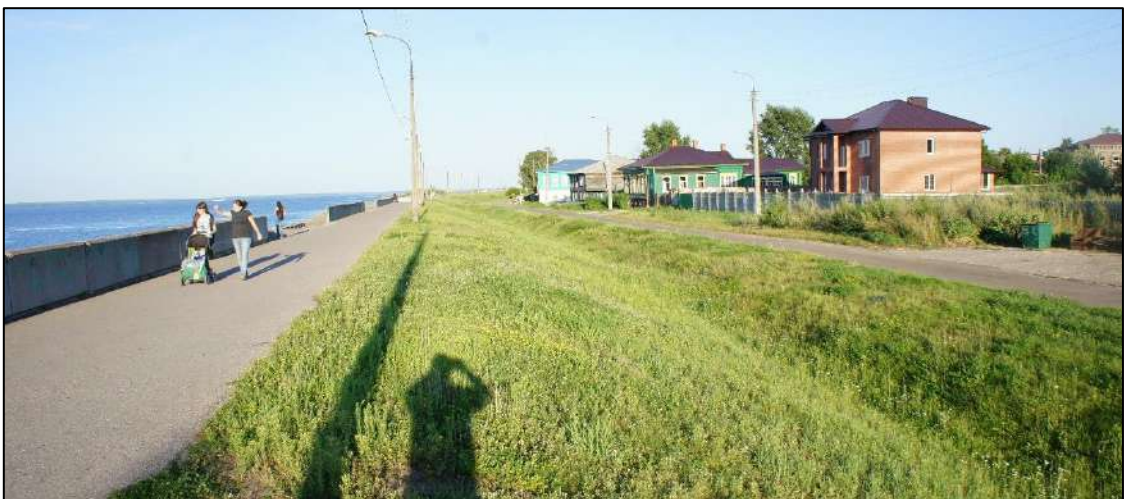
Рис. 25.5. Вид с р. Волги на г. Козьмодемьянск, 1900-е гг. [621], и дамба, защищающая нижнюю часть города от воздействия Чебоксарского водохранилища, построенная под отметку НПУ = 68,00 м БС, 2018 г.
