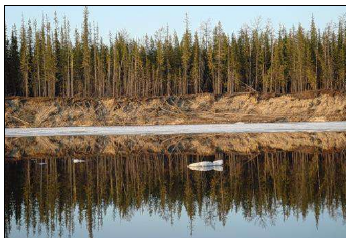
Рис. 16.28. Термоабразионный левый берег Вилюйского водохранилища в Дуранинском расширении
