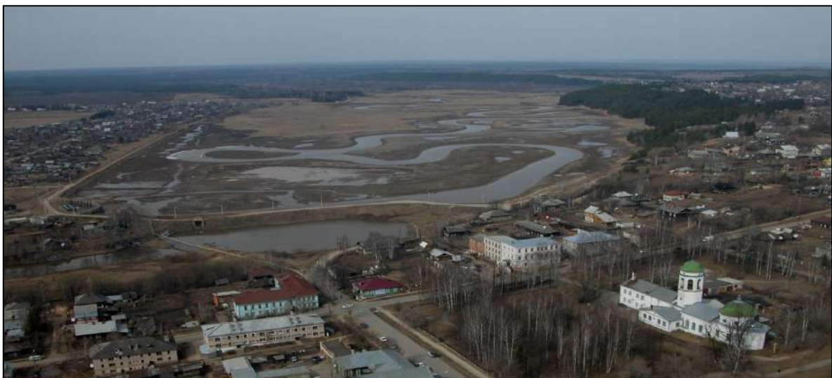
Рис. 30.2. Водохранилище на р. Куве в г. Кудымкаре, осушенное для очистки от донных отложений. 2007 г. [426]
