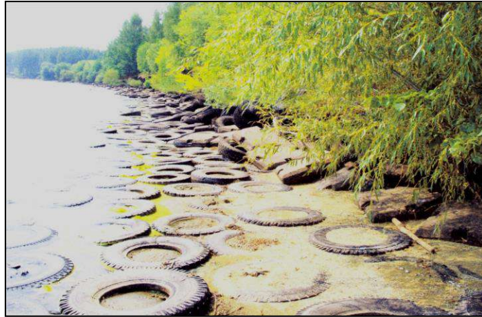
Рис. 25.27. Неэстетичное и небезопасное для людей, но небезуспешное крепление автопокрышками берега Пензенского водохранилища на р. Суре. 2010 г.
