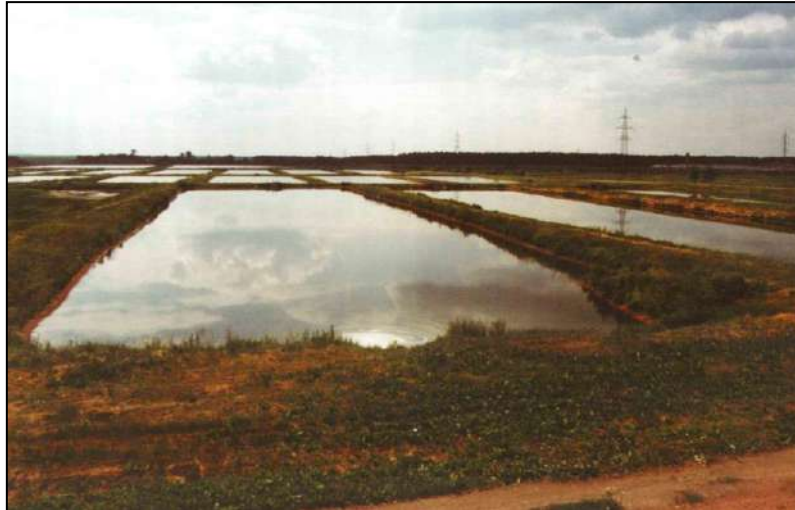
Рис. 2.9. Очистные сооружения на базе биологических прудов в агрофирме «Дороничи» Кировской области [501]
