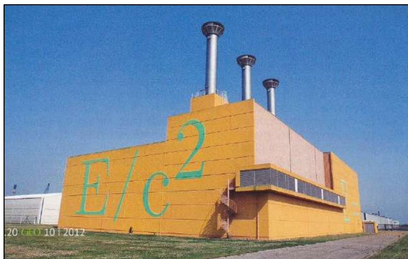
Рис. 3.12. Наземное хранилище радиоактивных отходов в Голландии с бетонными стенами толщиной 1,7 м способное выдержать землетрясение силой 6,5 баллов [73]
