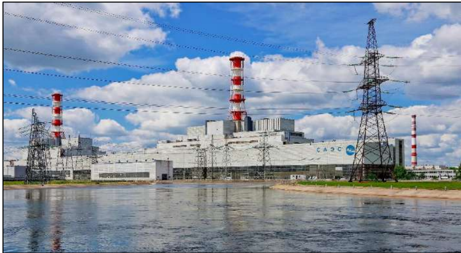
Рис. 2.1. Подводящий канал из водохранилища на р. Десне к водозаборам Смоленской АЭС [www. rosenergoatom.ru]
