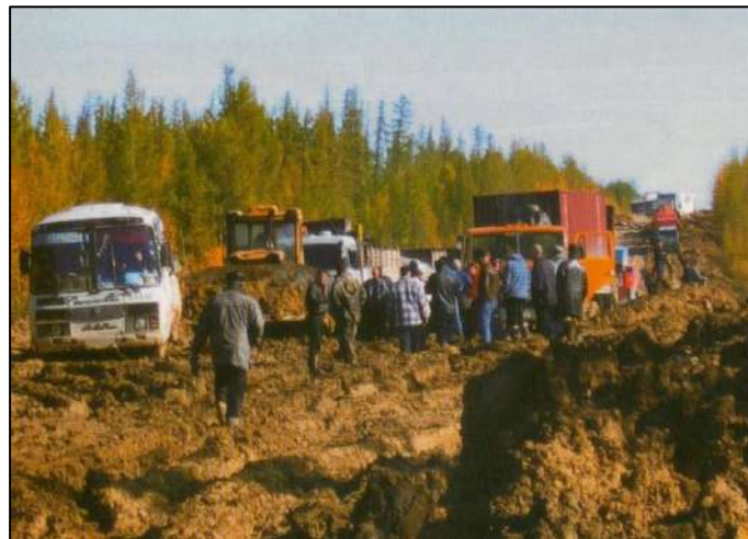
Рис. 4.2. Транспортный коллапс на федеральной трассе Невер-Якутск, из-за протаивания грунтов под дорожной насыпью. 2009 г. [15]
