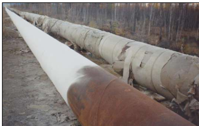
Рис. 4.4. Пульпопровод от обогатительной фабрики №3 Мирнинского ГОК в Якутии к хвостохранилищу, покрытый экспериментальной тонкослойной полимерной теплоизоляцией. 2005 г.
