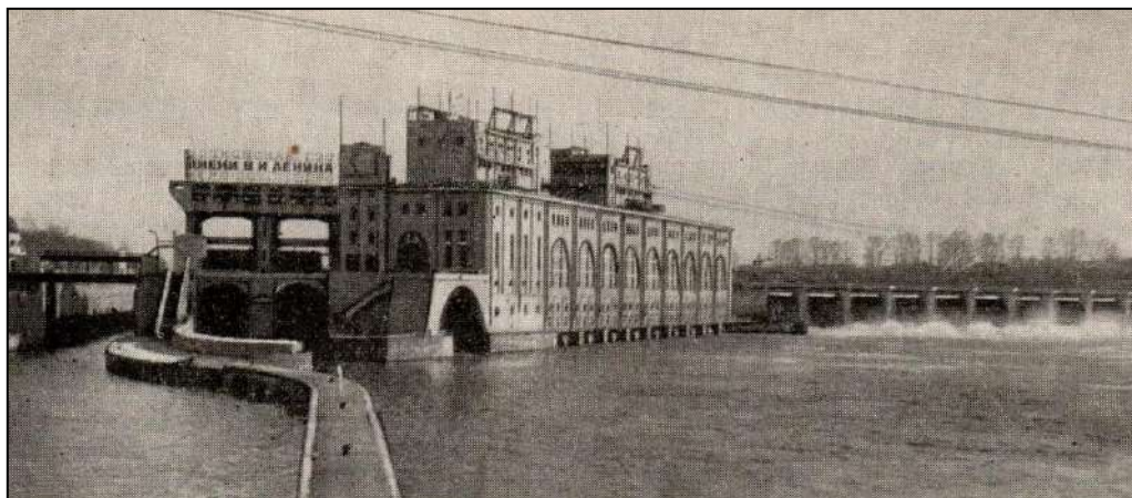
Рис. 3.14. Волховская ГЭС на р. Волхове. 1950-е гг. [150]
