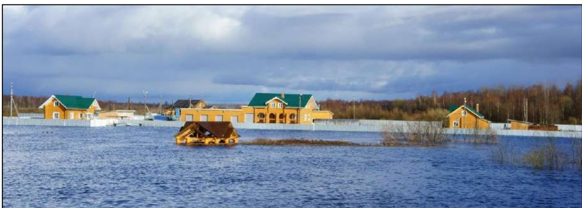
Рис. 7.5. Затопление новых дачных строений в пойме р. Сухоны половодьем 2012 г.
