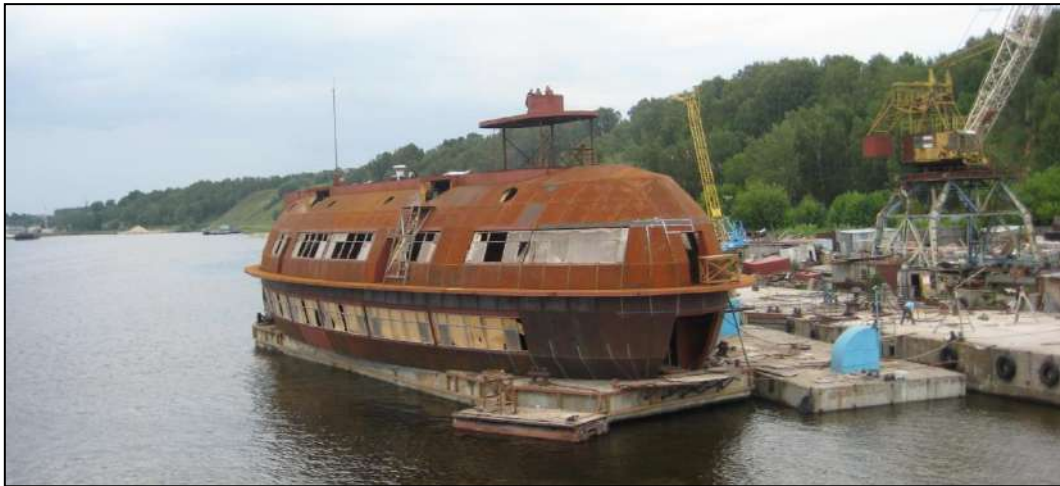
Рис. 8.8. Строительство плавучего ресторана на судоремонтном заводе в г. Городце. 2008 г.
