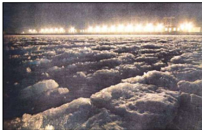
Рис. 13.9. Торошение льда на Куйбышевском водохранилище перед ГЭС, вызванное колебаниями уровня при сбросе-набросе нагрузки [108]
