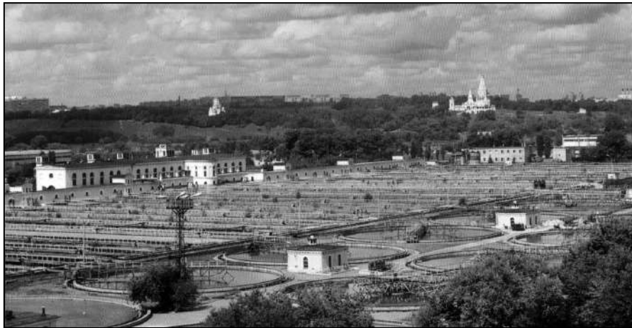
Рис. 2.6. Курьяновская станция аэрации сточных вод в г. Москве. 1988 г.
