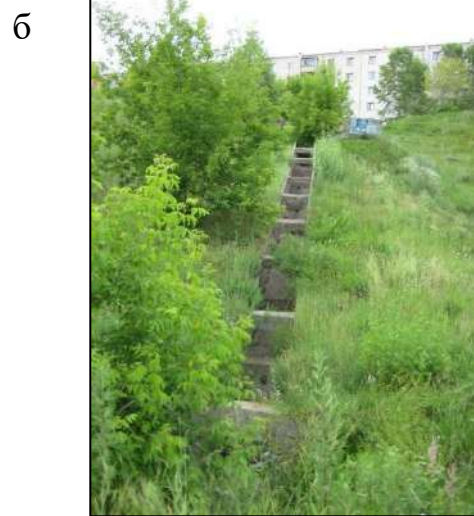
Рис. 2.8. Сброс ливневых вод: а – с правобережной части г. Воронежа в р. Воронеж, начало XX в. [719]; б – с территории г. Городца в межшлюзовой бьеф Нижегородского гидроузла на р. Волге, начало XXI в.
