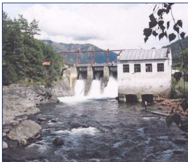
Рис. 3.21. Чемальская МГЭС на р. Чемал, притоке р. Катунь: построена в 1935 г., мощность 400 кВт, работала до 2011 г. [ http://www.chemalskayagas.ru ]
