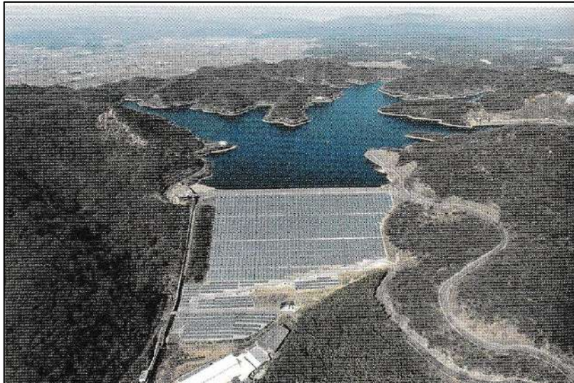
Рис. 3.28. Солнечные модули на низовом откосе плотины Котани в Японии
