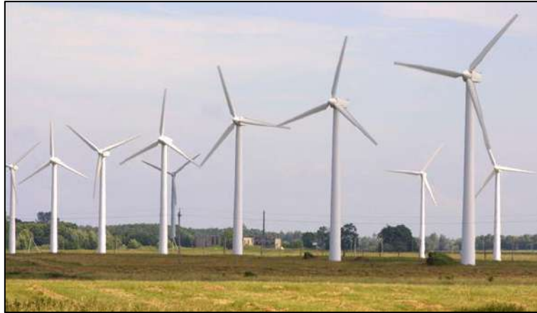
Рис. 3.23. Куликовская ветроэлектростанция в Калининградской области
