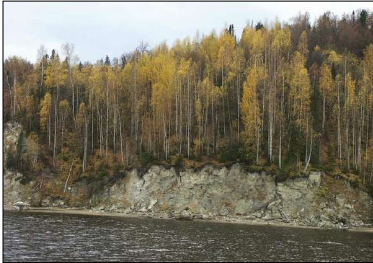
Рис. 14.10. Участок обвально-глыбового абразионного берега Камского водохранилища
