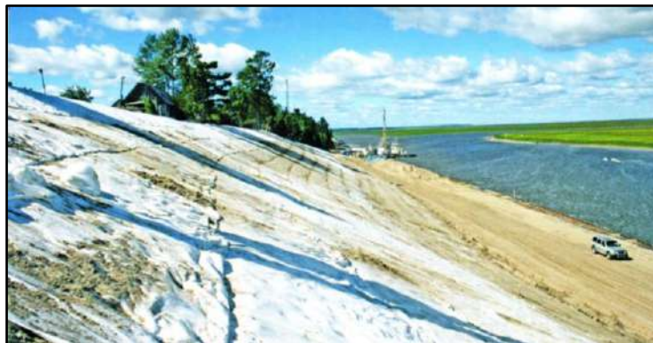
Рис. 14.2. Строительство берегоукрепления на р. Конде у пос. Междуреченский в Ханты-Мансийском АО для защиты 45 домов, «зависших» на обрыве высотой 25 м. 2005 г.
