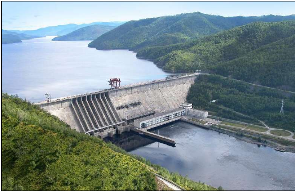
Рис. 7.9. Зейский гидроузел на р. Зее [tass.ru]
