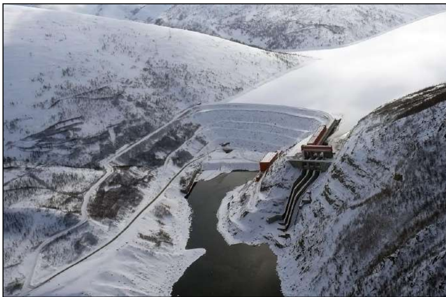
Рис. 10.4. Здание Жигулевской (Куйбышевской) ГЭС, плотина Саяно-Шушенской ГЭС, Колымский гидроузел (сверху вниз), искусно встроенные в природный ландшафт
