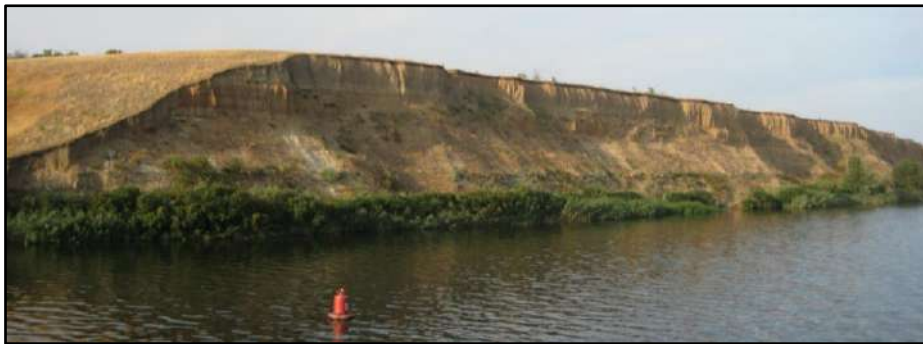
Рис. 14.62. Абразионный участок правого берега р. Дона в нижнем бьефе Цимлянского гидроузла
