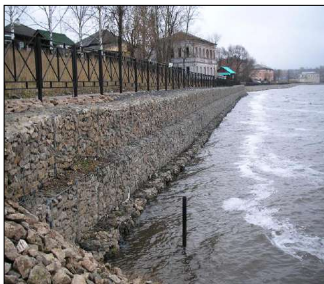
Берегоукрепительная стенка длиной 0,6 км из габионов на Камском водохранилище в г. Добрянке. 2007 г.
