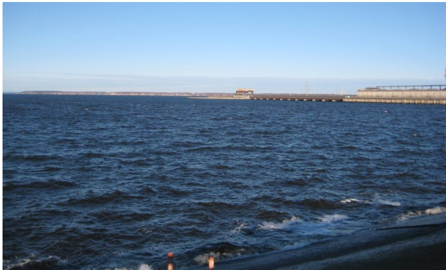
Рис. 1.7. Приплотинная часть долинного Горьковского водохранилища на р. Волге
