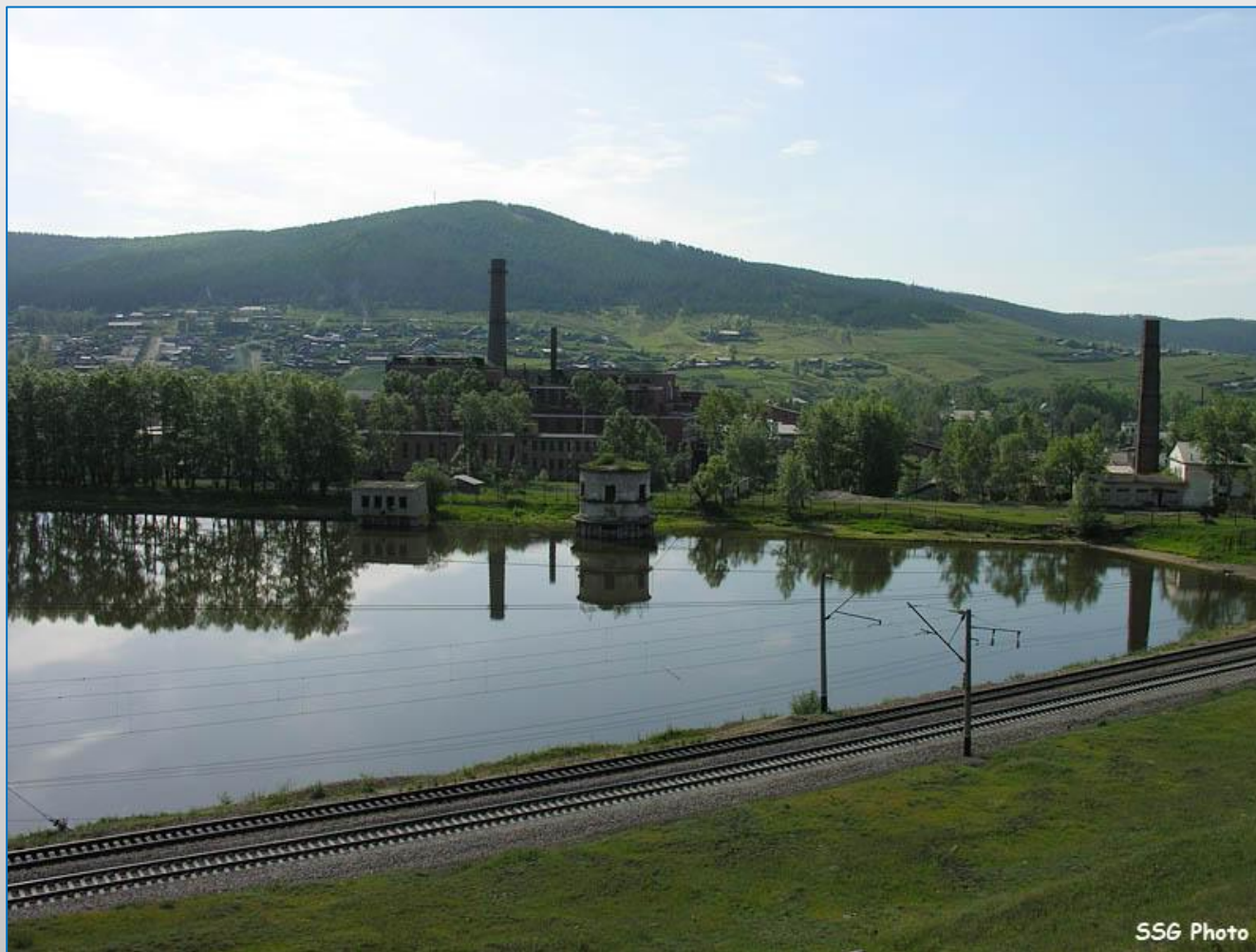
Современный вид плотины на р. Мыкырт в г. Петровске-Забайкальском с правого берега водохранилища
