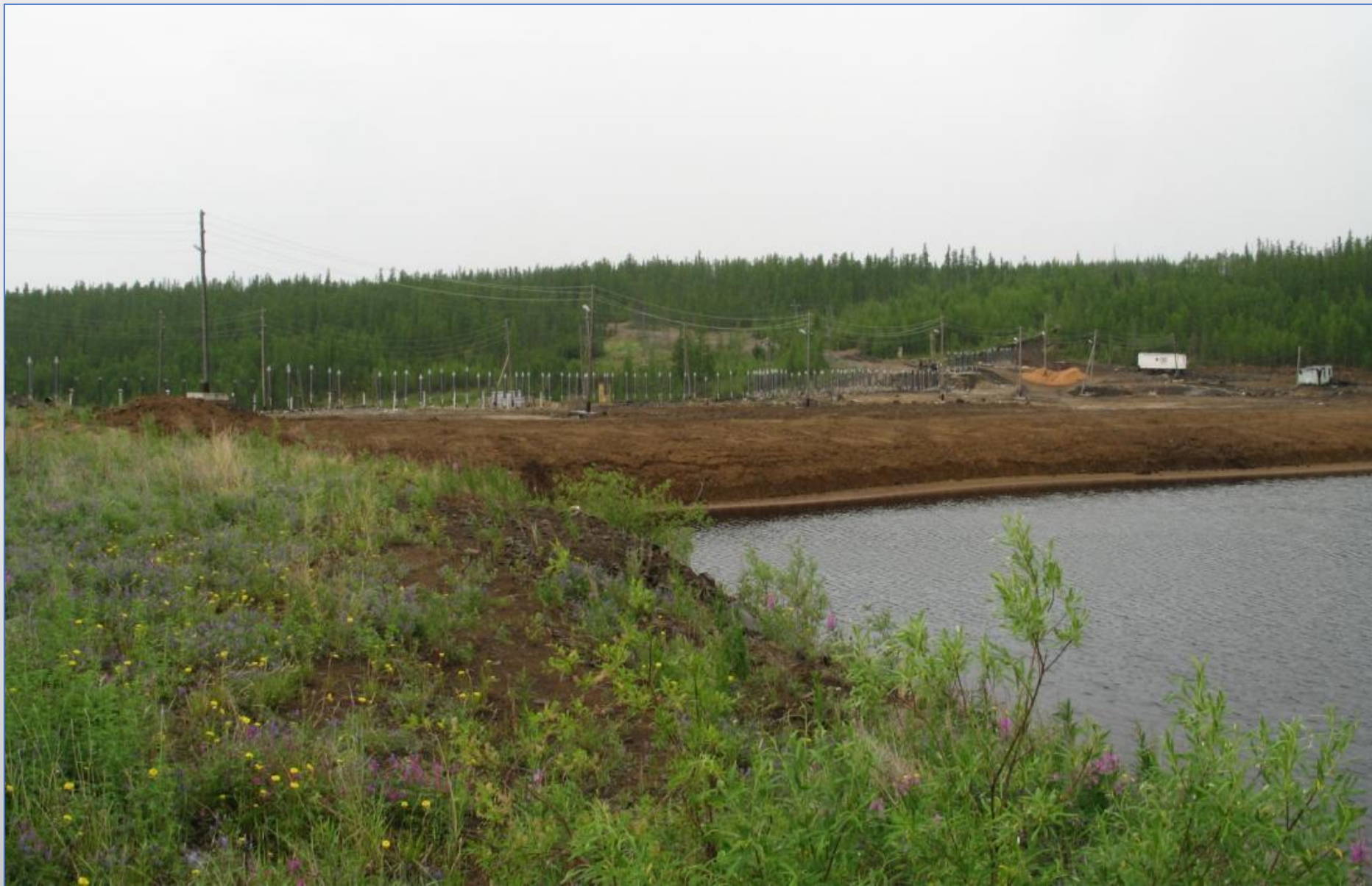
Вид плотины Иреляхского гидроузла на р. Ирелях со стороны водохранилища. 2011 г.
