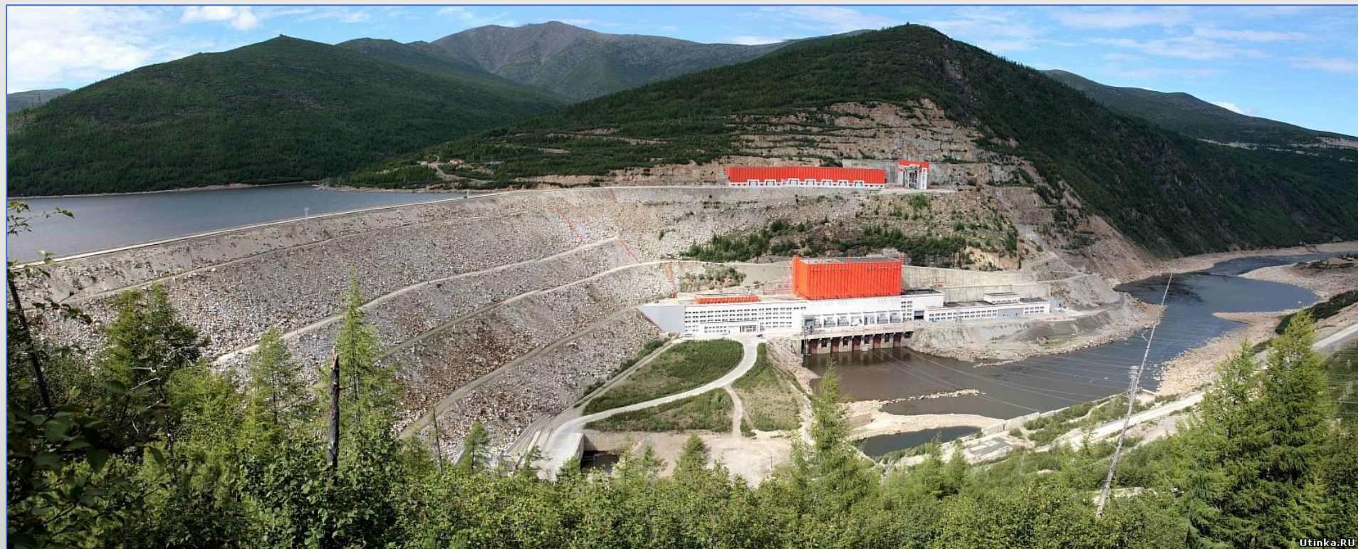
Колымский гидроузел с каменно-земляной плотиной
