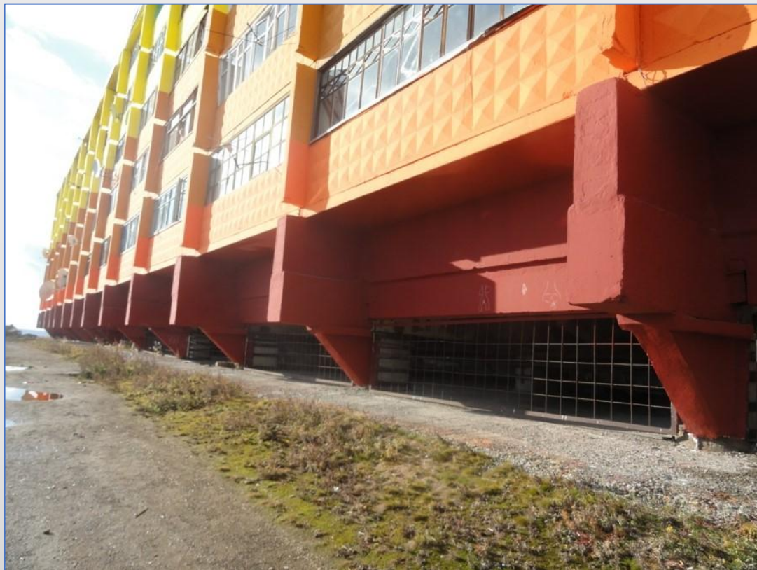
Поселок Айхал (Якутия). Дом на свайном фундаменте с проветриваемым подпольем. 2011 г.
