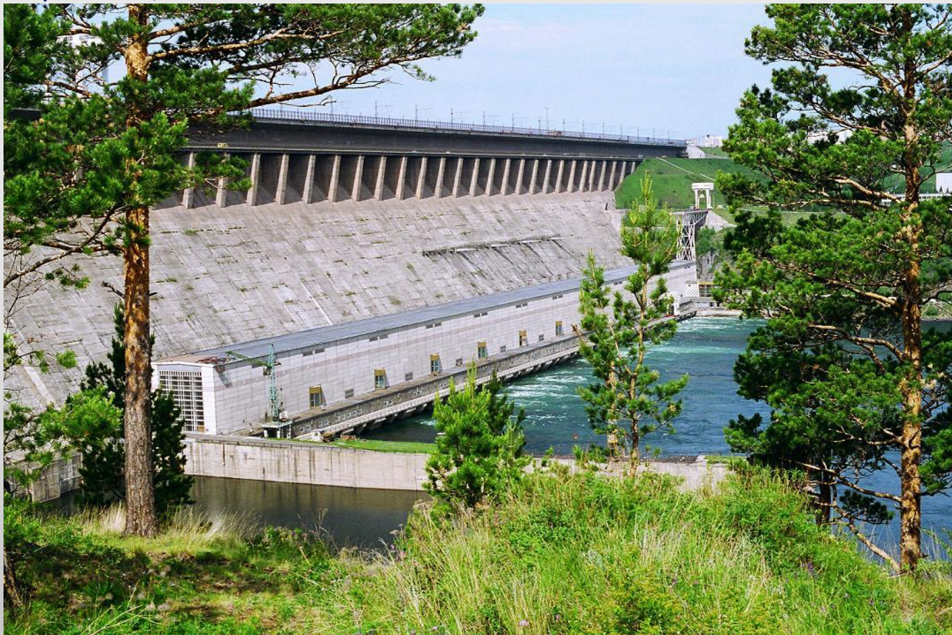
Бетонная гравитационная плотина Братской ГЭС на р. Ангаре, 125м, 1967 г. В станционной части плотина массивная, в водосливной части – с расширенными швами.
