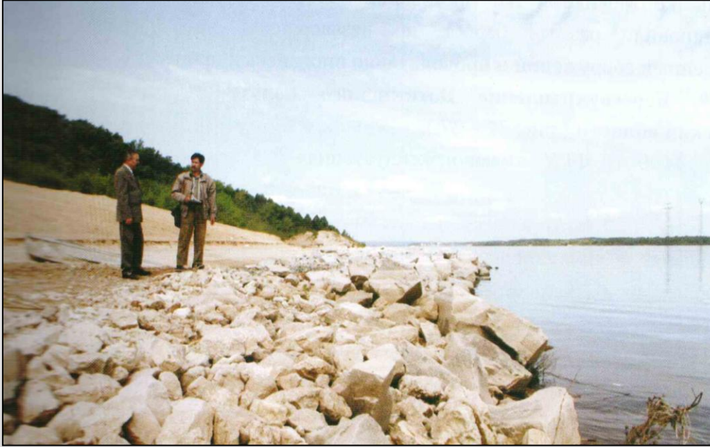
Вид берегоукрепления из каменной наброски
