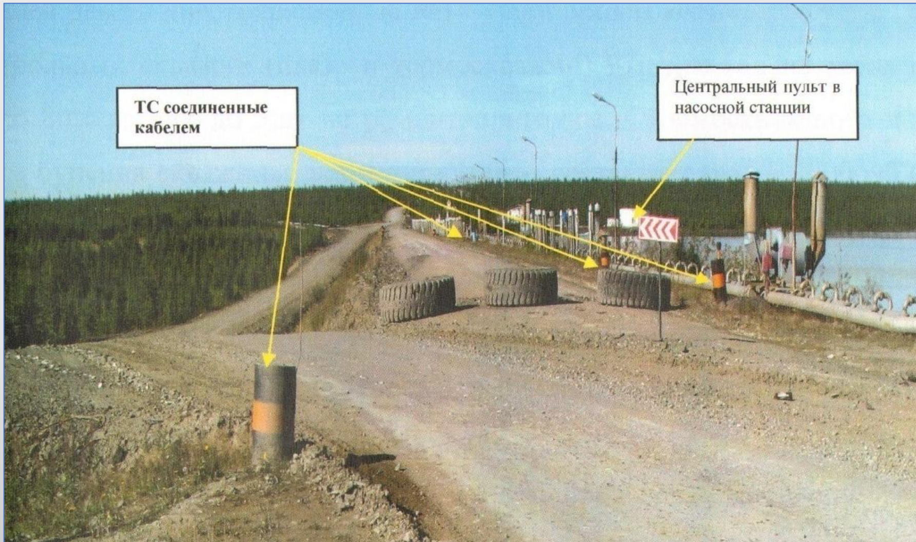
Вид на гребень плотины гидроузла на р. Ойуур – Юреге. Плотина снабжена автоматизированной системой дистанционного контроля температурного режима. 2012 г.
