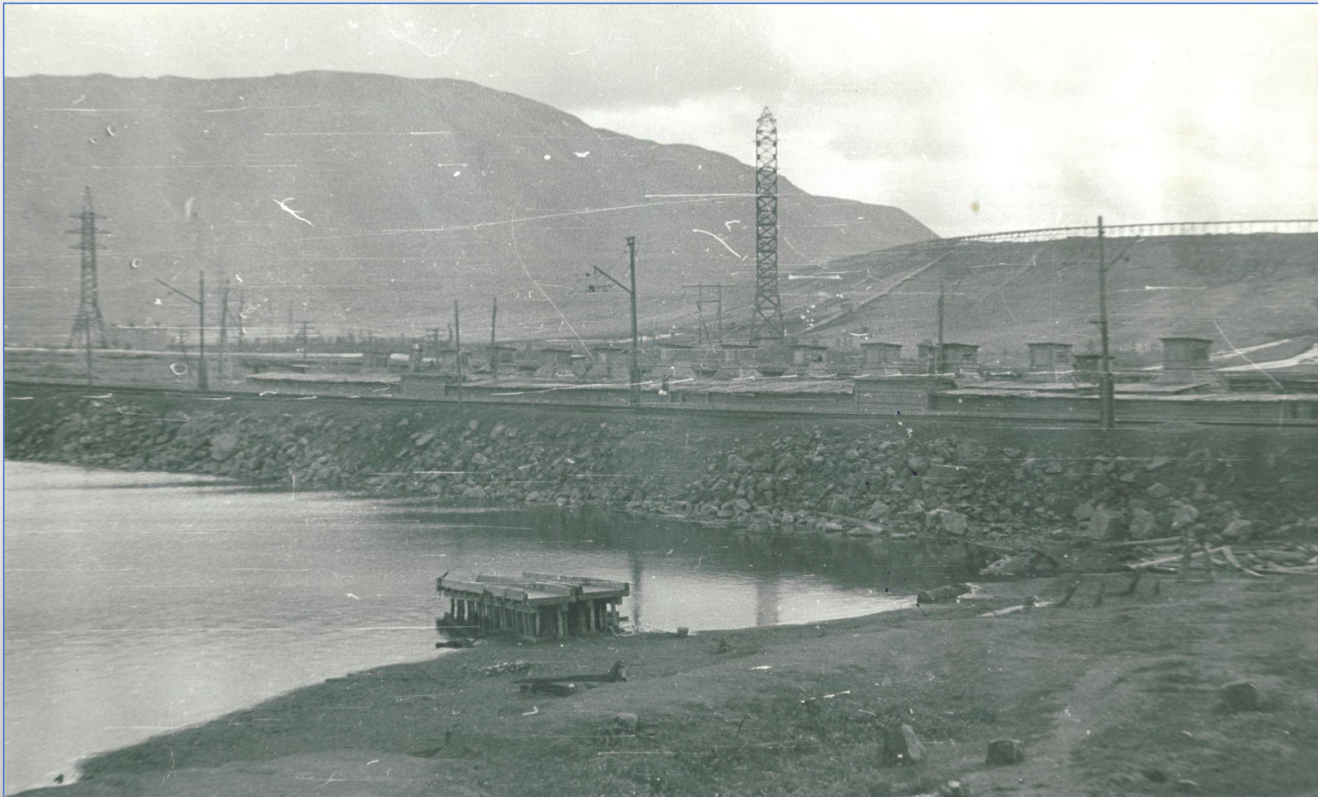
Мерзлая плотина на р. Долгая: вид с правого берега со стороны верхнего бьефа. 1971 г.
