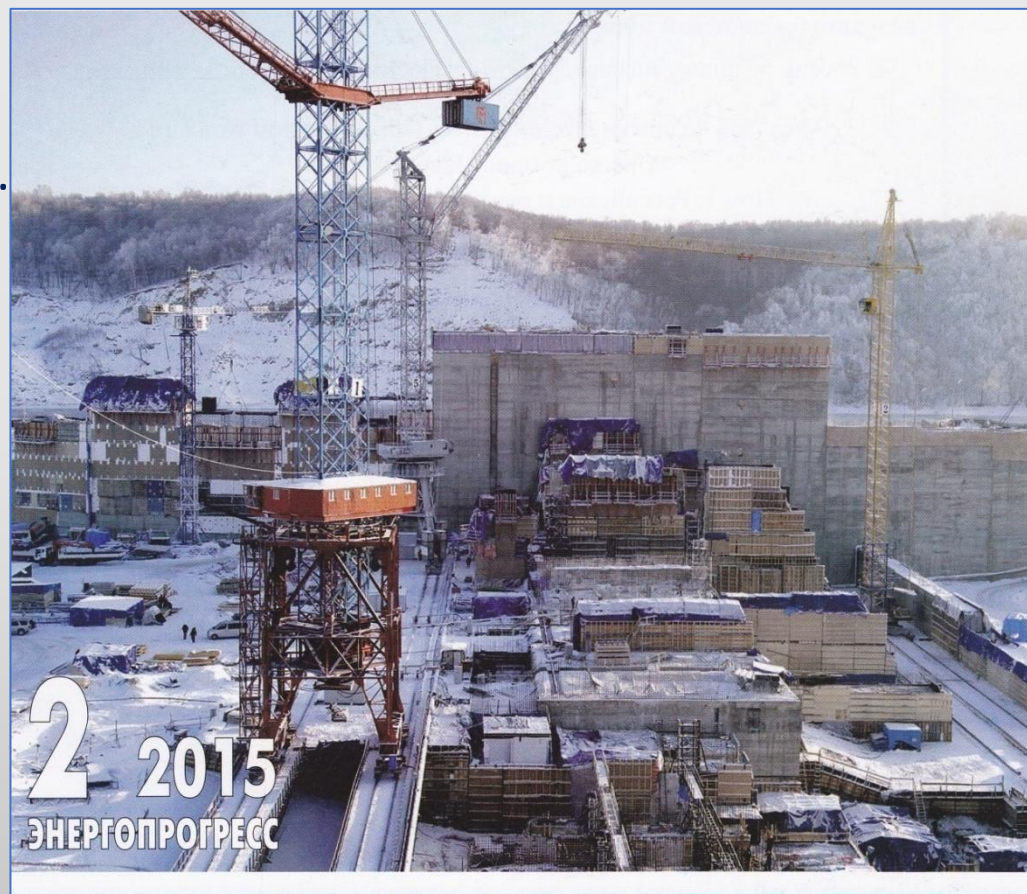
Строительство Нижнебурейской ГЭС на р. Бурея
