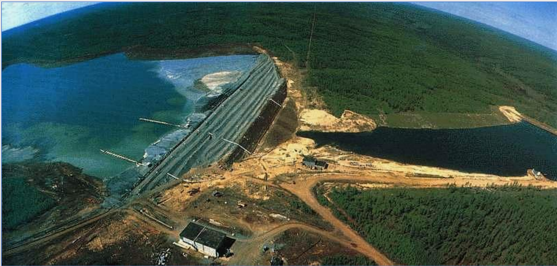
Хвостохранилище (слева) с ограждающей дамбой талого типа и водоперехватывающее водохранилище (справа) фабрики №1 Мирнинского ГОК в Якутии. 2005 г.
