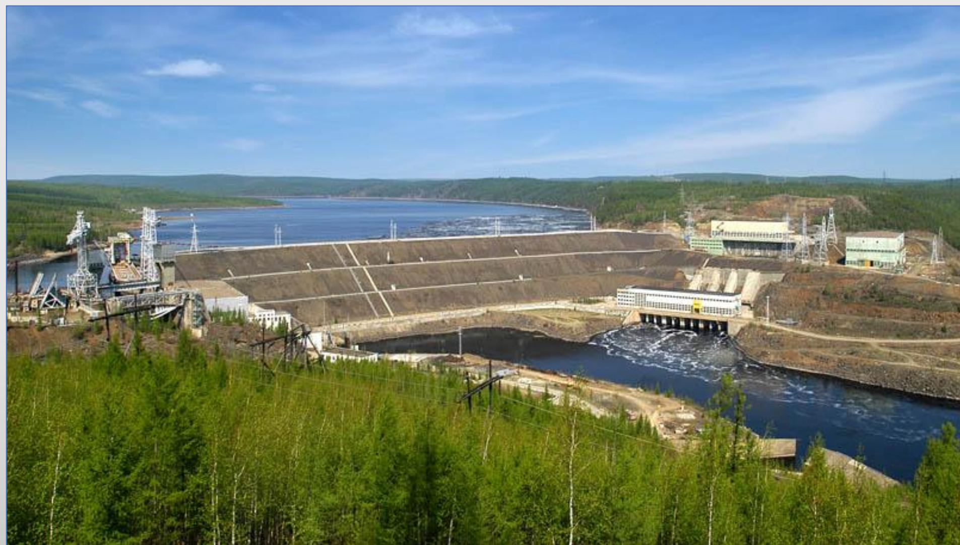
Вилюйский гидроузел на р. Вилюй с каменно-земляной плотиной
