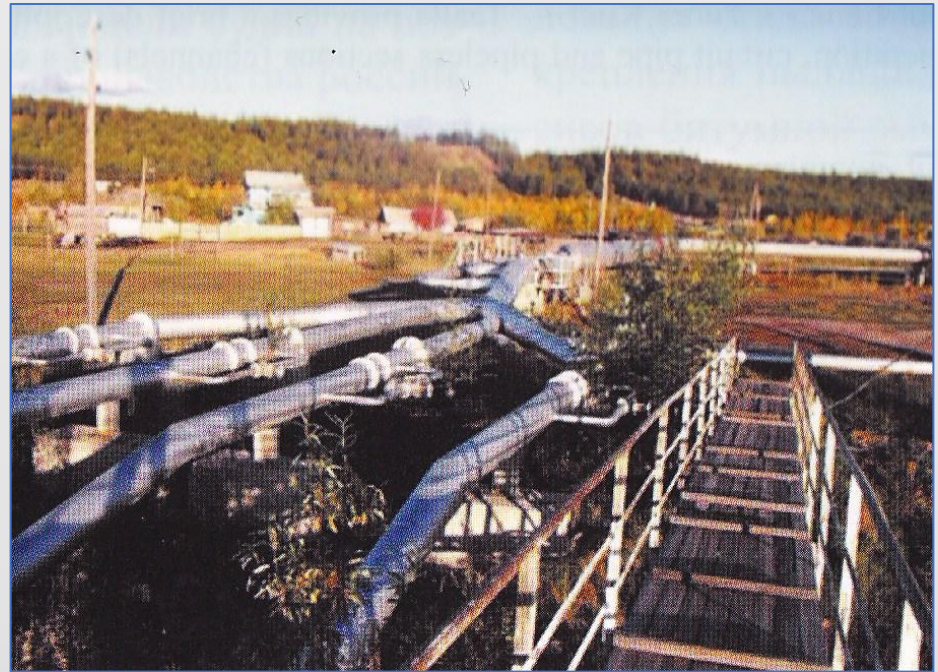
Четыре трубопровода от насосной станции входят в один основной водовод
