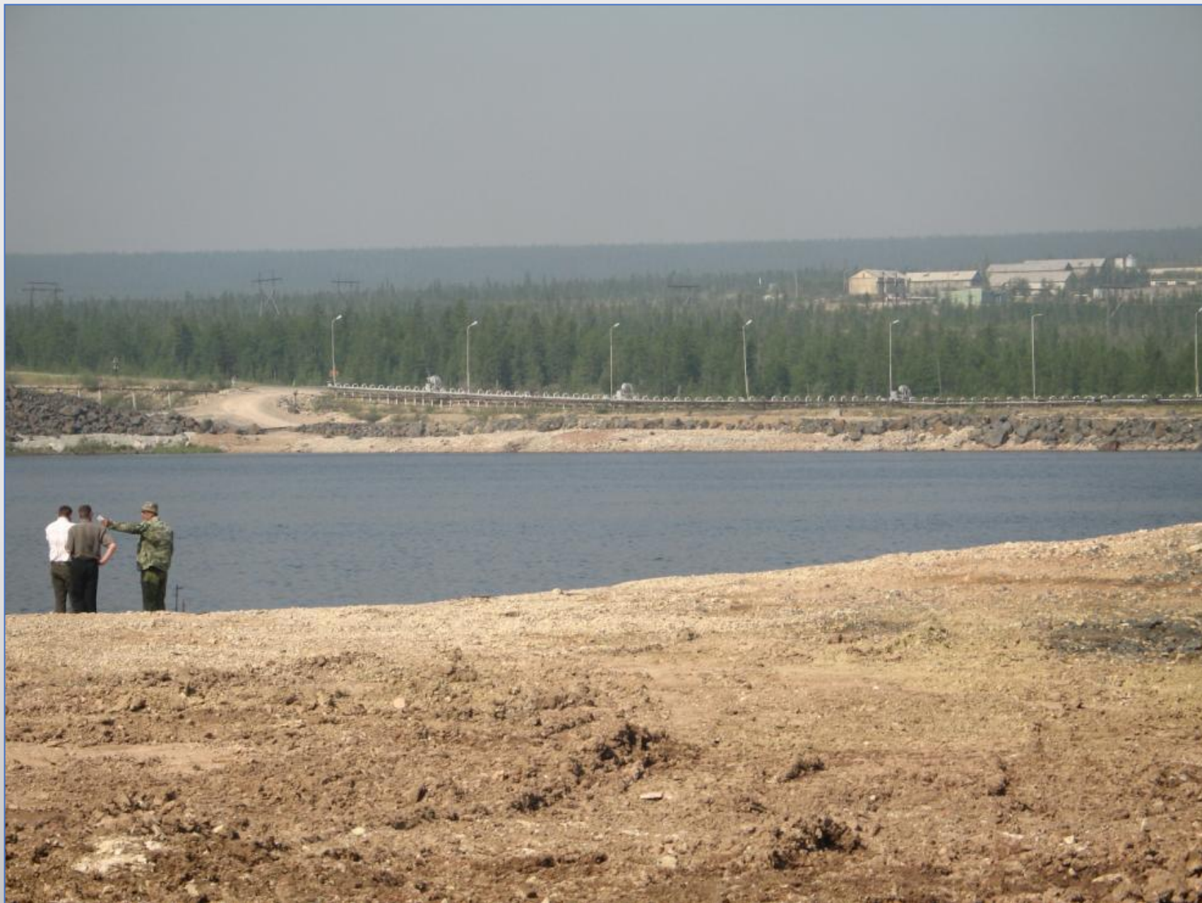
Вид плотины Сытыканского гидроузла на р. Сытыкан со стороны водохранилища. 2011 г.
