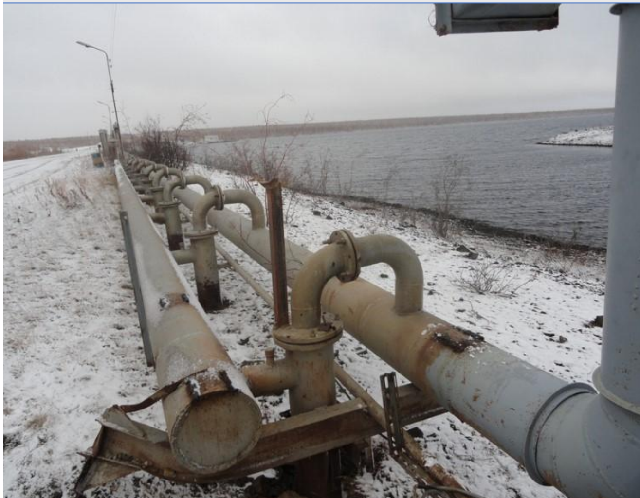
Вид системы с гребня плотины
