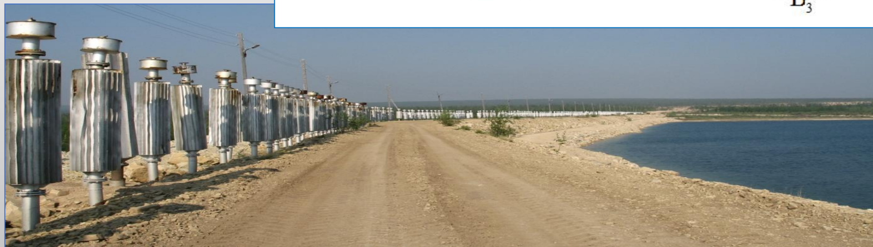
Земляная насыпная плотина с мерзлотной завесой, образующая водоперехватывающее водохранилище (маневровую емкость) обогатительной фабрики №12 Удачинского ГОК в Якутии
