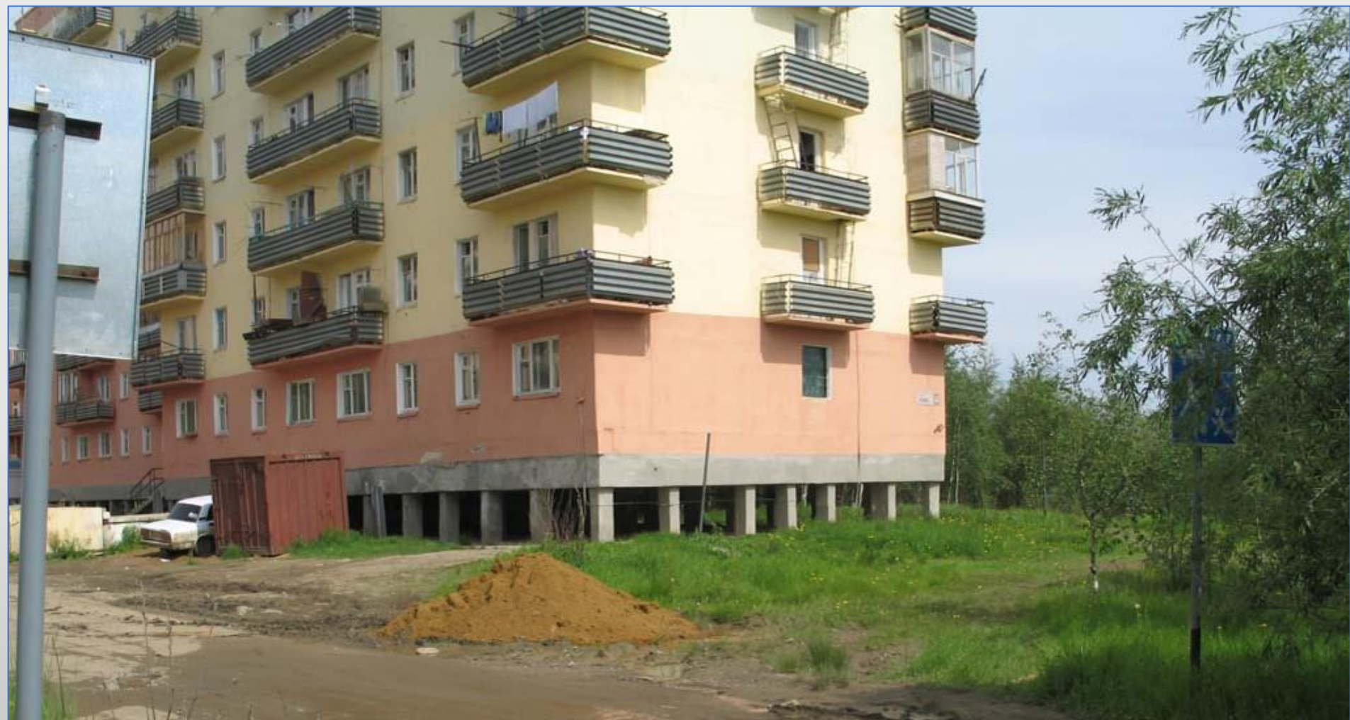
Город Мирный. Дом на сваях, вмороженных в грунт, с проветриваемым подпольем. 2011 г.
