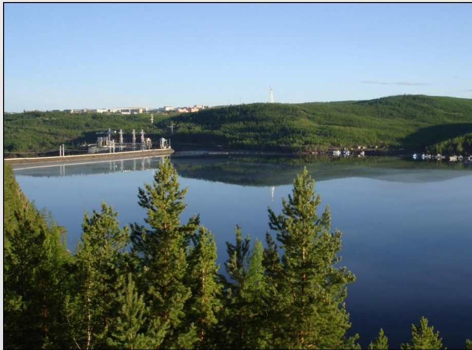
Вид с левого берега на приплотинную часть водохранилища
