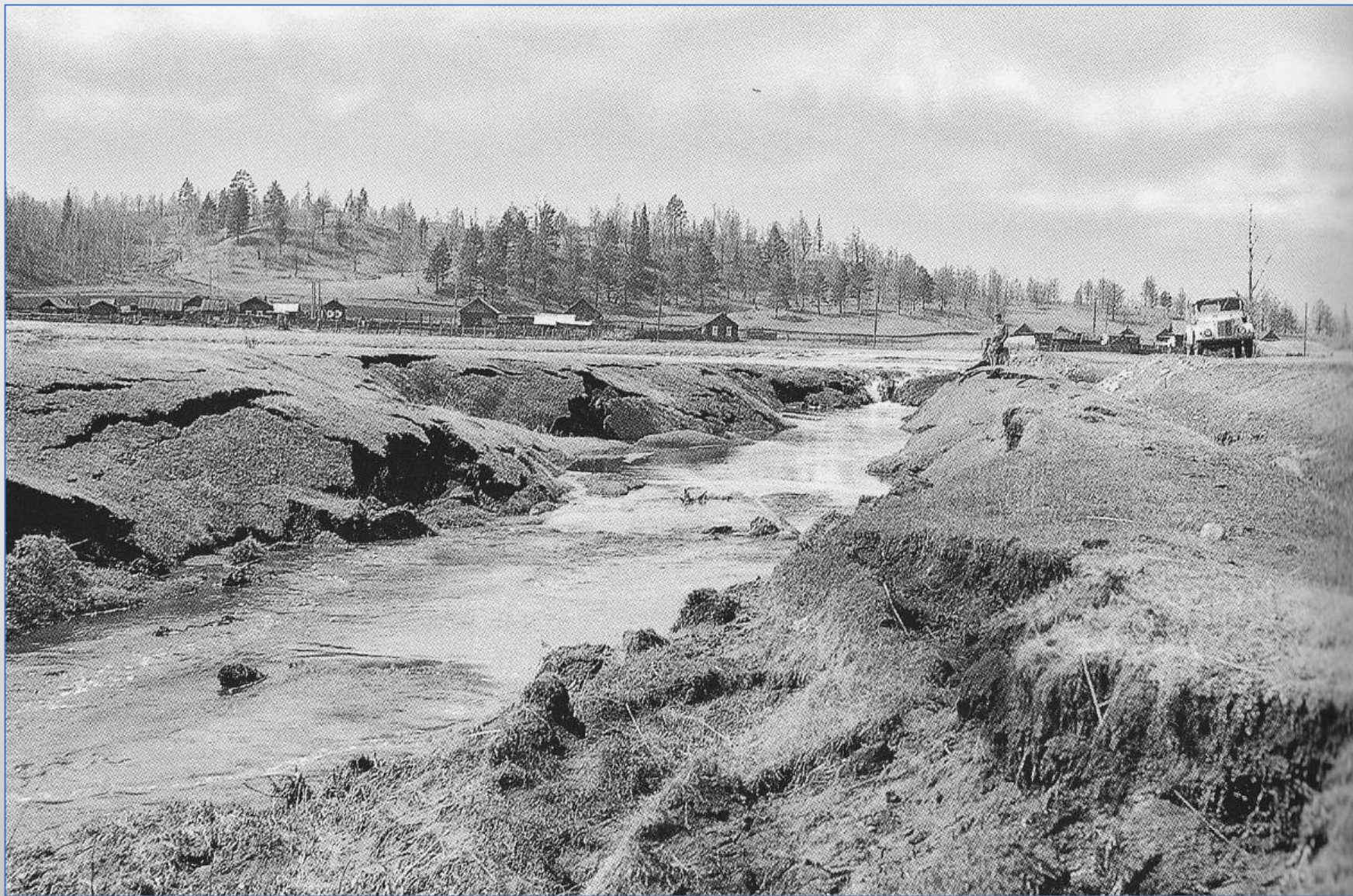
Эрозионно-термокарстовый провал на участке долины р. Тибельти у автодороги Култук – Монды в Южной Якутии
