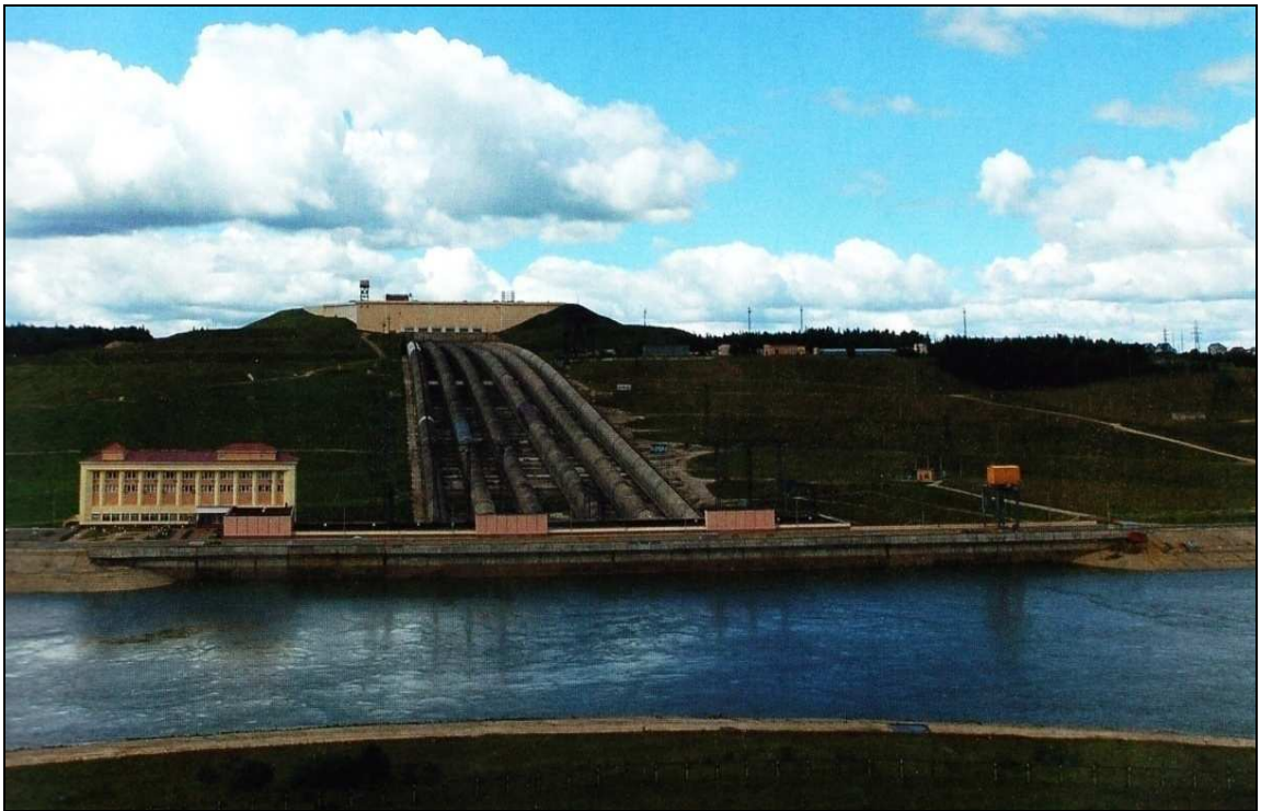
Рис. 52. Вид на нижний бассейн, здание станции, напорные водоводы Загорской ГАЭС
