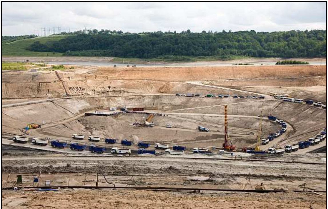
Рис. 53. Котлован верхнего бассейна Загорской ГАЭС-2 в период Строительства
