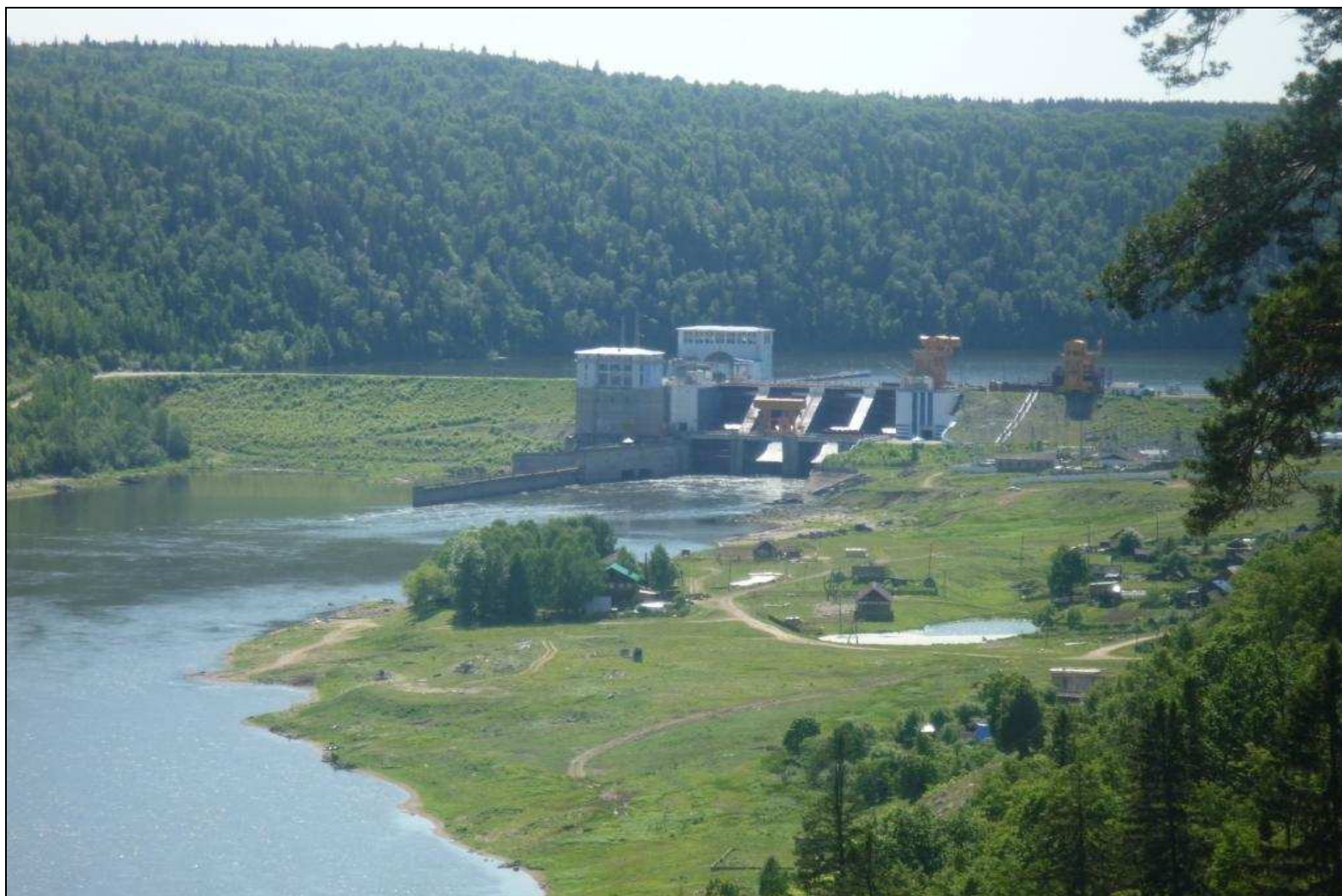
Рис. 57. Панорама Павловской ГЭС на р. Уфе с нижнего бьефа
