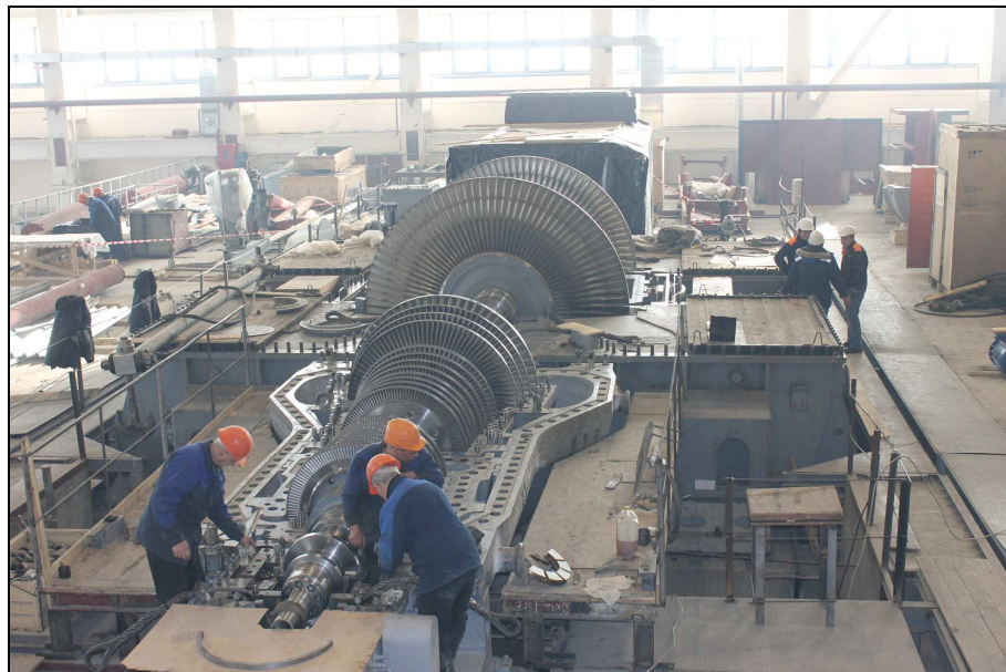
Рис. 19. Газовая турбина Уренгойской ГРЭС в процессе монтажа
