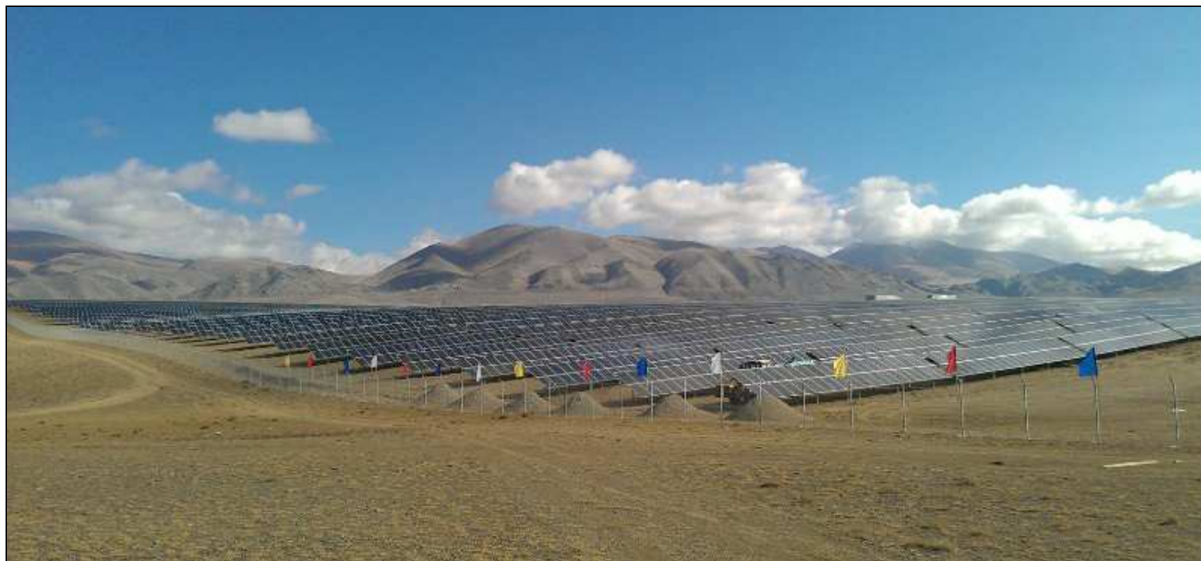
Рис. 88. Бугульчанская солнечная электростанция в Башкирии: построена в 2015 г.; на площади 27 га установлены фотоэлектрические элементы, выдающие мощность 5 МВт. До 2018 г. в Башкирии планируют построить СЭС суммарной мощностью 59 МВт
