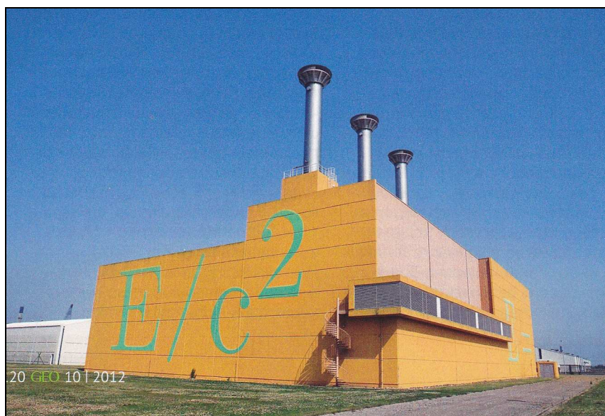
Рис. 34. Наземное хранилище радиоактивных отходов в промзоне Флиссинген – Ост на юго-западе Голландии с бетонными стенами толщиной 1,7 м способное выдержать землетрясение силой 6,5 баллов [68]
