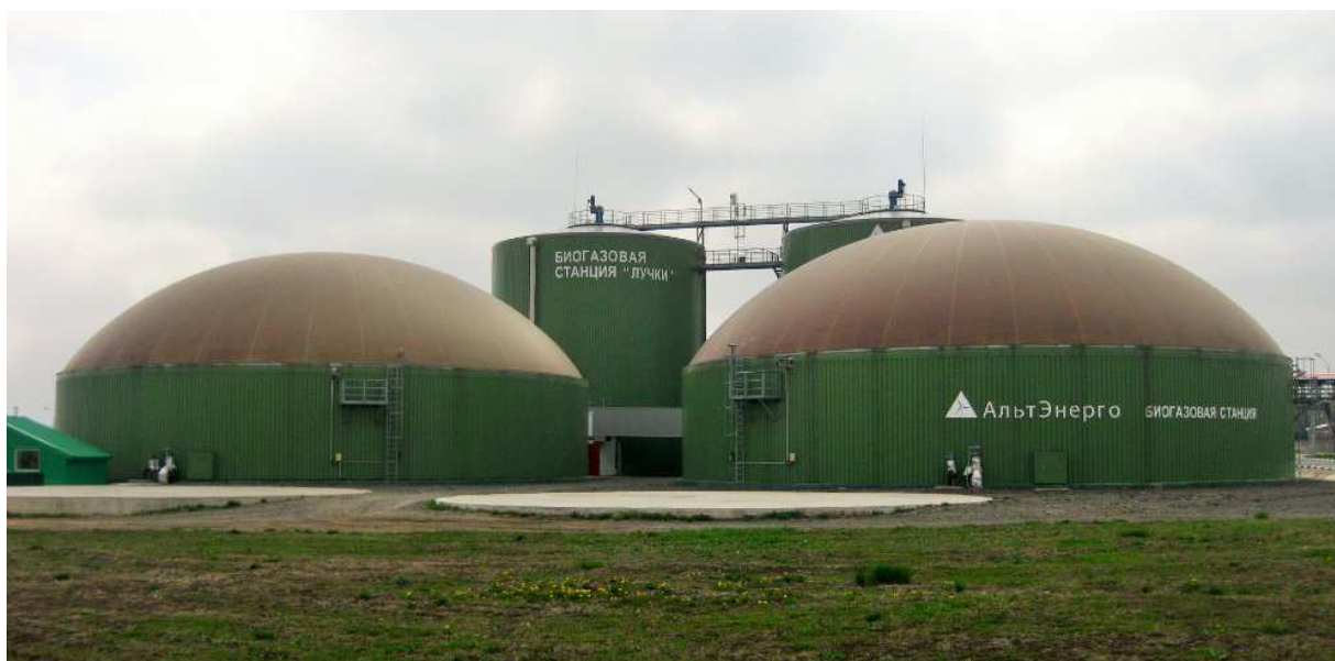
Биогазовая станции «Лучки» в белгородской области мощностью 3,6 МВт
