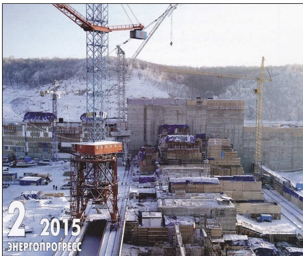
Рис. 66. Строительство Нижнебурейской ГЭС на р. Бурее
