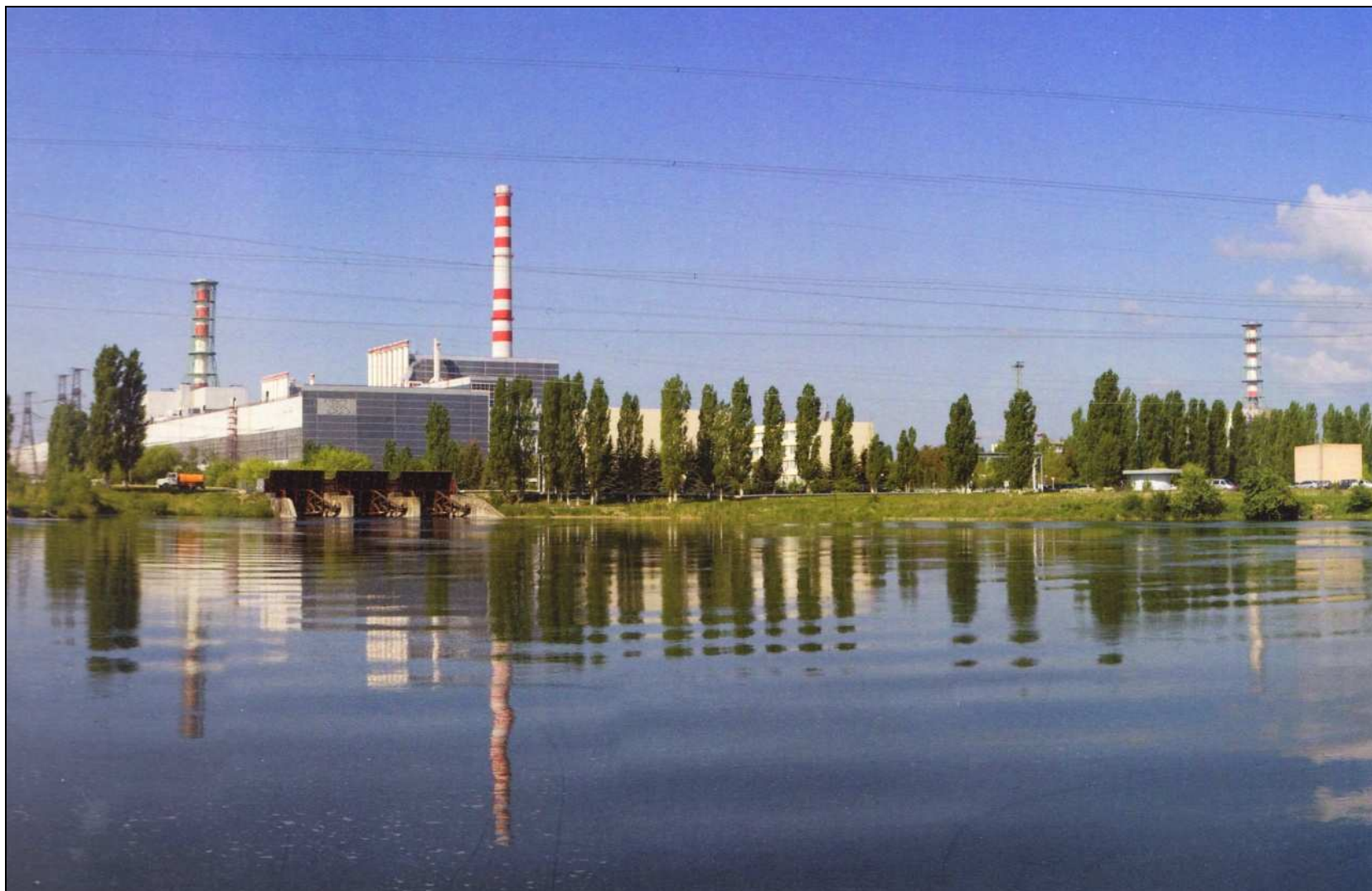
Рис. 26. Наливное водохранилище Курской АЭС в пойме р. Сейм (приток р. Десны, впадающей в р. Днепр): введено в эксплуатацию вместе с первым блоком АЭС в 1976 г.; полная емкость 94,6 млн м 3 ; площадь зеркала 21,46 км 3 ; наполняется водой из реки
