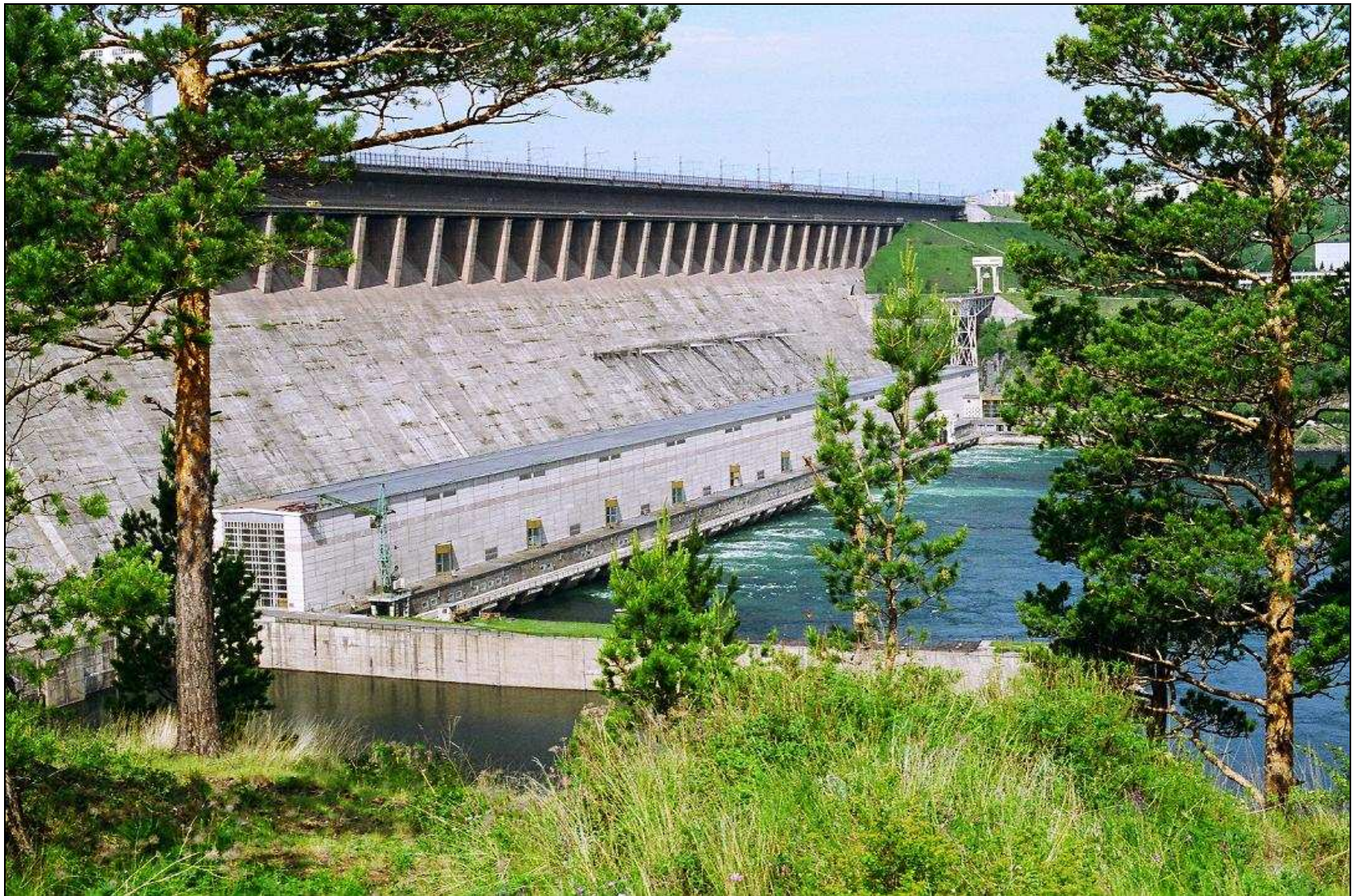
Рис. 47. Вид со стороны нижнего бьефа на станционную часть бетонной плотины и приплотинное здание Братской ГЭС
