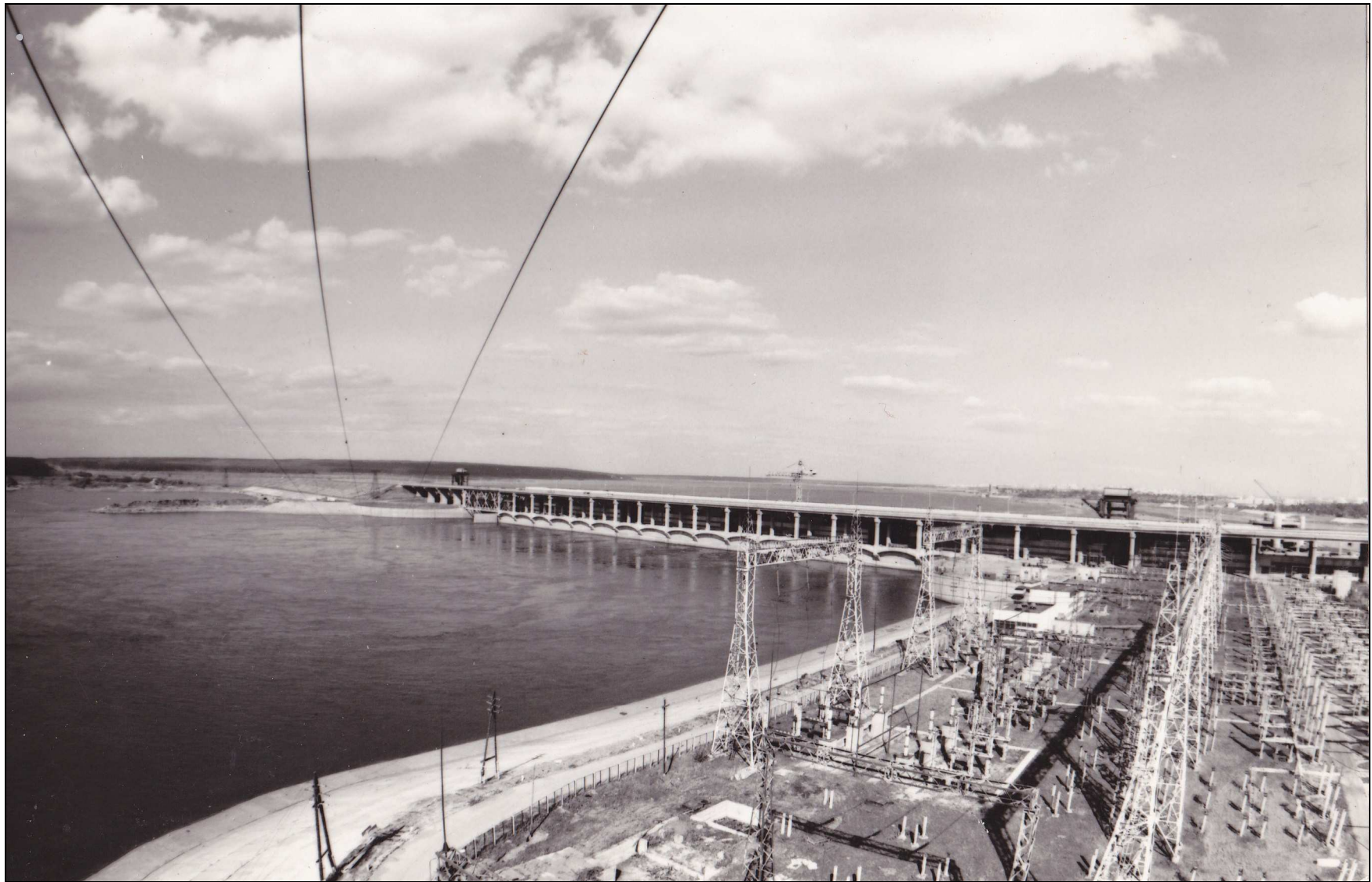
Рис. 44. Нижнекамская гидроэлектростанция на р. Каме, вид с нижнего бьефа
