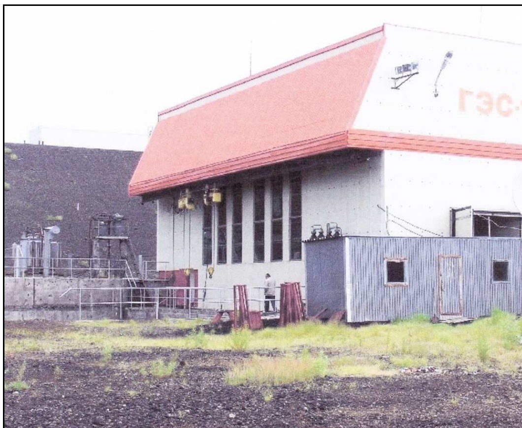
Рис. 74. Подпорная плотина и здание МГЭС №1 Толмачевского каскада гидроэлектростанций на Камчатке
