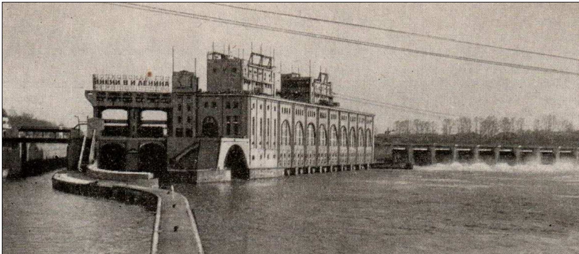
Рис. 42. Русловая Волховская ГЭС на р. Волхове, построенная по плану ГОЭЛРО в 1926 – 1928 гг. Фото 1950 –х гг.
