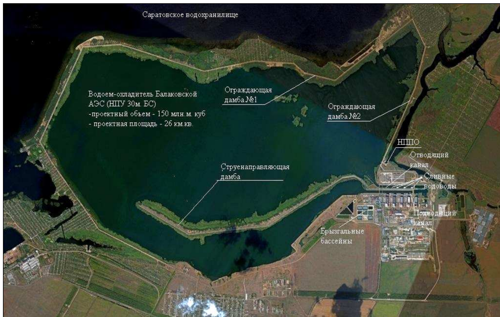
Рис. 27. План наливного водоема-охладителя Балаковской АЭС (космический снимок): водоем образован из отгороженной дамбой части Саратовского водохранилища на р. Волге площадью 26 км 2 , объемом 150 млн м 3 ; подпитывается водой из р. Березовки
