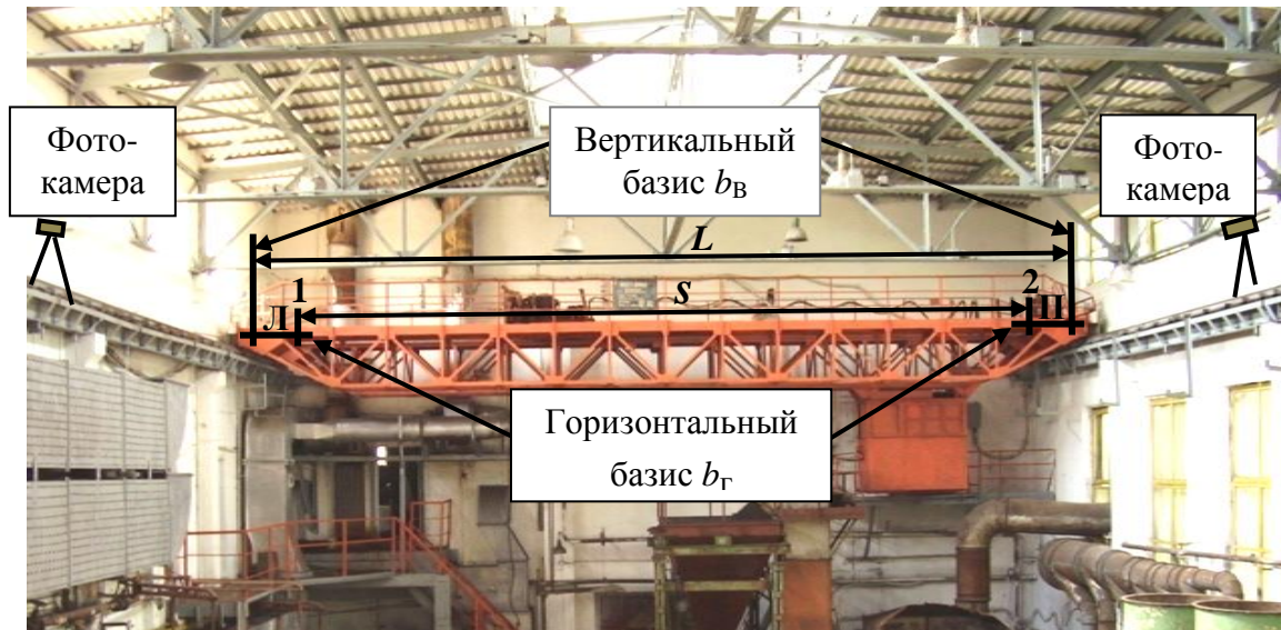
Рис. 63. Мостовой кран с марками 1, 2 и горизонтальными и вертикальными базами
