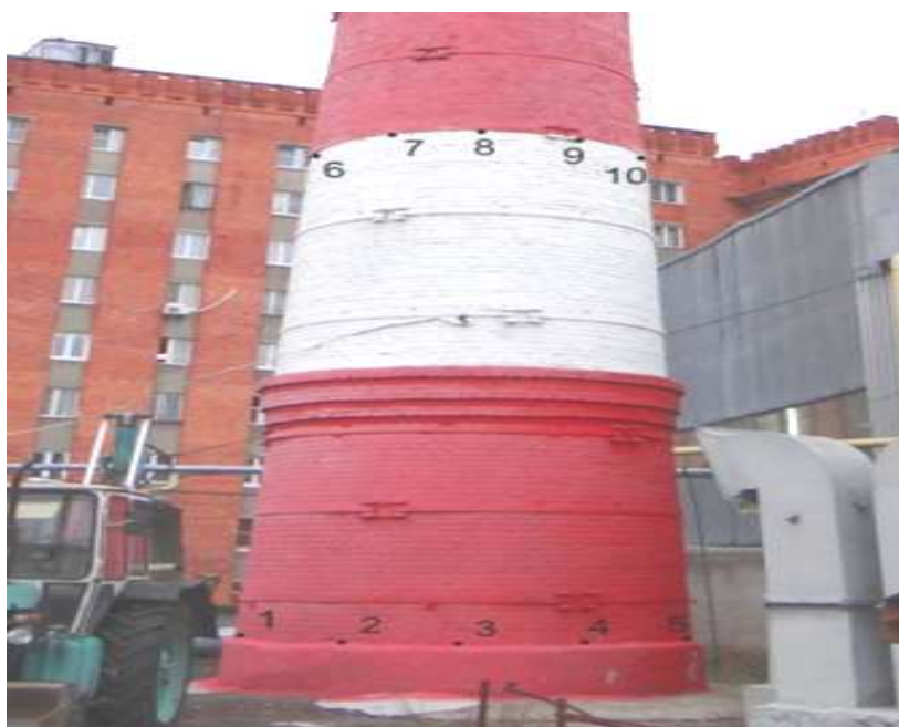
Рис. 49. Схема расположения наблюдаемых точек на дымовой трубе
