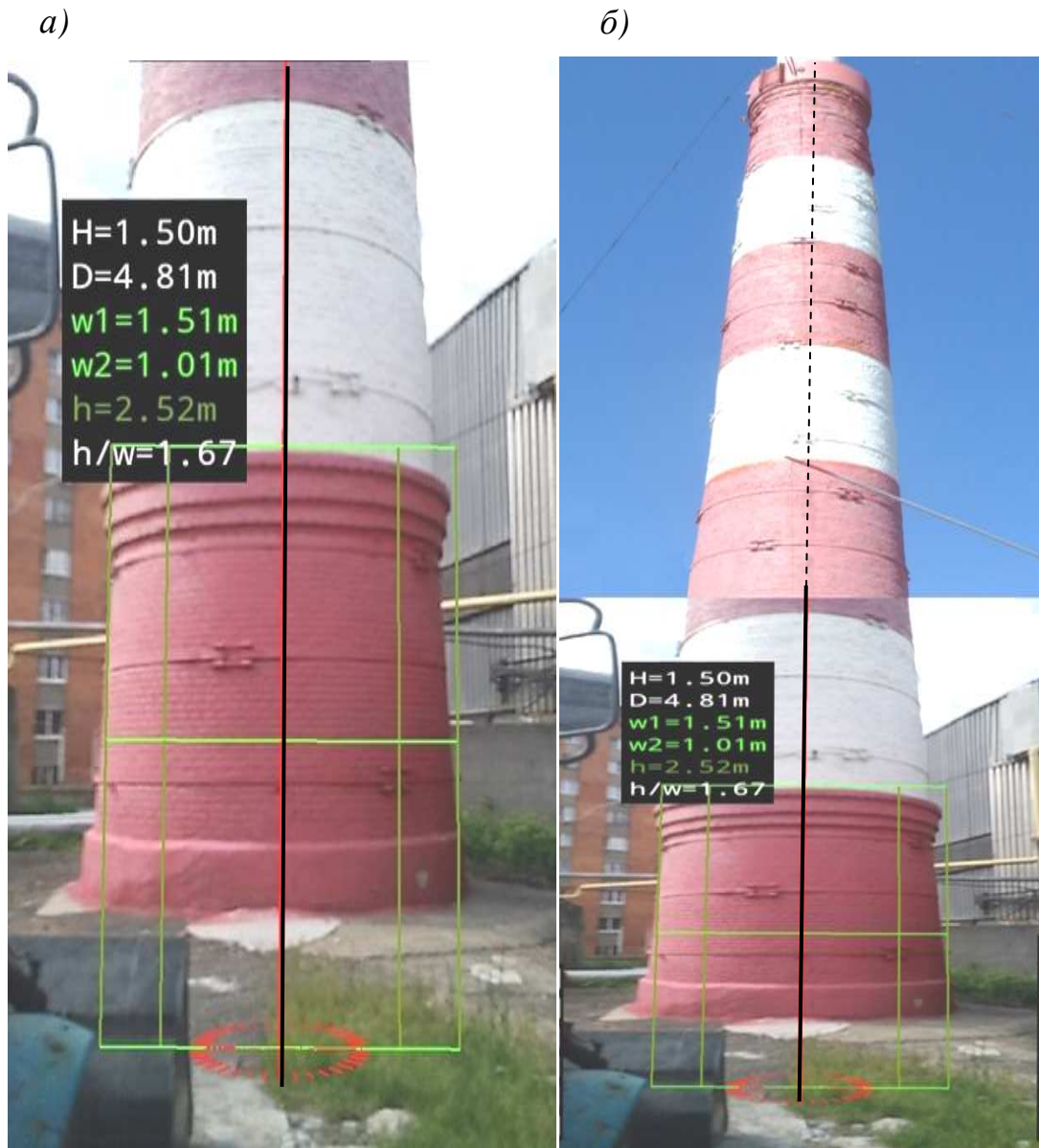
Рис. 103. Фотография трубы с Plumb-bob (а) и полной референтной прямой (б)
