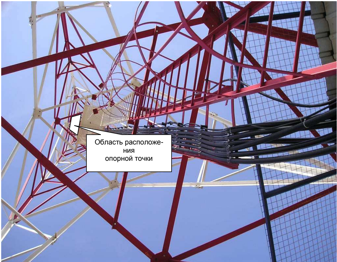
Рис. 132. Фотография башни (вид снизу)
