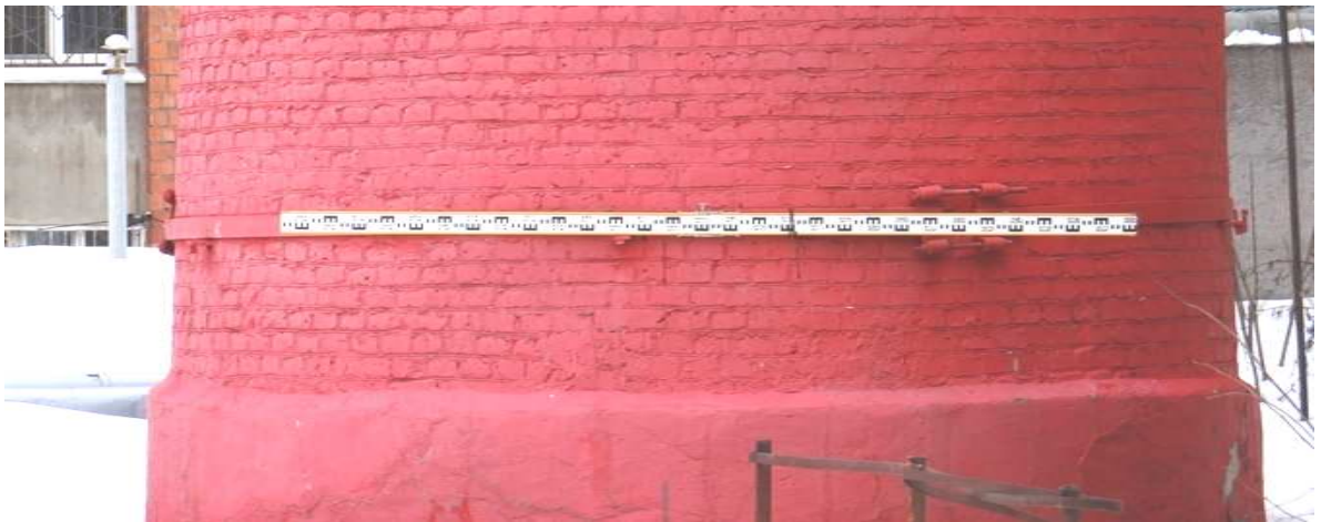
Рис. 92. Фотография трубы с расстояния 3 м
