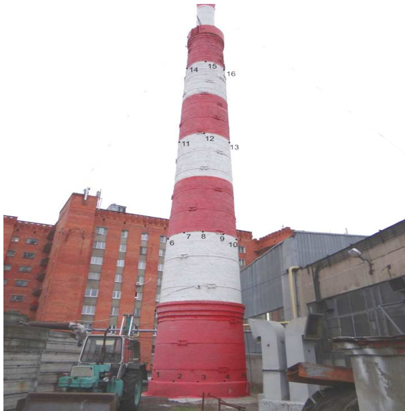
Рис. 122. Схема координатных измерений дымовой трубы
