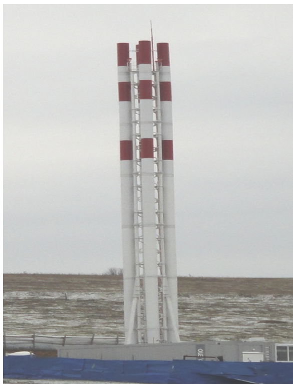
Рис. 88. Фотография четырёхугольного куста дымовых труб
