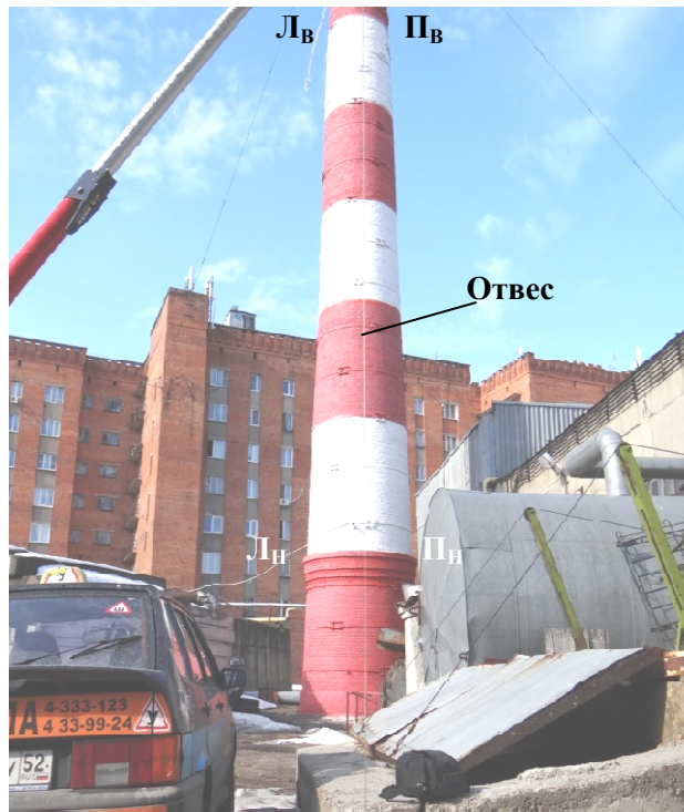
Рис. 74. Схема использования отвеса в качестве референтной прямой
