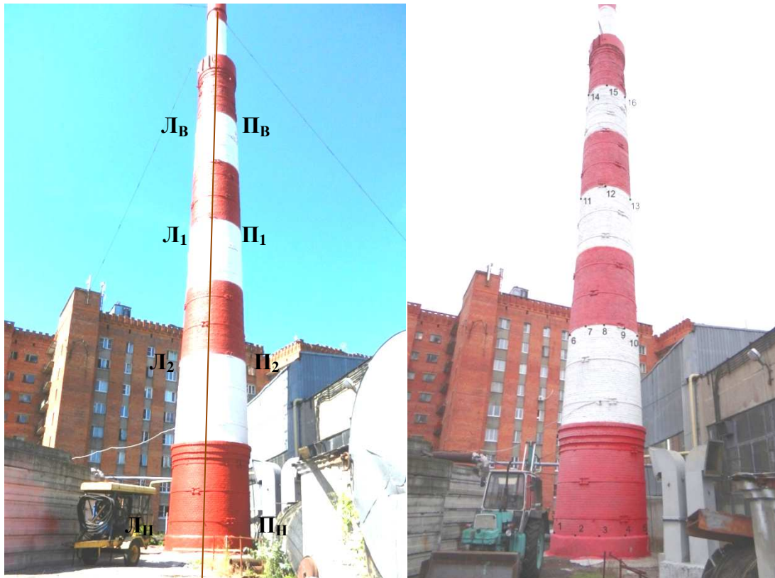
Рис. 71. Формирование вертикальной референтной прямой (а) и схема координатных измерений трубы (б)
