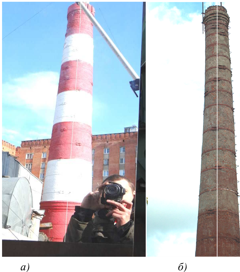
Рис. 63. Фотография изображения трубы в плоском зеркале (а) и искривлённой трубы (б)
