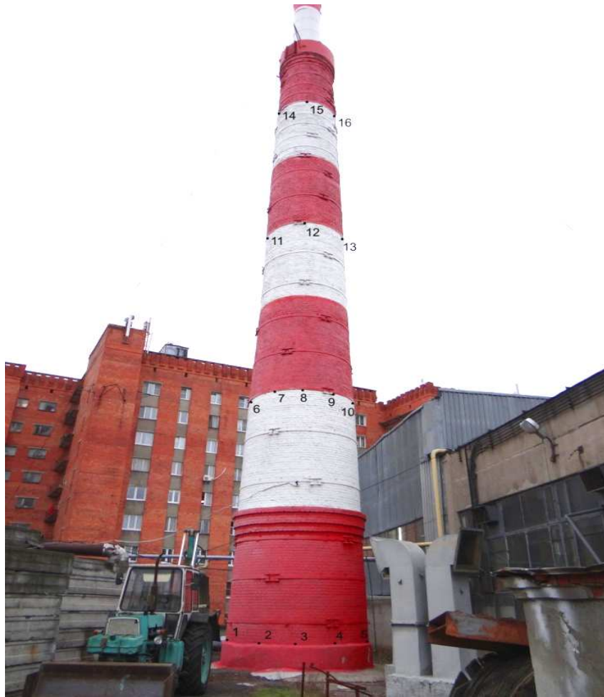
Рис. 35. Схема расположения точек при координатных измерениях дымовой трубы
