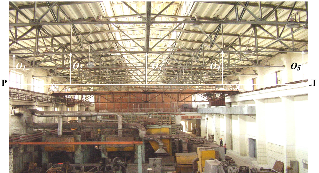
Рис. 91. Схема фотографического способа определения стрелы прогиба
