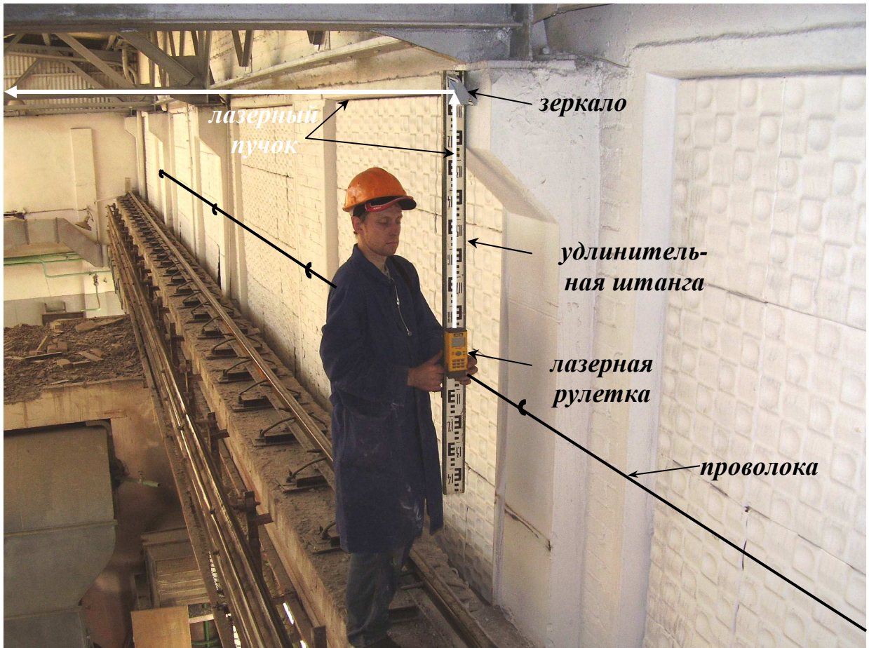
Рис. 76. Пример использования ЛЗУ для измерения расстояния между колоннами в пролёте на уровне их оголовка
