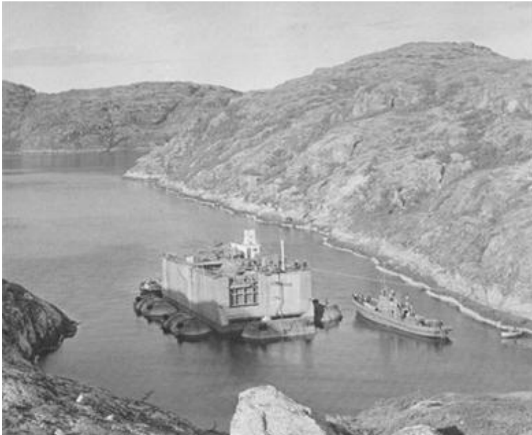
Рис.3. Здание ПЭС транспортируется к месту установки
