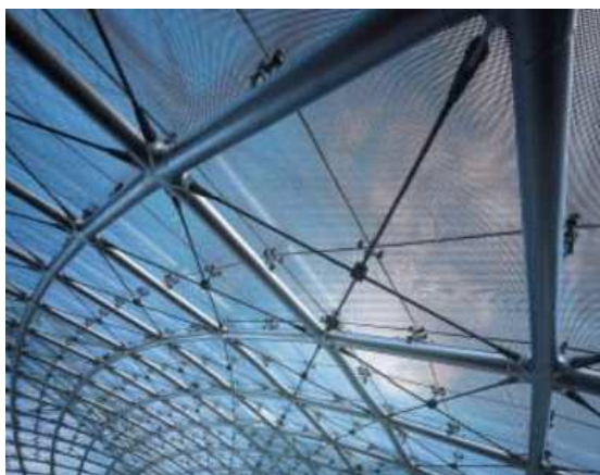
Рис. 2. Узлы купола
