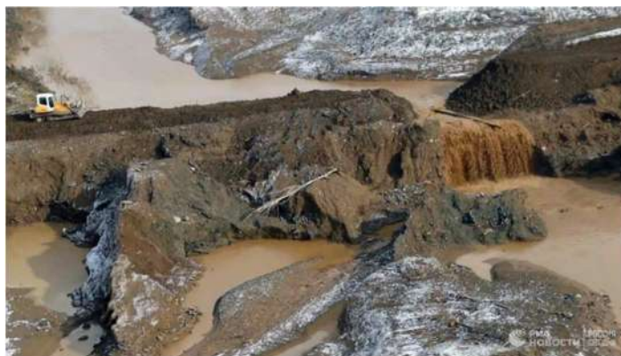
Рис. 2. Прорыв дамбы технологического водоема в районе села Щетинкино Красноярского края
