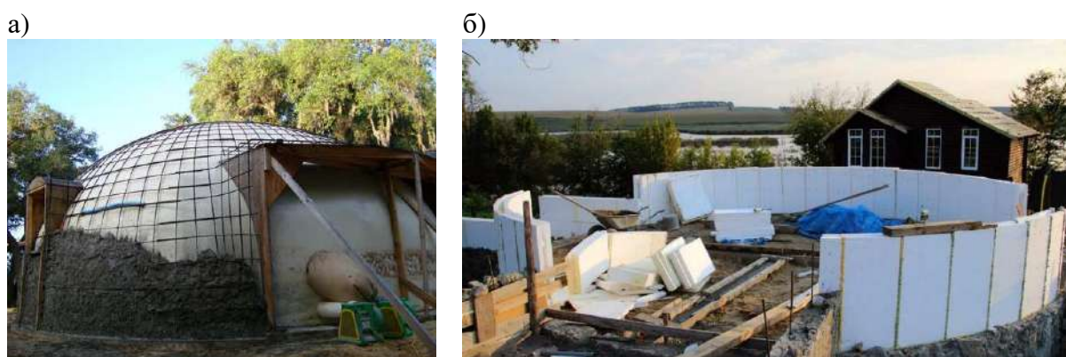
Рис. 3. Технологии возведения монолитных купольных сооружений: а – с использованием пневмоопалубки и метода торкретирования; б – с использованием несъемной опалубки.
