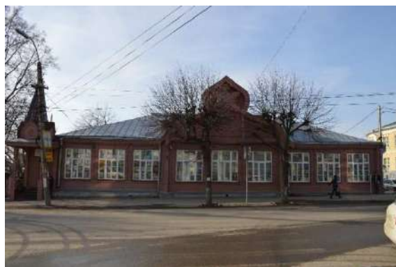
Рис. 4 Здание начального училища второй мужской гимназии, Праволыбедская 28. Фото 2021 г.
