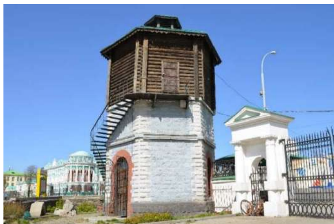
Рис. 1. Водонапорная башня на Плотинке в Екатеринбурге
