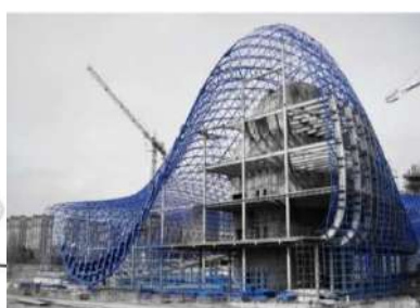
Рис. 8. Конструкция оболочки
