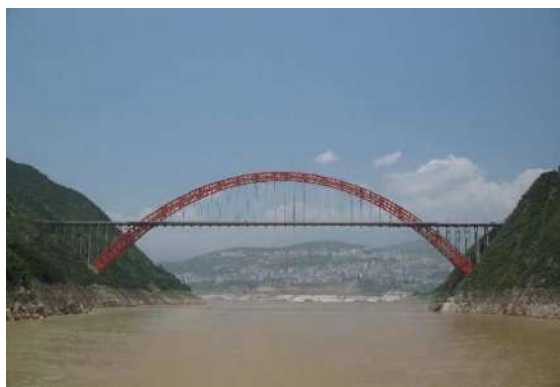
Рис. 2. Трубобетонный арочный мост Chongqing Wushan Bridge
