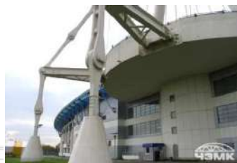
Рис. 3. Опорный узел
