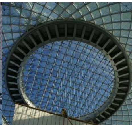
Рис. 3. Узлы купола
